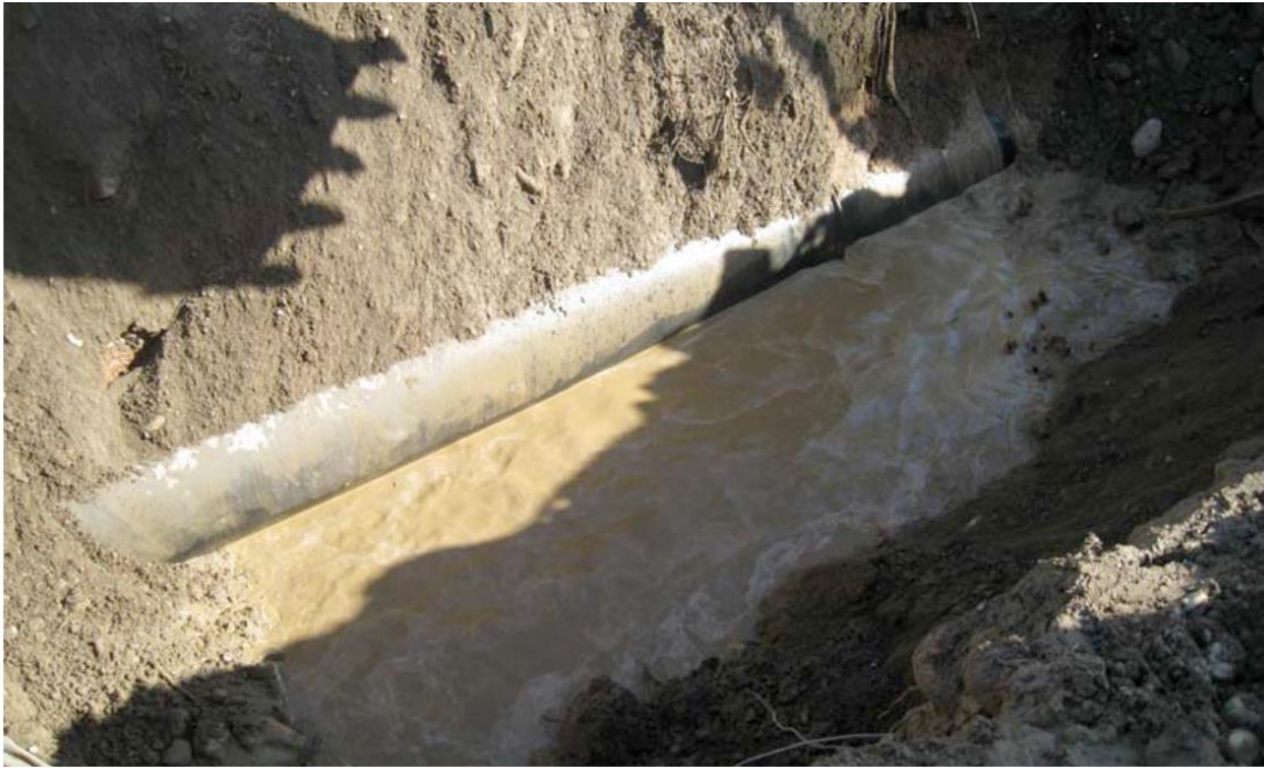
Φωτογραφία 48. Εικόνα του εκτεθειμένου σωλήνα που υπερχειλίζει το νερό του ποταμού
