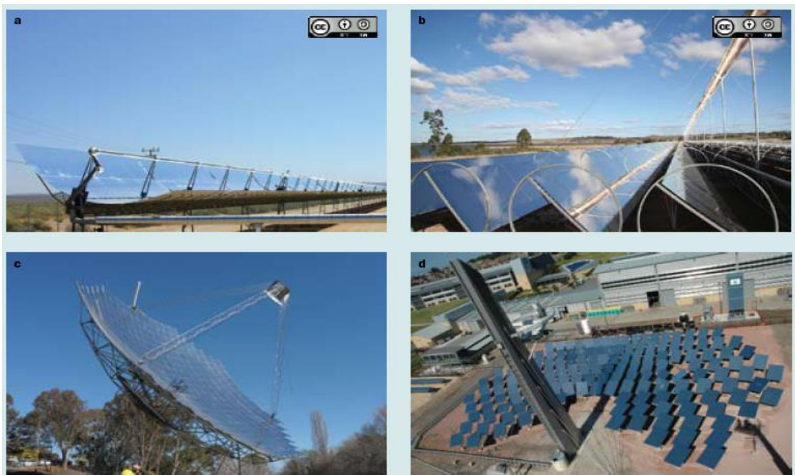
Εικόνα 2.1.1.1: Τεχνολογίες συγκέντρωσης ηλιακής ισχύος: (α) Παραβολικό κάτοπτρο (β) LFR (γ) Παραβολικό πιάτο (δ) Ηλιακός πύργος (Πηγή: Renewable Energy Australia).
