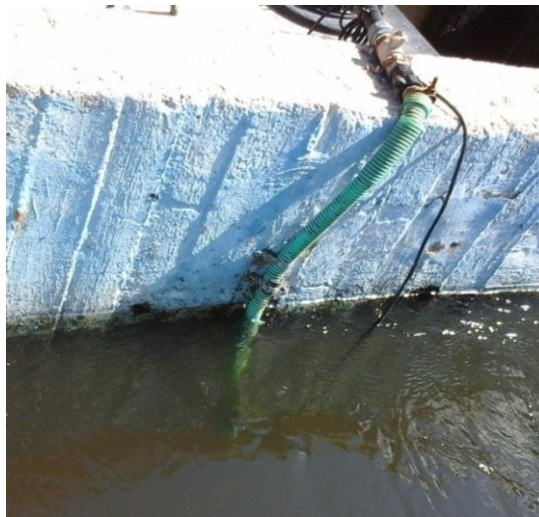
Εικόνα 12 Είσοδος λύματος από την εκροή της δευτεροβάθμιας επεξεργασίας της ΔΕΥΑΧ στην δεξαμενή αποθήκευσης
