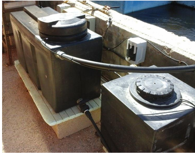
Εικόνα 11 Δεξαμενή αποθήκευσης λύματος 200 L και δεξαμενή επιμόλυνσης 100 L.
