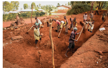
77. Προετοιμασία του εδάφους για τη θεμελίωση
