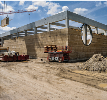
132. Προκατασκευασμένα block χώματος γεμίζουν τον φέροντα οργανισμό.
