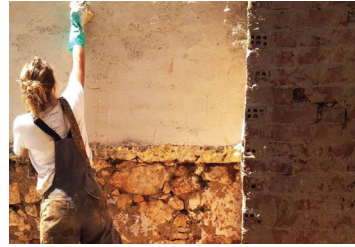
151. Προετοιμασία του αποσαθρωμένου τοίχου
