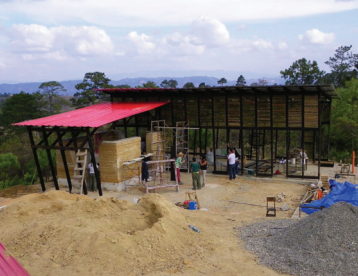
103. Στο αριστερό κομμάτι της κατασκευής διακρίνεται η πέτρινη βάση
