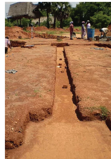
24. Προετοιμασία του εδάφους για τη θεμελίωση
