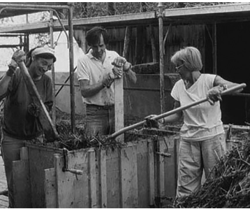
13. Φτιάχνοντας ελαφρά μπλοκς χώματος με άχυρο
