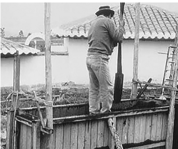
12. Έμβολο διπλής κεφαλής για συμπίεση του χωμάτινου μείγματος
