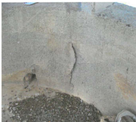
Εικόνα 18 Αποφλοιώσεις των στοιχείων του σκυροδέματος και διαβρώσεις των οπλισμών (πηγή: Τεχνική υπηρεσία Δήμου Χανίων)
