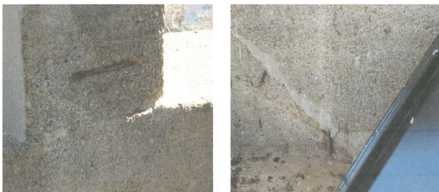
Εικόνα 20 Διαβρώσεις των οπλισμών (πηγή: Τεχνική υπηρεσία Δήμου Χανίων)
