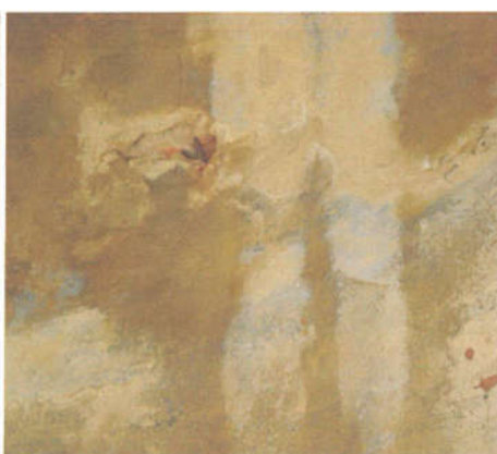
Εικόνα 17 Οι ρηγματώσεις του τρούλου (πηγή: Τεχνική υπηρεσία Δήμου Χανίων)
