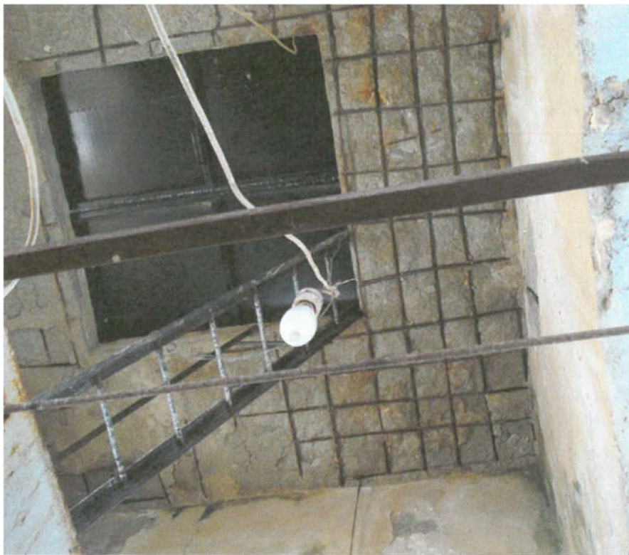
Εικόνα 15 Διάθρωση του οπλισμού στην πλάκα σκυροδέματος στη βάση του φανού (πηγή: Τεχνική υπηρεσία Δήμου Χανίων)
