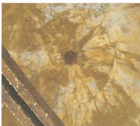
Εικόνα 17 Οι ρηγματώσεις του τρούλου (πηγή: Τεχνική υπηρεσία Δήμου Χανίων)
