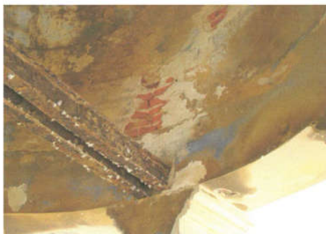
Εικόνα 16 Η ανάρτηση της καμπάνας στην άνω στεφάνη και ο τρούλος από συμπαγής οπτόπλινθους (πηγή: Τεχνική υπηρεσία Δήμου Χανίων)
