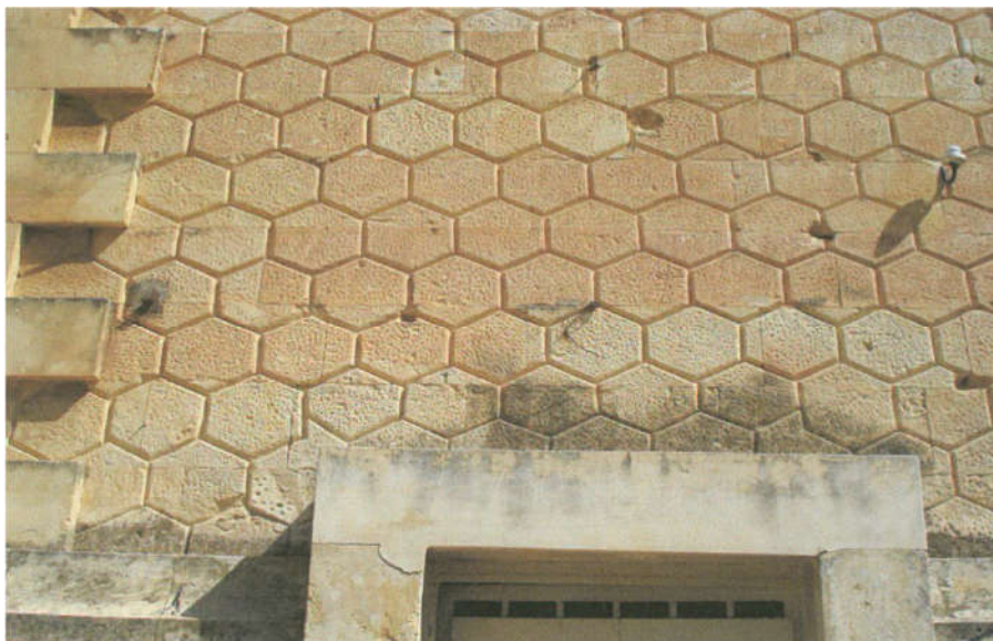
Εικόνα 10 Λεπτομέρεια του τρόπου δόμησης με εκχαракτη εξαγωνική διακόσμηση πάνω σε ορθογώνιους λίθους (πηγή Τεχνική υπηρεσία Δήμου Χανίων)
