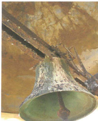
Εικόνα 16 Η ανάρτηση της καμπάνας στην άνω στεφάνη και ο τρούλος από συμπαγής οπτόπλινθους (πηγή: Τεχνική υπηρεσία Δήμου Χανίων)
