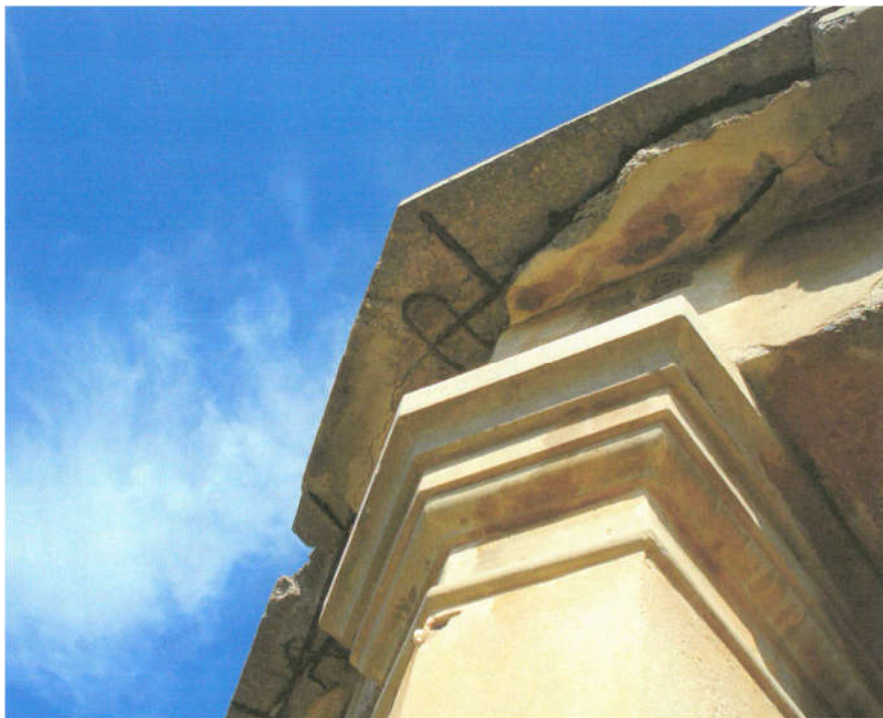
Εικόνα 19 Αποκόλληση σκυροδέματος στη στέψη του φανού (πηγή: Τεχνική υπηρεσία Δήμου Χανίων)
