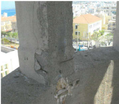
Εικόνα 18 Αποφλοιώσεις των στοιχείων του σκυροδέματος και διαβρώσεις των οπλισμών (πηγή: Τεχνική υπηρεσία Δήμου Χανίων)
