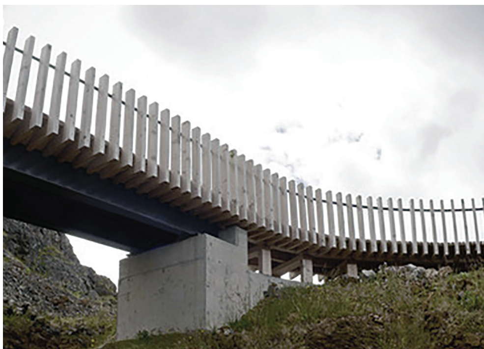
Εικ. 2.45 Χρήση σκυροδέματος για τη θεμελίωση της κατασκευής
