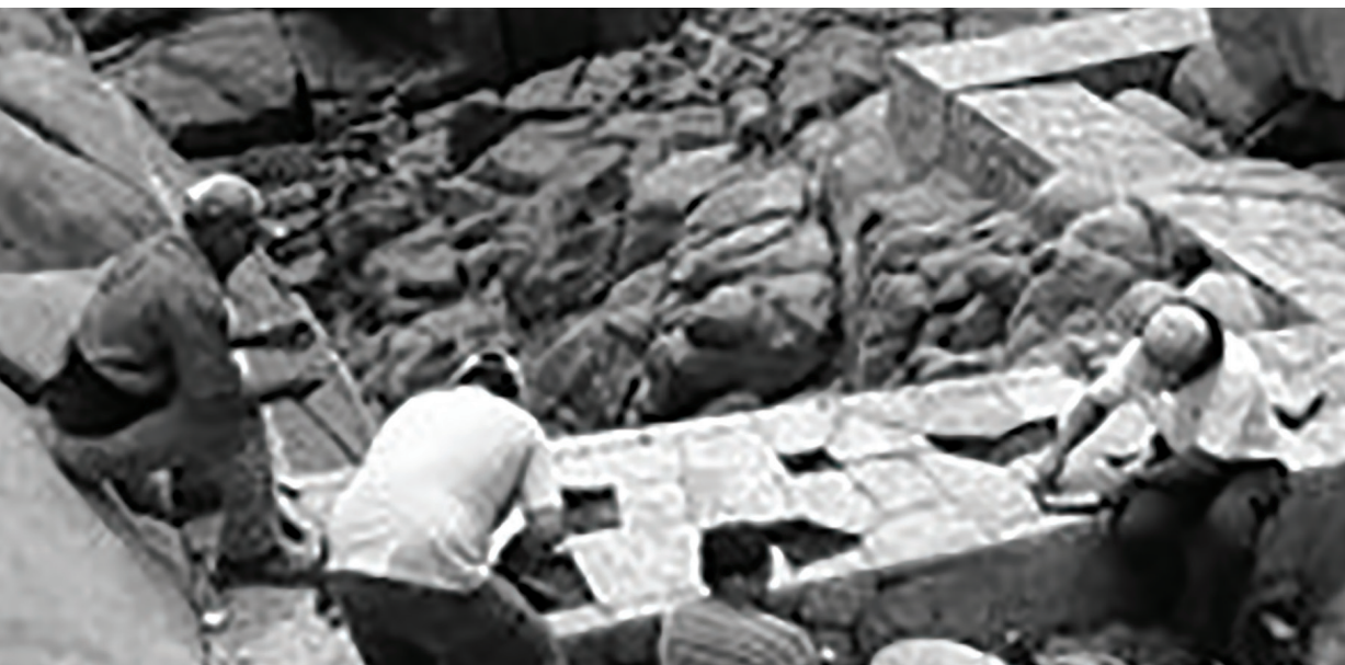
Εικ. 2.36 Συνεργείο λιθοξόνων λαξεύει και προσαρμόζει τα πρόσθετα τμήματα του μονοπατιού
