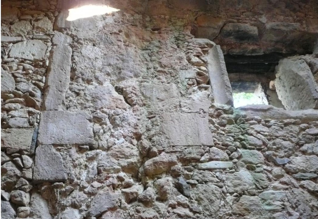
Εικ. 53. Μεταγενέστερο μικρό παράθυρο και ίχνη μεγαλύτερου
