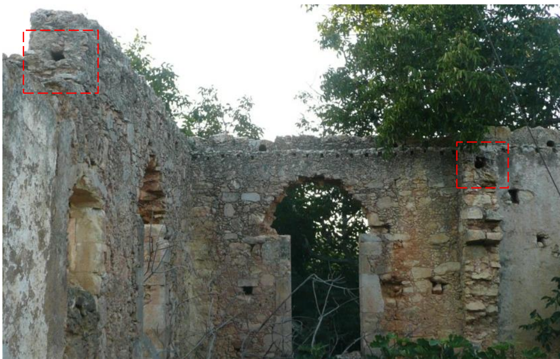
Εικ. 83. Οπές αερισμού μεσοδόκιων
