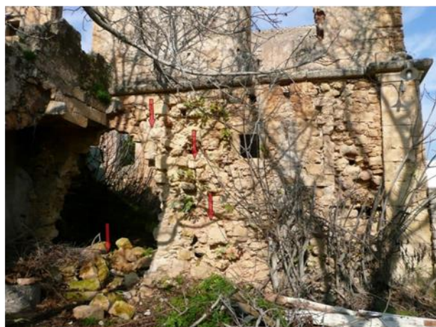
Εικ. 98. Αποσάθρωση λιθοδομών
