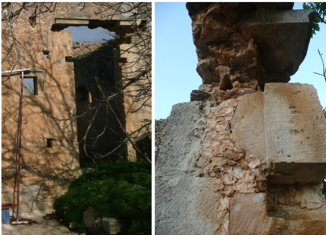
Εικ. 36. Κεντρικό θύρωμα. Λεπτομέρεια εισόδου με ίχνη από μεταγενέστερη επέμβαση
