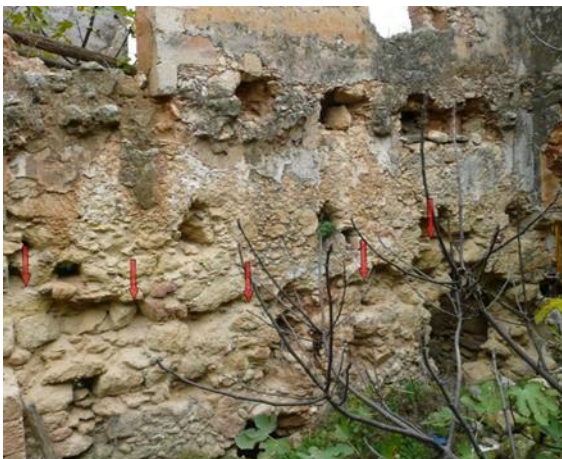
Εικ. 97. Αποσάθρωση λιθοδομών
