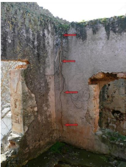
Εικ. 95. Αποκόλληση τοιχοποιιών
