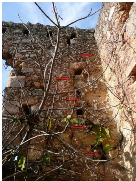
Εικ. 96. Αποκόλληση τοιχοποιιών
