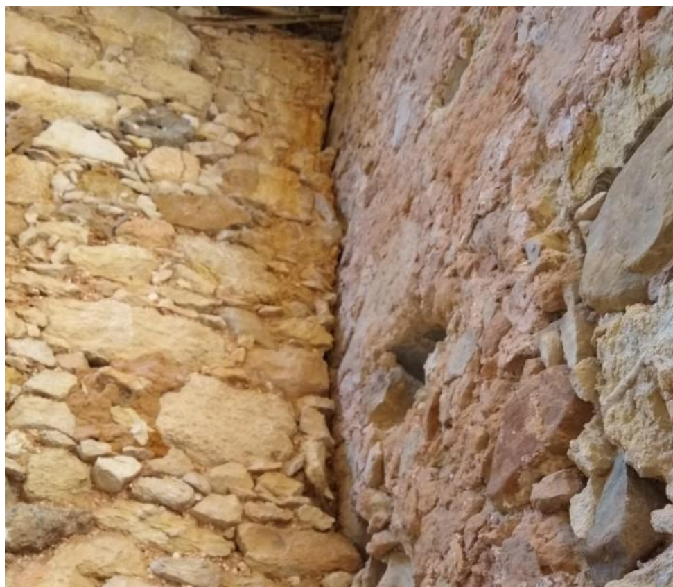
Εικ. 58. Απουσία σύνδεσης μεταξύ μεταγενέστερης μεσοτοιχίας (αριστερή) και εξωτερικής
