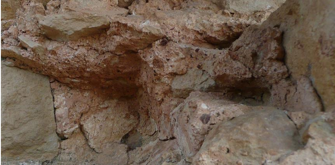
Εικόνα 102. Κονίαμα από κεραμάλευρο και ασβέστη, αρχικό κονίαμα ενετικής περιόδου
