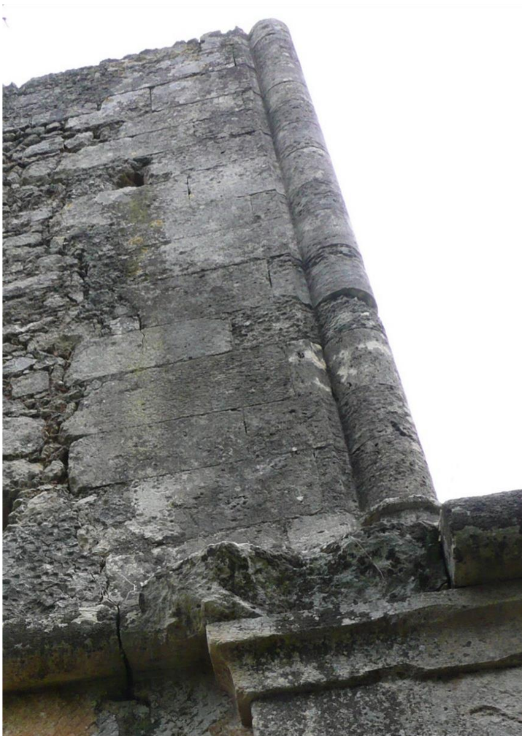
Εικ. 28. Ισόδομοι λίθοι γωνιών με αφανή αρμό. Έπαυλη Κατωχωρίου
