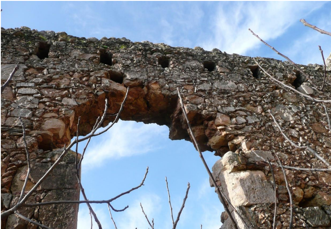
Εικ. 82. Θέσεις θηκών δοκών ξύλινου δώματος
