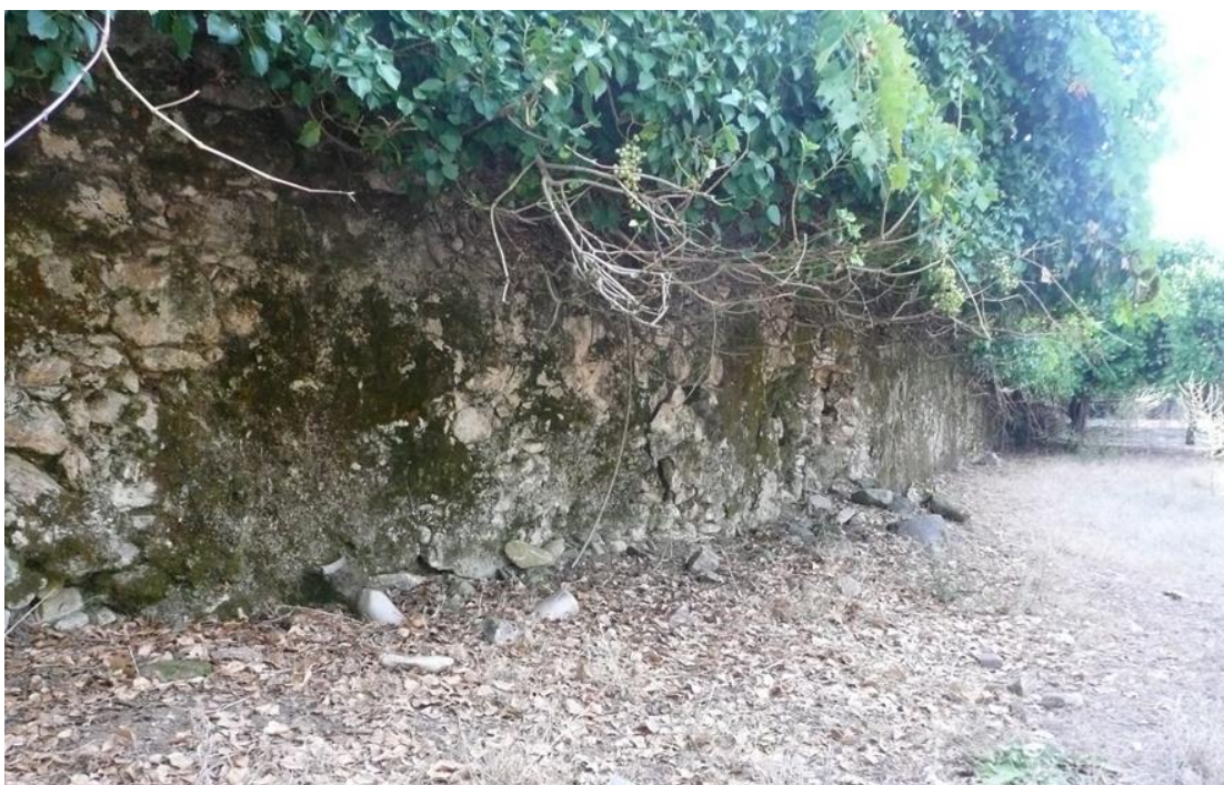
Εικ. 18. Τοιχίο με κανάλι στη στέψη του για την μεταφορά του νερού στον νερόμυλο
