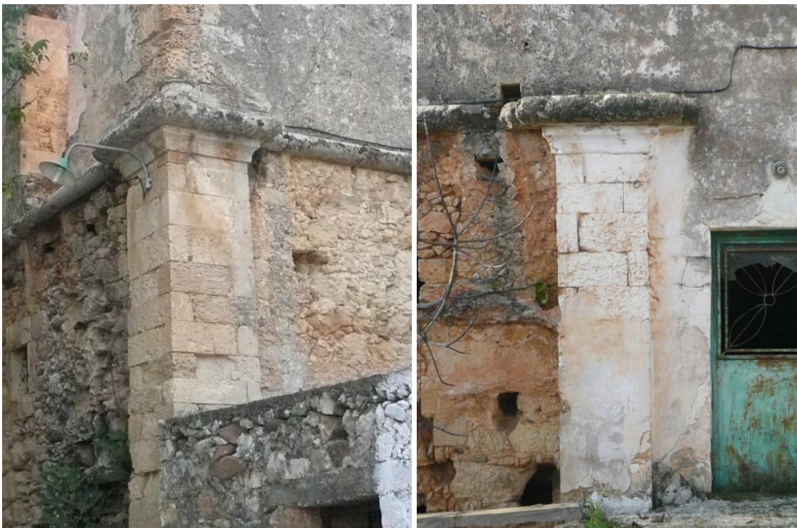
Εικ. 25. Γωνιακός και ενδιάμεσος πεσσός της έπαυλης Κατωχωρίου
