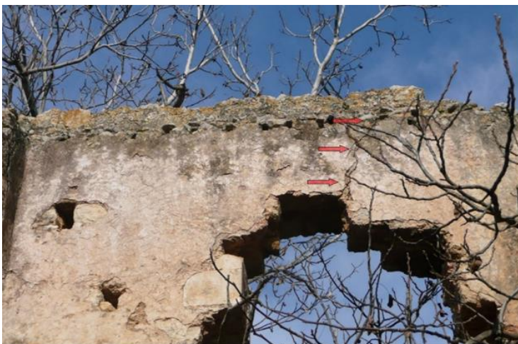
Εικ. 93. Κάθετη ρωγμή λόγω εφελκυσμού
