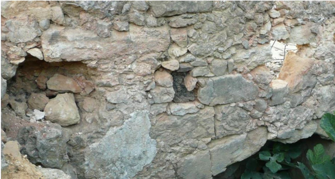
Εικ. 77. Θέση έδρασης δοκών. Διακρίνεται τμήμα της παλαιάς ξύλινης διατομής
