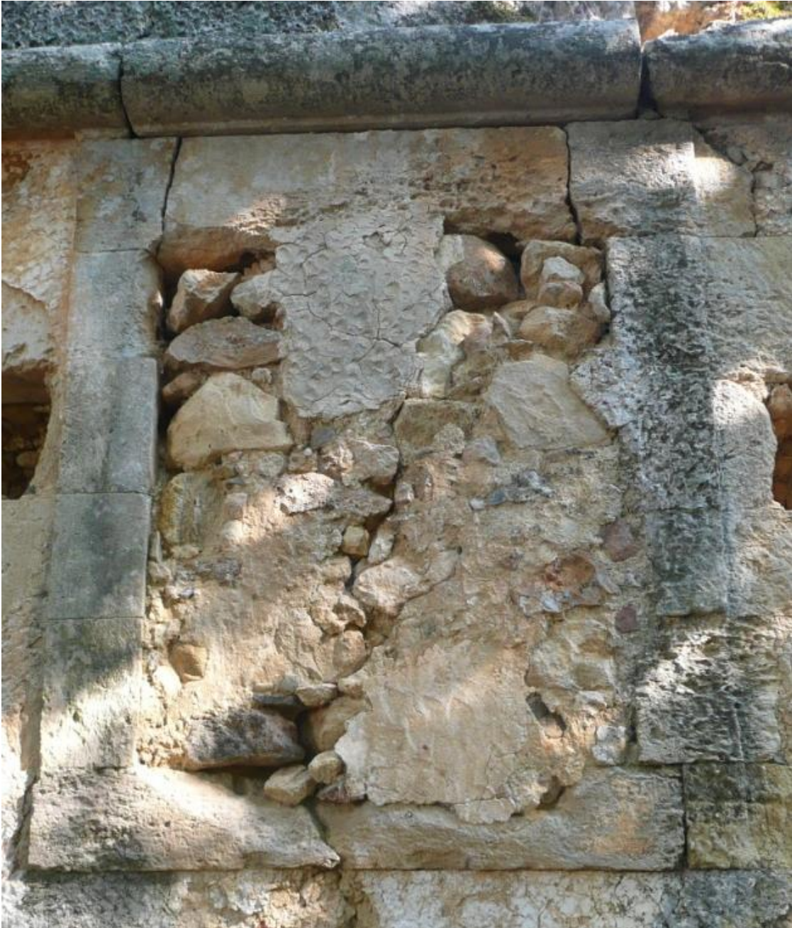
Εικ. 65. Σφραγισμένο παράθυρο και λίθινο κορδόνι με λάξευση στα όρια του πρεκιού
