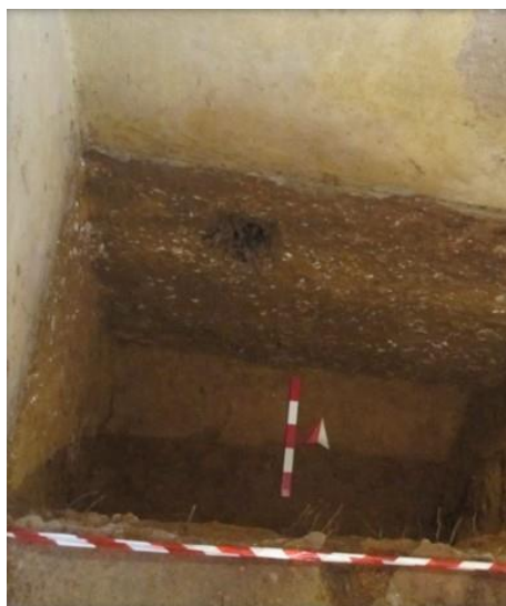
Εικ. 23. Αποκάλυψη του μαργαϊκού ασβεστόλιθου πάνω στον οποίο είναι θεμελιωμένοι οι παρακείμενοι ναοί.
