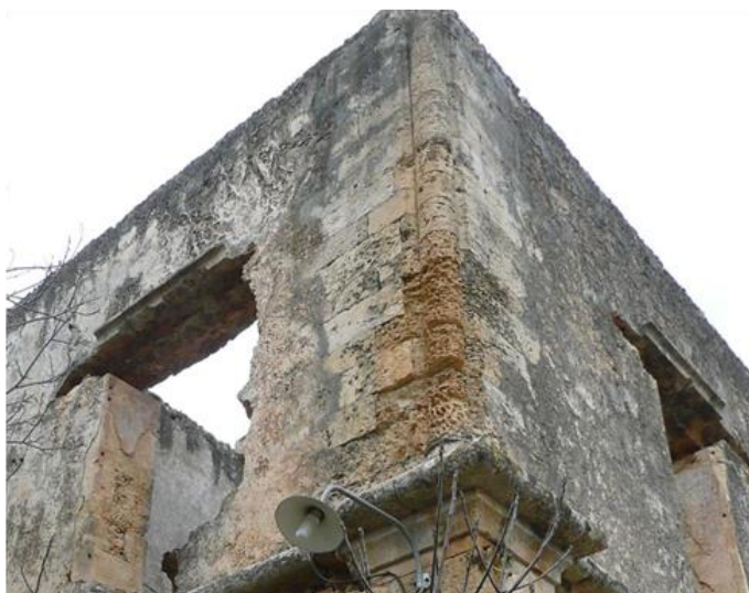
Εικόνα 101. Αποσάθρωση λαξευτών λίθων
