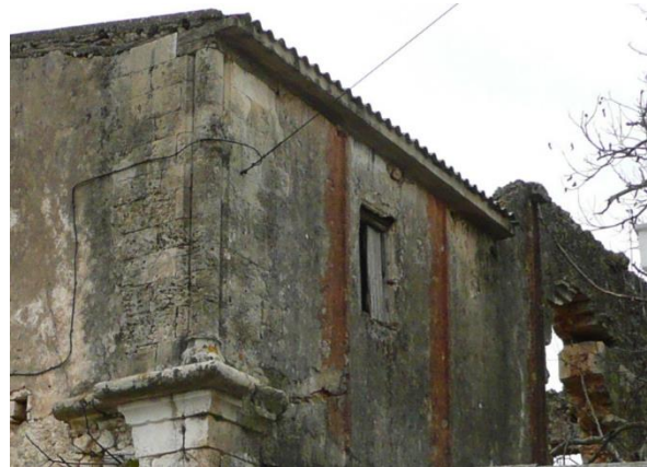
Εικ. 47. Λίθινες υδρορροές βόρειου τοίχου Εικ. 48. Υδρορροές Αναγλυφάδες
