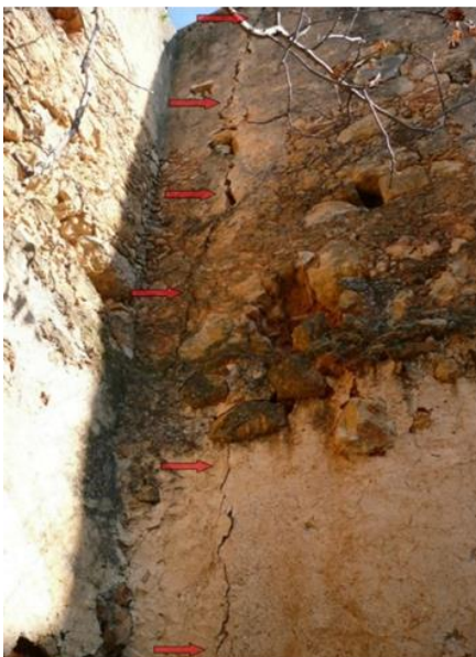
Εικ. 91. “Εντός” επιπέδου ρωγμή Εικ. 92. Διαγώνια ρωγμή δίπλα στο ανοιγμά
