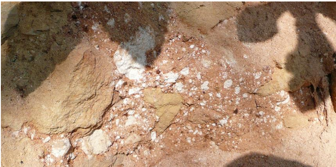
Εικόνα 102. Κονίαμα από κεραμάλευρο και ασβέστη, αρχικό κονίαμα ενετικής περιόδου
