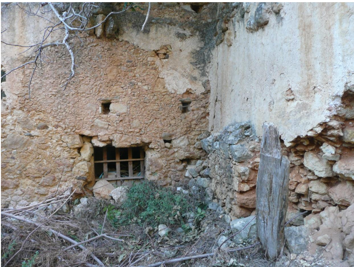
Εικ. 76. Ίχνη γένεσης καμάρας και των λίθινων κλειδιών αυτής
