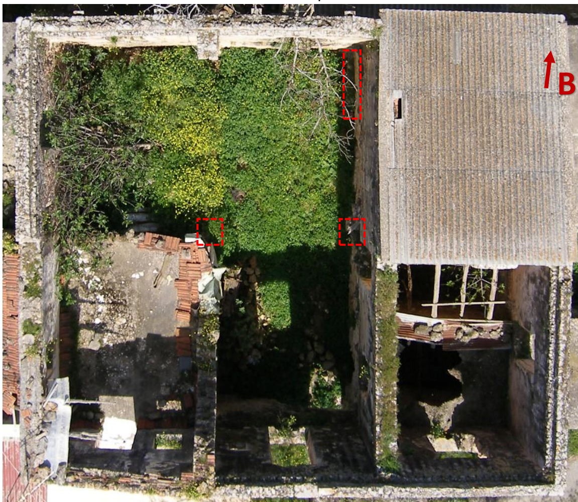
Εικ. 73. Άποψη της έπαυλης εσωτερικά, θέσεις ισόδομων πεσσών και γέννησης καμάρας
