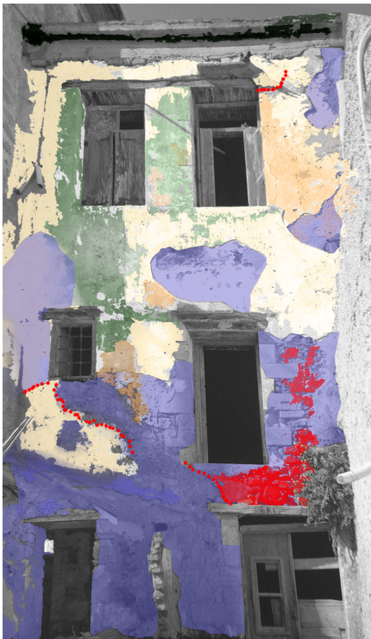
Ε 2. Ανατολική όψη, τμήμα 2, σχεδιάγραμμα φθορών
