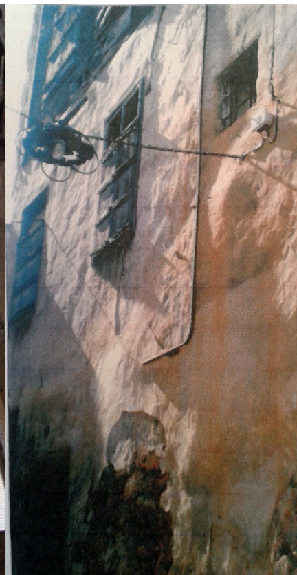
Εικόνα 46. Φωτογραφία έτους 1990, διακρίνεται η ξύλινη τοιχοποιία στον όροφο
