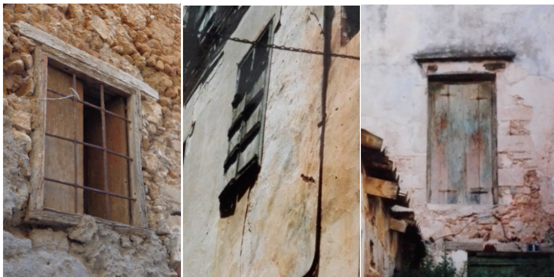
Εικόνα 47. Σιδερένιο κούφωμα ισογείου, καρφωτό ξύλινο κούφωμα με φεγγίτη στον όροφο, καρφωτό ξύλινο κούφωμα στην ανατολική όψη με γείσο
