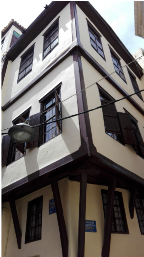
Εικόνα 22. Χαρακτηριστικά σαχνισί γωνιακών κτηρίων
