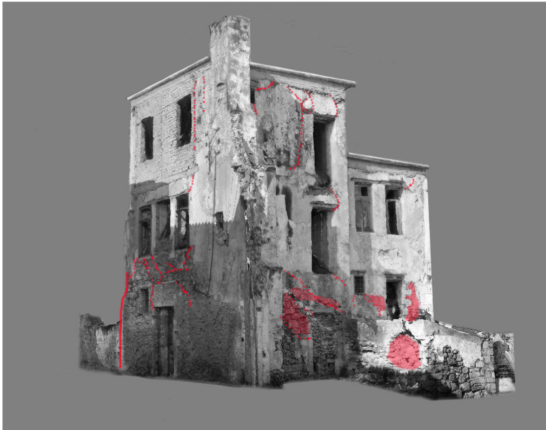
Π 1. Παθολογία νοτιοανατολικής όψης, με κόκκινο εστιγμένο σημειώνονται οι ρωγμές, με κόκκινη επιφάνεια η πτώση κονιαμάτων, με συνεχή γραμμή η απόκλιση από την κατακόρυφο.
