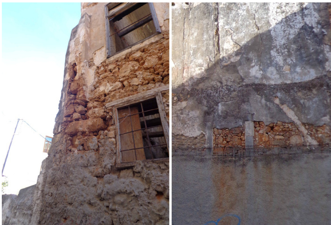
Εικόνα 38. Αργολιθοδομή σε κακή κατάσταση στη νότια όψη, τόξο στη δομή της τοιχοποιίας στη δυτική όψη
