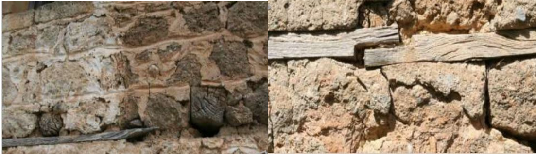
Εικόνα 19. Χαρακτηριστικά ξύλινα διαζώματα σε παραδοσιακές κατασκευές
