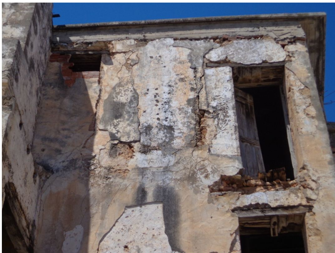
Εικόνα 48. Χρωματικές αλλοιώσεις και αποκόλληση επιχρίσματος της ανατολικής όψης
