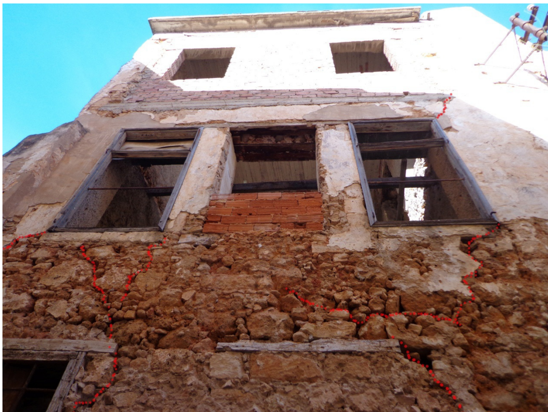
Εικόνα 51. Τμήμα της νότιας όψης, διαγώνιες ρηγματώσεις και αποδιοργάνωση υλικού
