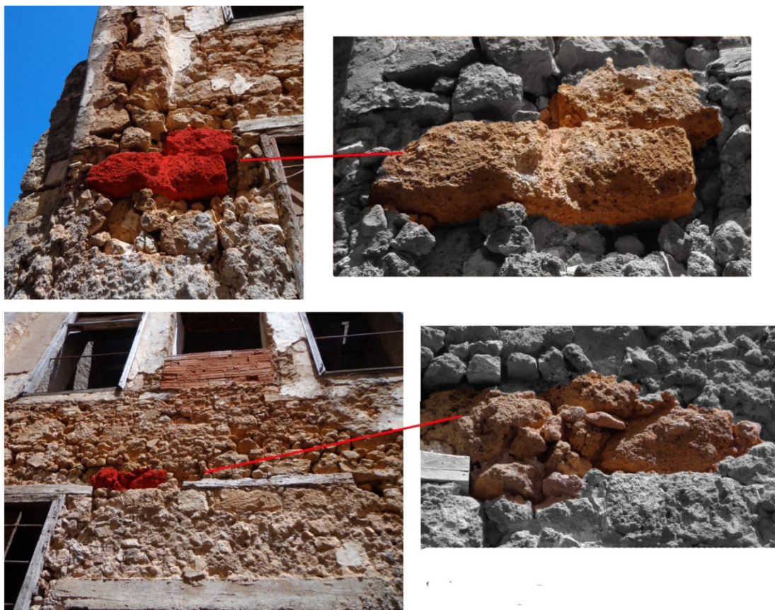
Εικόνα 50. Κυψελοειδής διάβρωση και βελονισμός σε λιθοσώματα της νοτίου όψης
