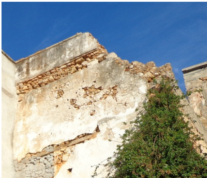
Εικόνα 21. Ξύλινα διαζώματα σε λιθοδομή κτηρίου στην παλαιά πόλη Χανίων
