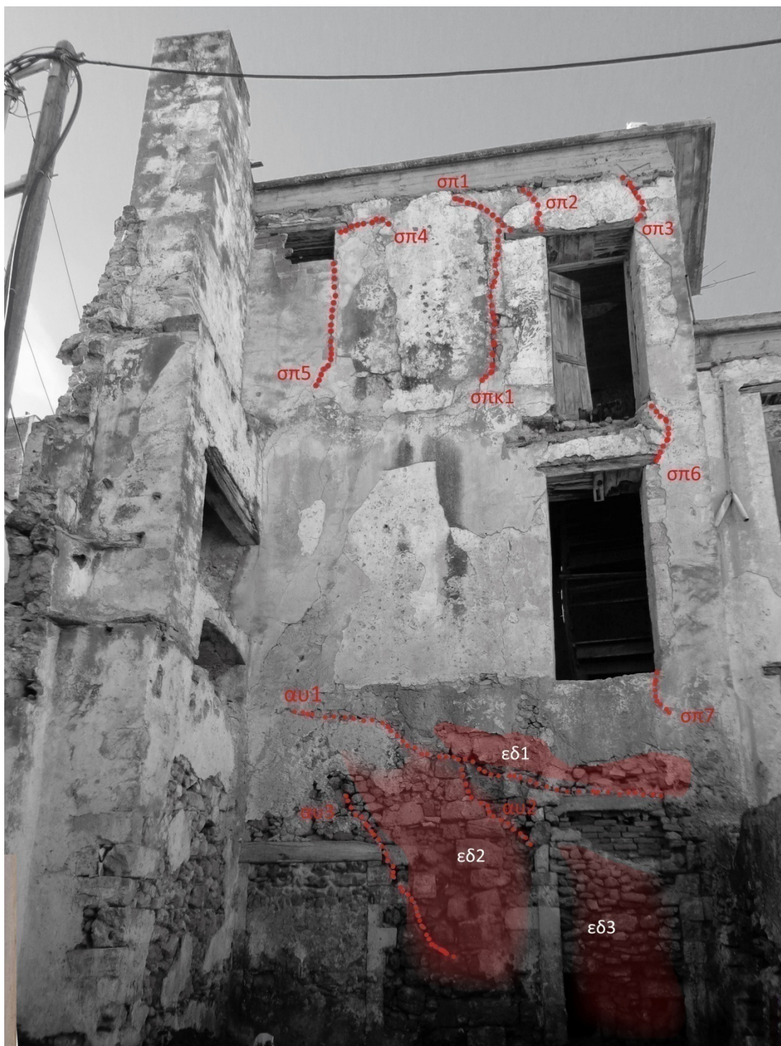
Π 3. Παθολογία ανατολικής όψης, τμήμα 1
