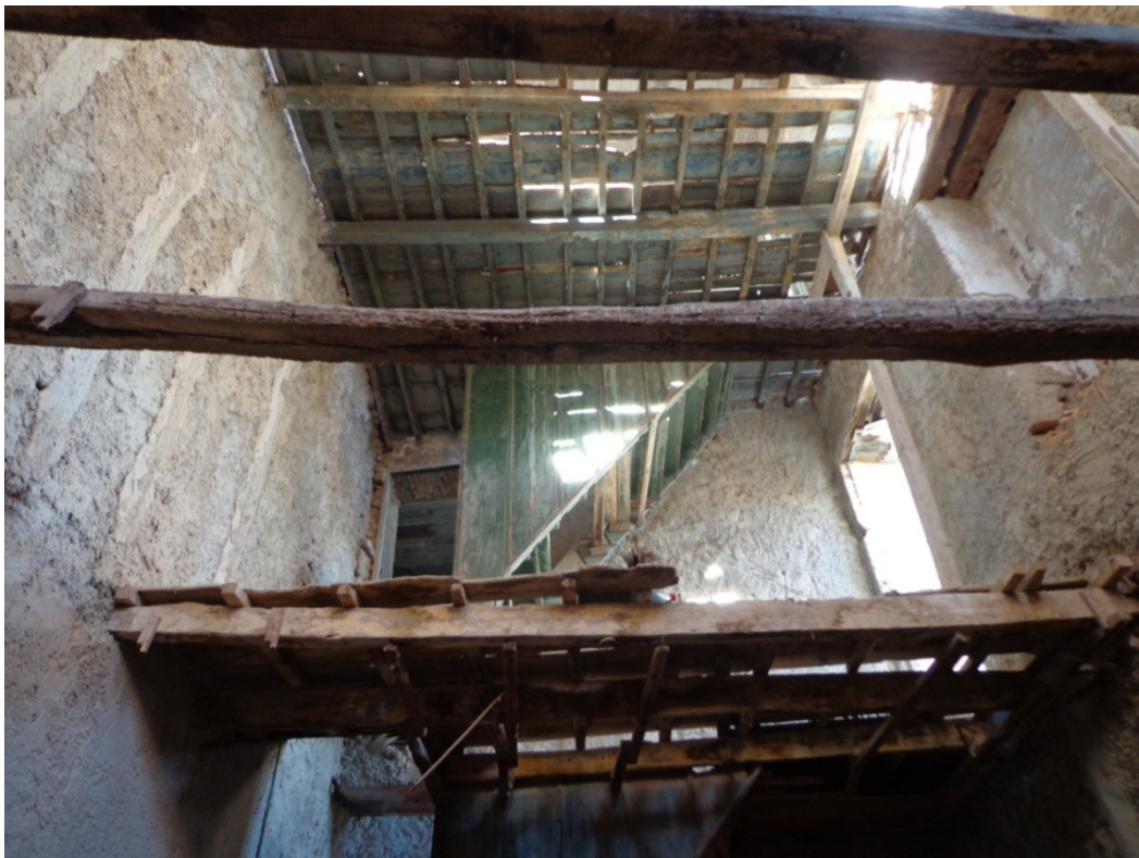
Εικόνα 41. Τα εσωτερικά ξύλινα μεσοπατώματα και η κλίμακα ανόδου
