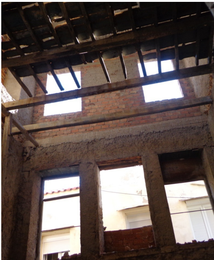
Εικόνα 45.Αντικατάσταση του μπαγδατότοιχου με τείχο από οπτόπλινθους
