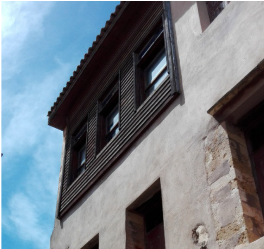
Εικόνα 23. Μπαγδατότοιχος μη προεξέχων, ως ελαφρά τοιχοποιία πλήρωσης του ορόφου
