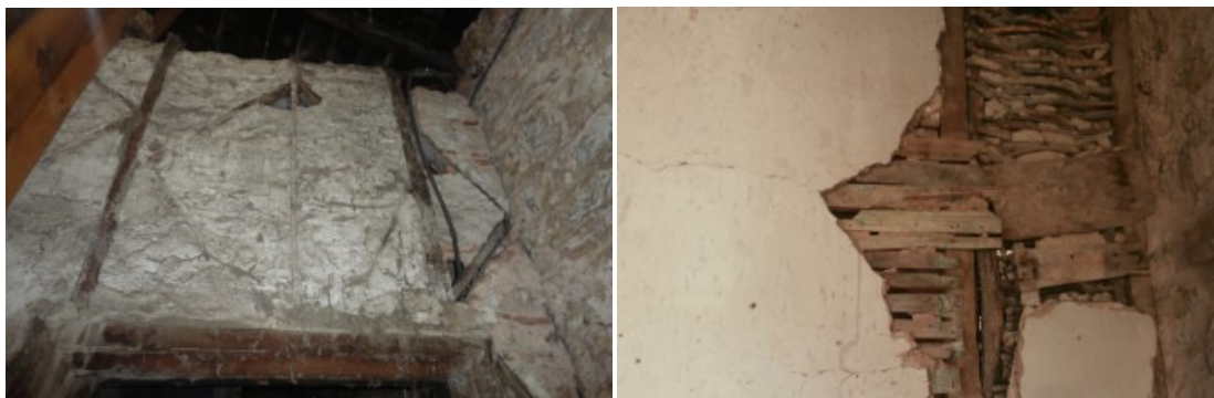
Εικόνα 3. Αριστερά: τοιχοποιία «τσατμά», δεξιά τοιχοποιία «μπαγδατί»
