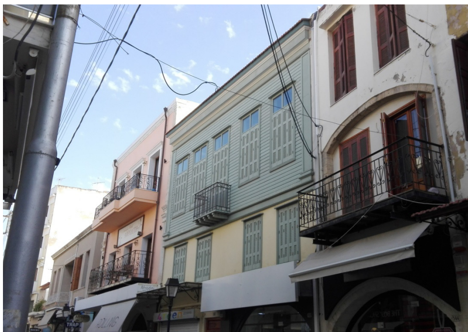
Εικόνα 27. . Ξυλόπληκτη τοιχοποιία με ξύλινο πέτσωμα στον όροφο κτηρίου, οδός Αρκαδίου, Ρέθυμνο
