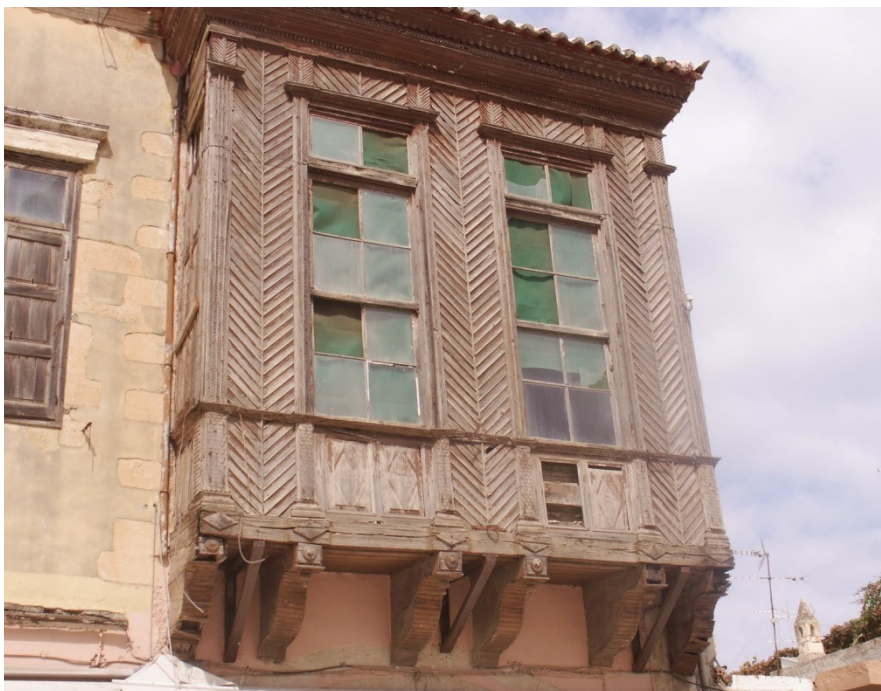
Εικόνα 16. Κτήριο με ιδιαίτερα επιμελημένο ξύλινο πέτσωμα στο σαχνισί, Ρέθυμνο
