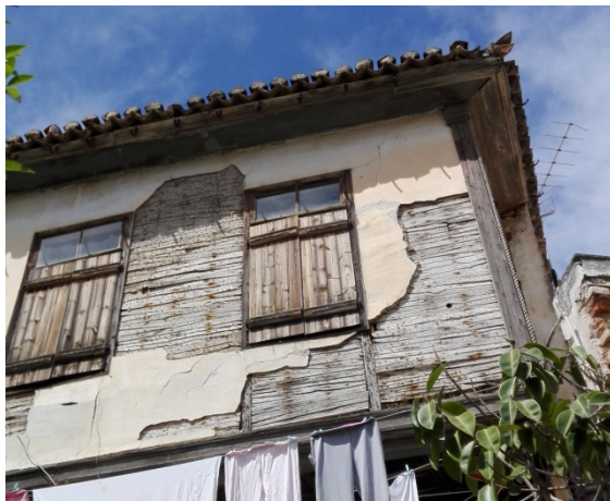
Εικόνα 24. Αριστερά Μπαγδατί επιχρισμένο, δεξιά μπαγδατί με ξύλινο πέτσωμα, Παλαιά πόλη Χανίων
