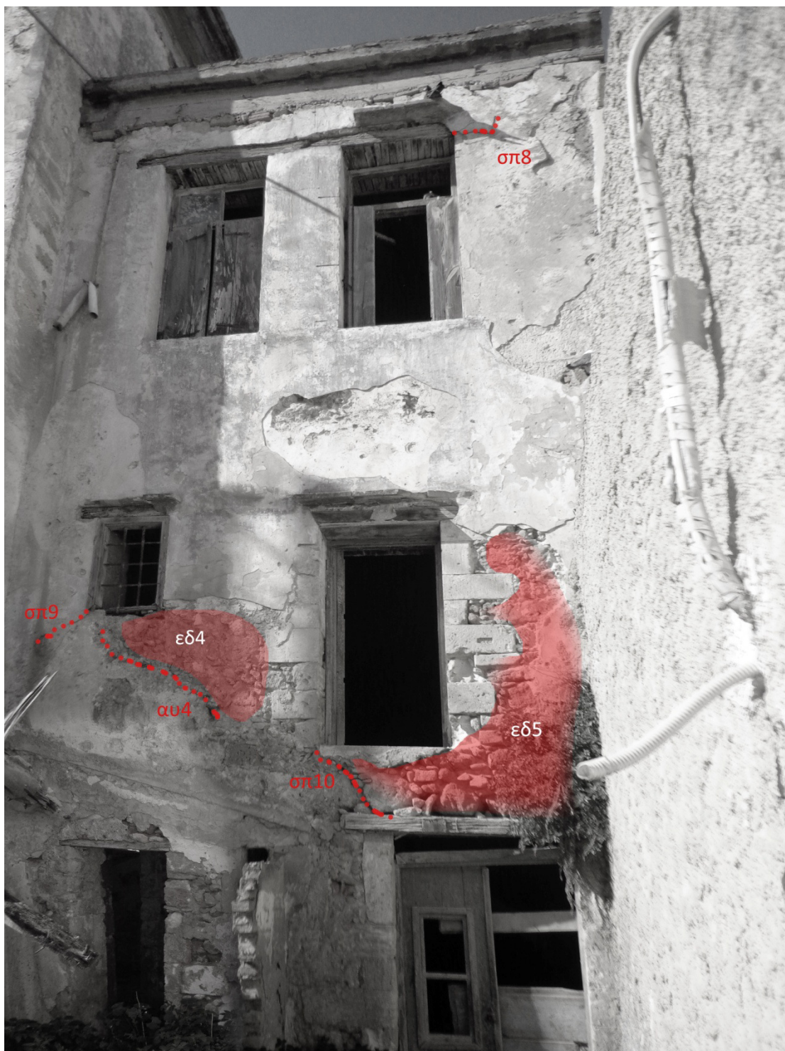
Π 4. Παθολογία ανατολικής όψης, τμήμα 2
