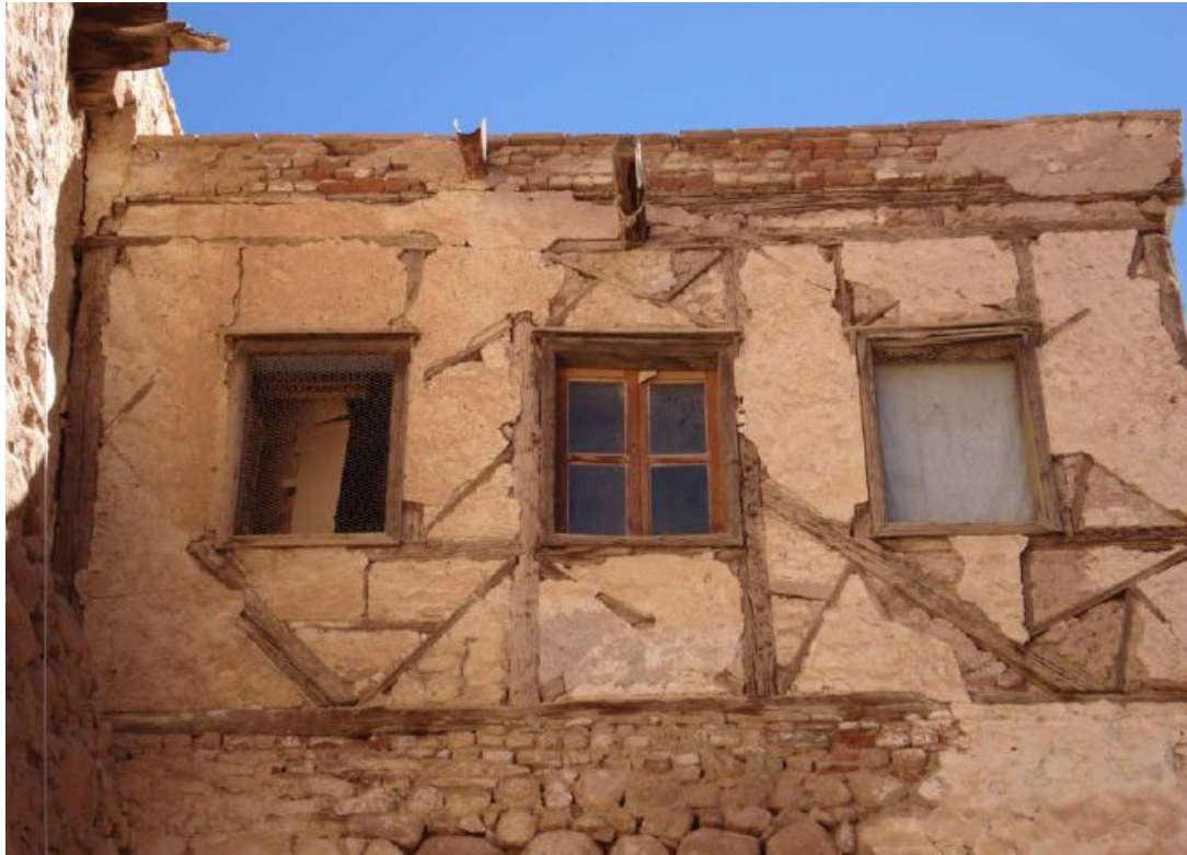
Εικόνα 6. Ξυλόπηκτη τοιχοποιία όπου διακρίνεται η δικτύωση
