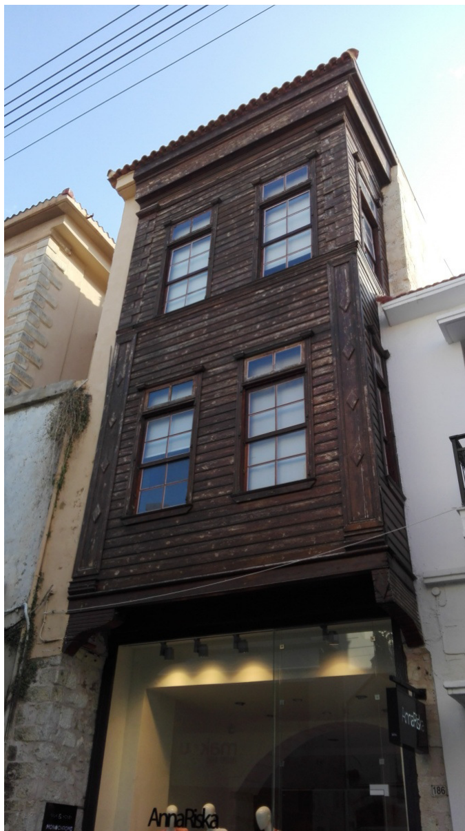
Εικόνα 28. Διώροφη ξυλόπηκτη προεξέχουσα τοιχοποιία, οδός Αρκαδίου Ρέθυμνο
