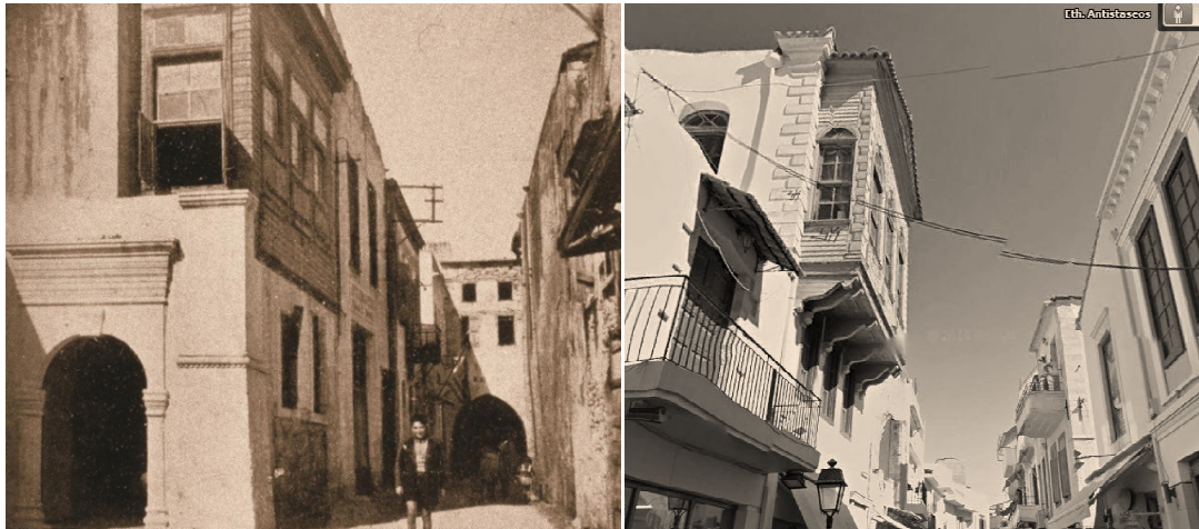
Εικόνα 2. Αριστερά: Ξυλόπηκτη τοιχοποιία μη προεξέχουσα στη οδό Βερνάρδου στο Ρέθυμνο .Δεξιά: Ξυλόπηκτη τοιχοποιία προεξέχουσα, σαχνισί, στην οδό Εθνικής Αντιστάσεως 84 στο Ρέθυμνο
