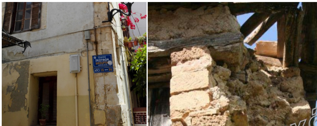
Εικόνα 18. Αριστερά: Λαξευτοί πεσσοί σε γωνία κτηρίου ,Δεξιά: Ημιλαξευτοί λίθοι σε πεσσό ανοίγματος αργολιθοδομής
