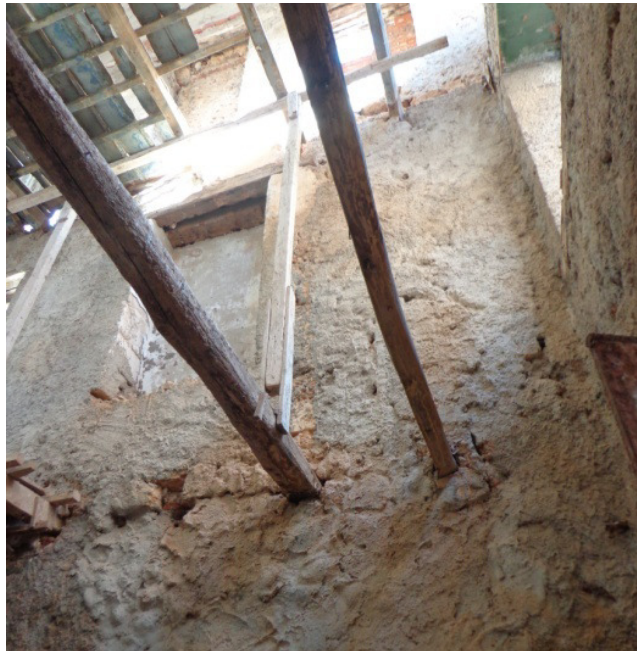
Εικόνα 40. Ξύλινα δοκάρια πατώματος πακτωμένα στην τοιχοποιία
