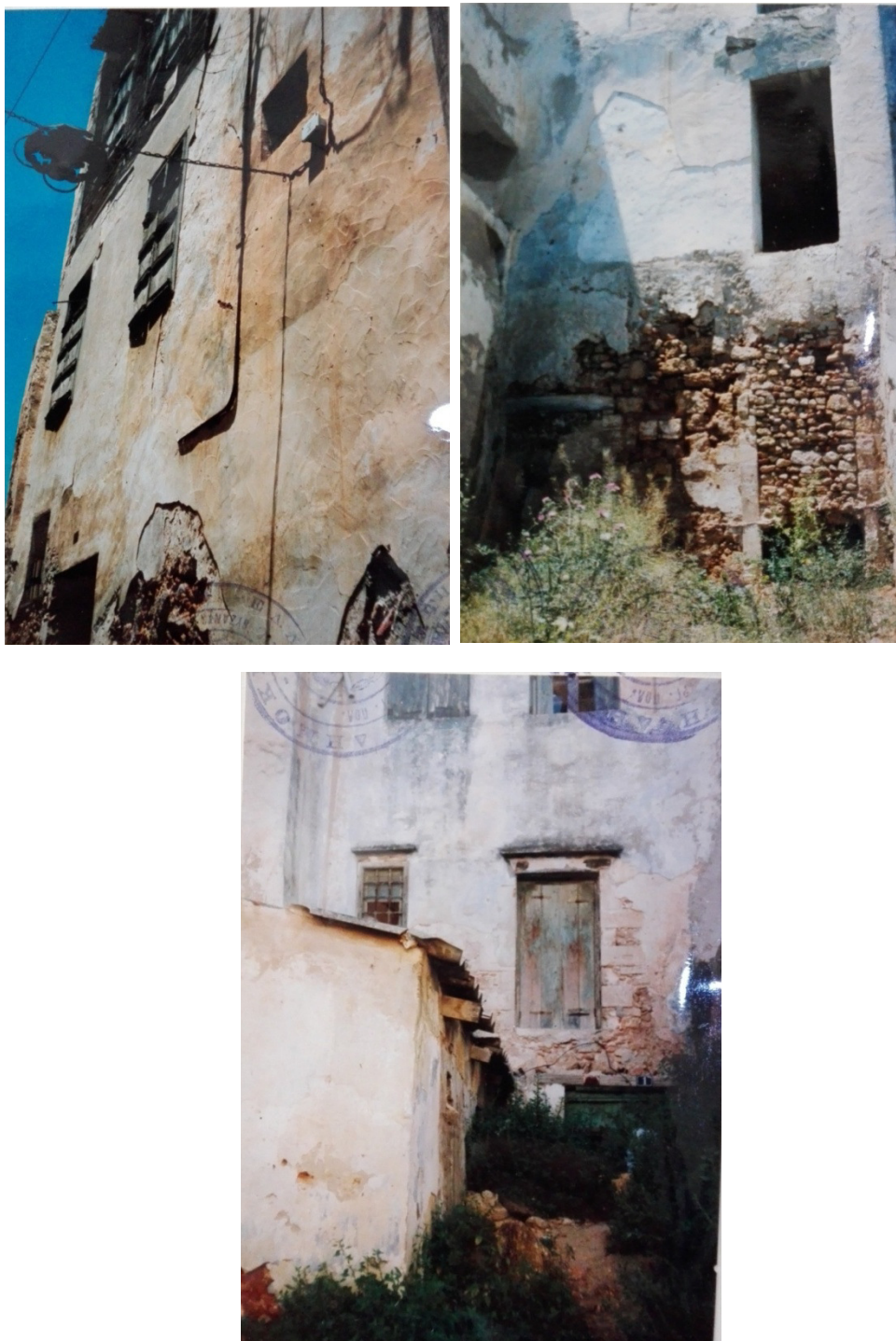
Εικόνα 37. Φωτογραφίες 1990, διακρίνεται η ελαφρά τοιχοποιία στον όροφο της νότιας όψης (πάνω αριστερά), τμήματα της ανατολικής όψης όπου διακρίνεται και κτίσμα του οποίου δε διατηρείται η επιστέγαση(πάνω δεξιά και κάτω κέντρο), (πηγή αρχείο Εφορίας Βυζαντινών Αρχαιοτήτων Χανίων)
