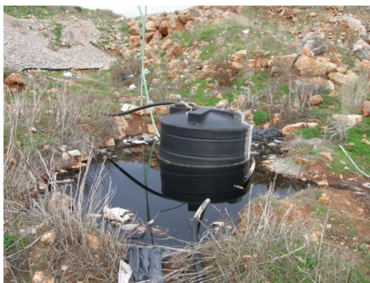
Εικόνα 1.6: Διαρροή σταλαγμάτων ΧΥΤΑ Ηρακλείου (ΟΠΗ,2018).
