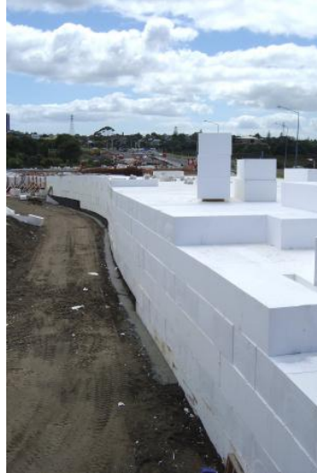
Εικόνα 4.15: Σιδηροδρομικό EPS επίχωμα στην κατασκευή ( https://www.designingbuildings.co.uk/wiki/The_use_of_Stylite_EPS_Geofill_in_rail_embankments , 2018).
