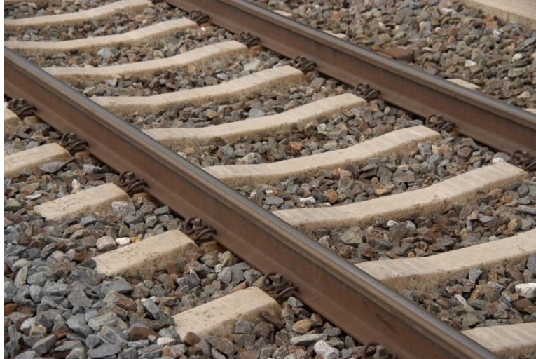
Εικόνα 2.5: Κλασική ή συμβατική ή εύκαμπτη έδραση ( https://www.plassertheurer.com/es/maquinas-sistemas/desguarnecido-balasto.html#&gid=1&pid=1 , 2018).
