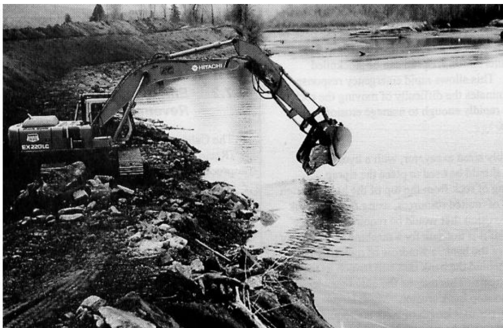
Εικόνα 2.7: Τοποθέτηση ογκωδών πετρών στην παρόχθια περιοχή στην Βρετανική Κολομβία (Πηγή: «Riprap Design and Construction Guide», Province of British Columbia Ministry of Environment, Lands and Parks, March 2000)
