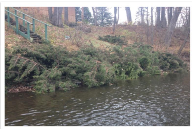
Εικόνα 2.16: Απεικόνιση της επένδυσης κέδρων στην άκρη της παρόχθιας ζώνης σε ποταμό της Ανόκα της Αμερικής (Πηγή: “Cedar Tree Retyvments” ,Isanti Soil and Water Conservation District)
