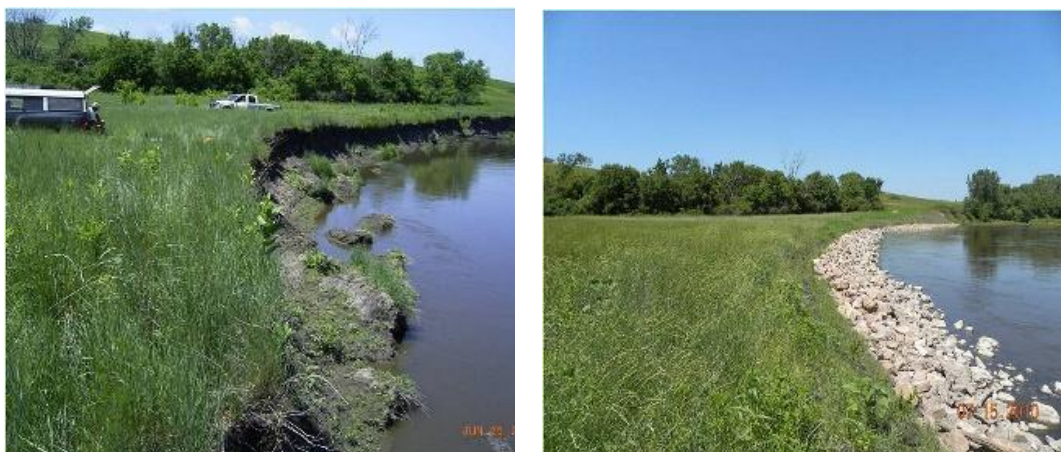
Εικόνα 2.4α) Ποταμός Big Sioux με διαβρωμένη παρόχθια ζώνη, Ιούνιος 2009 b) Παρόχθια ζώνη ποταμού Big Sioux με τοποθέτηση πετρών και βλάστησης στην παρόχθια περιοχή για την αντιμετώπιση της διάβρωσης, Ιούλιος 2010 (Πηγή: East Dakota Water Development District)
