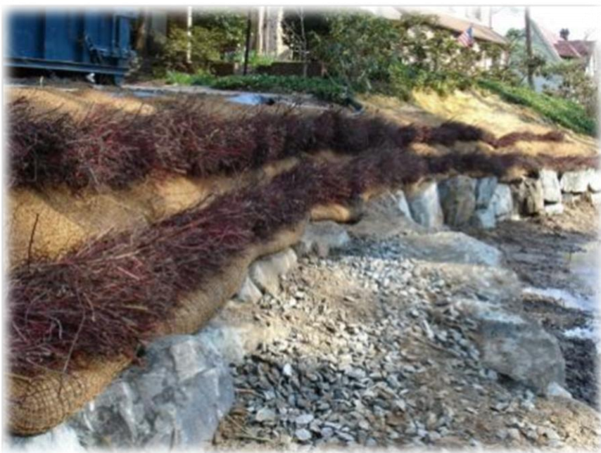
Εικόνα 2.19: Κλαδιά τοποθετημένα στην όχθη του ποταμού East Branch Wallenprauack Creek, Pennsylvania (Πηγή: F.X. Browne, Inc.)
