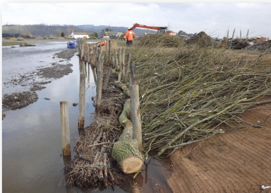
Εικόνα 2.25: Εγκατάσταση ξύλων ιτιάς, πασσάλων και δεσμών σε παρόχθια ζώνη ποταμού στην Αγγλία (Πηγή: “Salix”)
