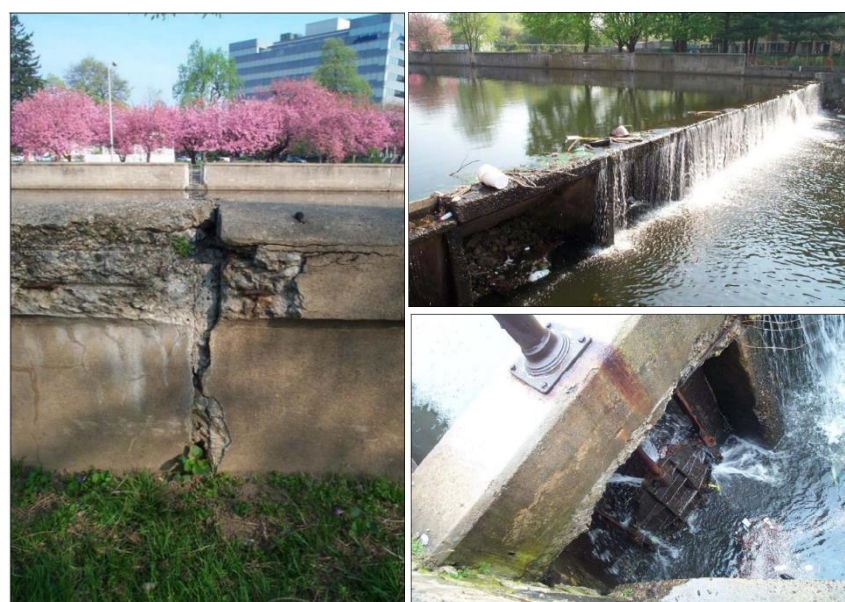
Εικ. 6: Φωτογραφίες του 2004 που απεικονίζουν 5.1Ρωγμή στο προστατευτικό τοίχιο της λίμνης. 5.2 Κατάσταση του φράγματος κατεστραμένη πύλη φραγής.
