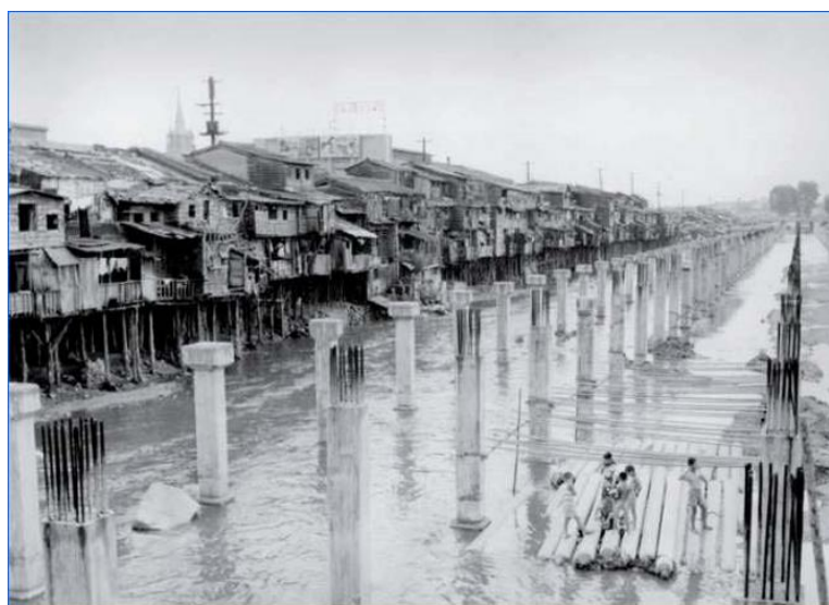
(εικ.6) Οι πρώτοι πυλώνες για την κατασκευή του αυτοκινητοδρόμου.
