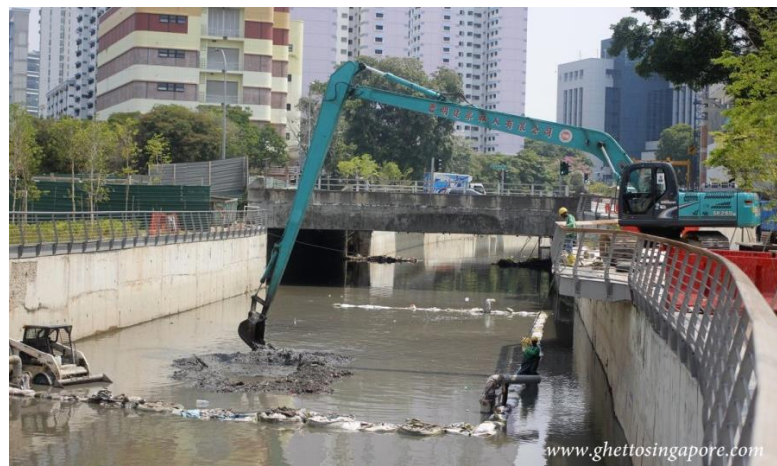
Εικ.7: Φωτογραφία του 2012, όπου φαίνονται τα έργα εμβάθυνσης του καναλιού Rochor.
