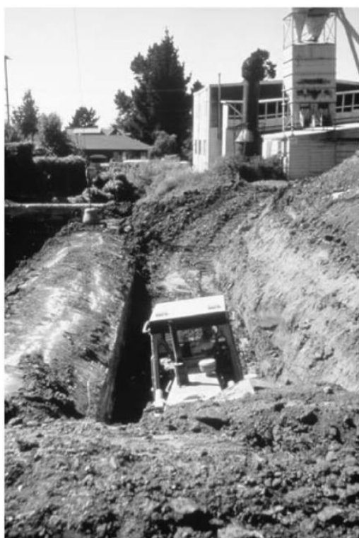
Εικ.6 Οι εκσκαφές με μηχάνημα για την αποκάλυψη του ρέματος Strawberry και την καταστροφή των αγωγών που ήταν 6 μέτρα υπογείως.
