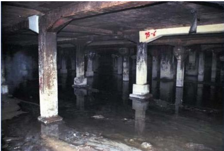
(εικ.9) Διάβρωση θεμελίων του αυτοκινητοδρόμου λόγω υγρασίας
