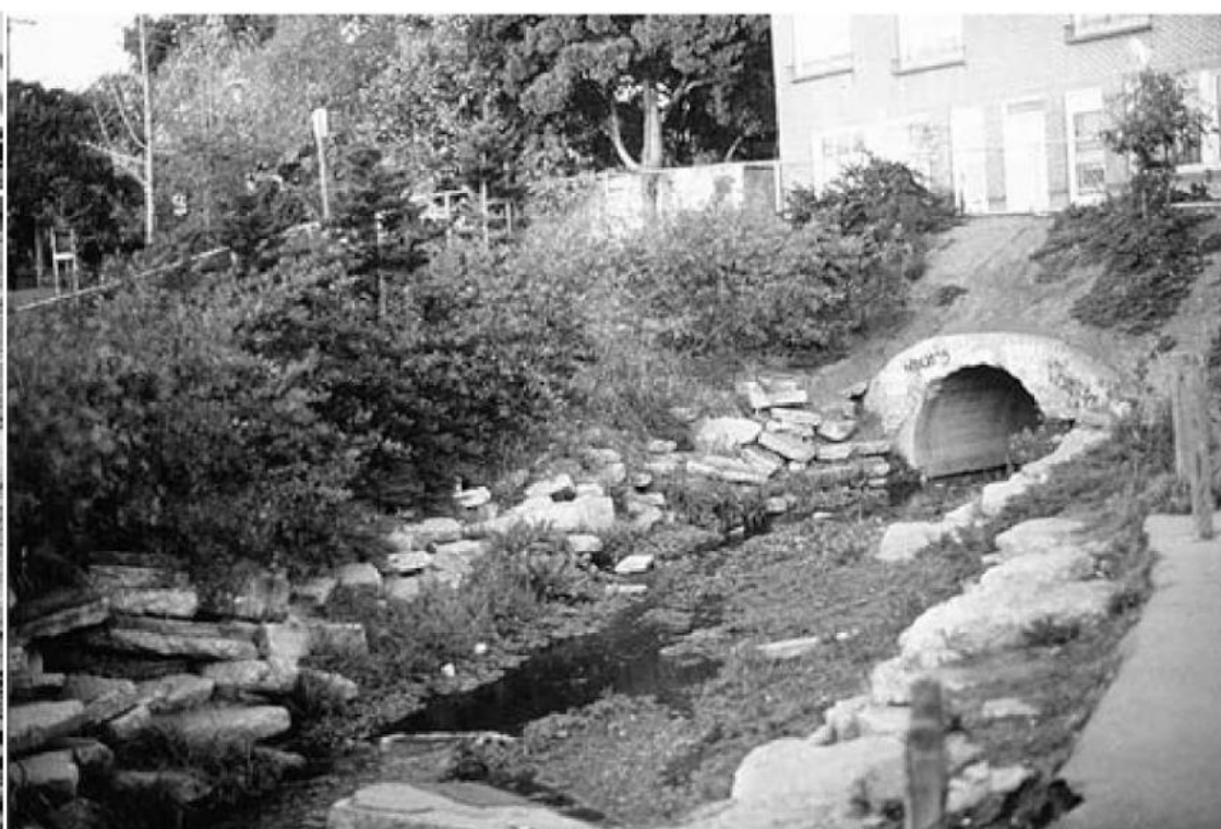
Εικ.7 Το ρέμα μετά την ολοκλήρωση των εργασιών. Φαίνονται τα κομμάτια από σκυρόδεμα που επαναχρησιμοποιήθηκαν για την οριοθέτηση του ρέματος αλλά και σαν σκαλοπάτια για την πρόσβαση των επισκεπτών και ο αγωγός που περνούσε παλαιότερα το ρέμα.
