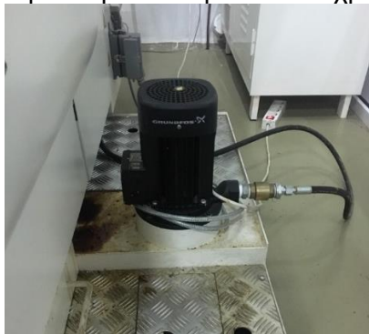
Σχήμα 3.5: Αντλία ψυκτικού υγρού
