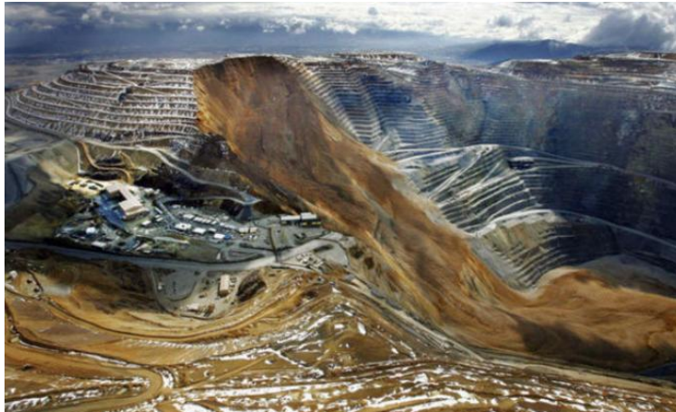
Σχήμα 3. 11: Ο μηχανισμός αστοχίας με ολίσθηση σε κυκλική επιφάνεια (Kennecott mine, στις 11 Απριλίου 2013, 9:30 μ.μ.)
