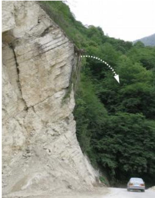
Σχήμα 3. 14: Μηχανισμός αστοχίας με ανατροπή (Zagros mountain south-west Iran)
