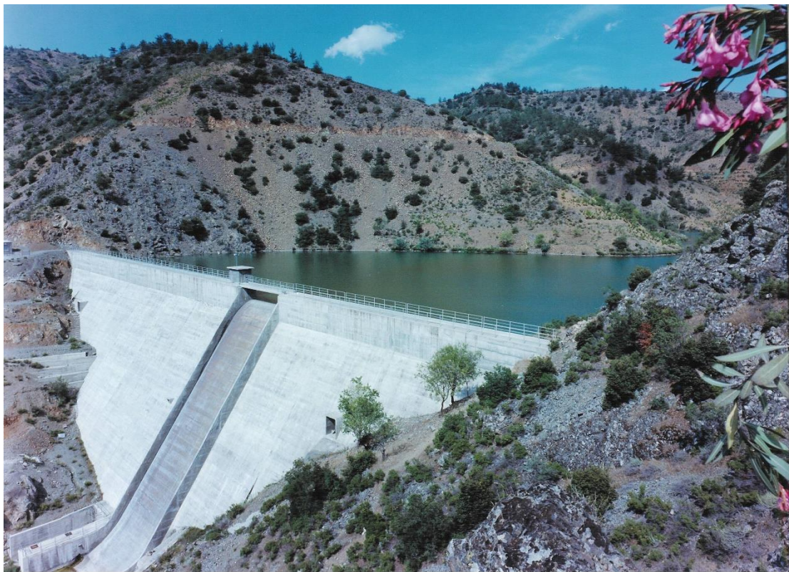
Σχήμα 2.1: Φράγμα βαρύτητας στην περιοχή Καμπί, Λευκωσίας. ( http://www.jandpcy.com/el/Palekhori-Kampi-Dam-gr )
