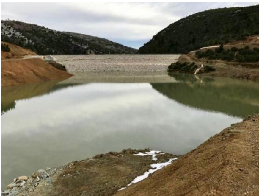
Σχήμα 2.4: Χωμάτινο φράγμα Μαυροματίου Σούρης Μαγνησίας
