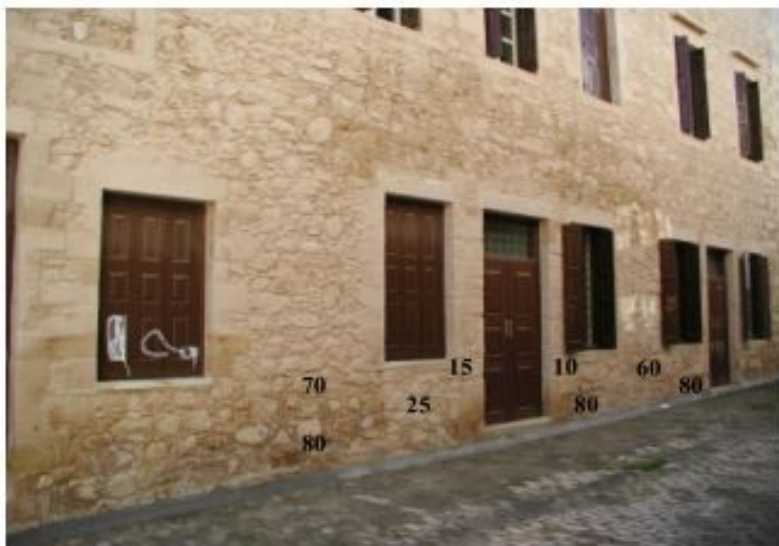
Εικόνα 1.3: Άποψη της βόρειας εξωτερικής πλευράς με τις % τιμές υγρασίας στα σημεία που μετρήθηκαν και με εντοπισμένο μέτωπο υγρασίας στο ύψος των θόλων και κοντά στο δάπεδο.
