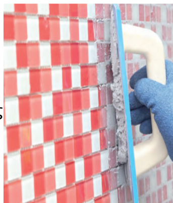
Εικόνα 2.3 : Σφράγιση κενών μεταξύ πλακιδίων
