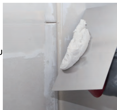
Εικόνα 2.5 : Γυψοσανίδες και ενώσεις σύνδεσης
