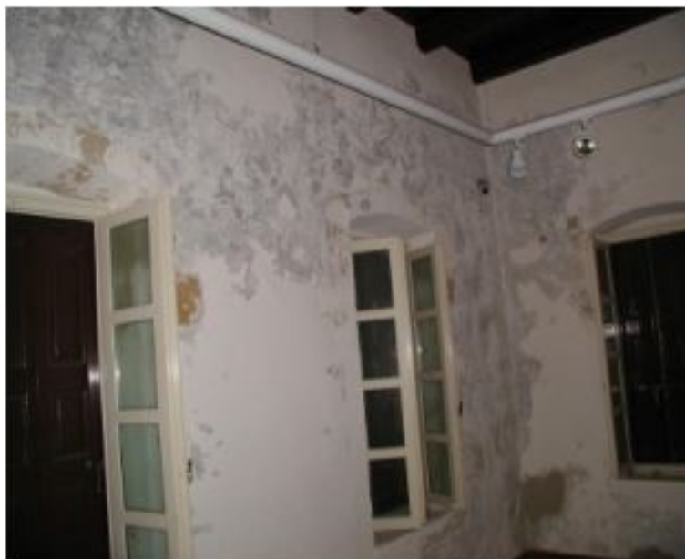
Εικόνα 1.4 : Η Β.Α γωνία στο εσωτερικό τμήμα του ορόφου με έντονη υγρασία και αποκόλληση βαφής.
