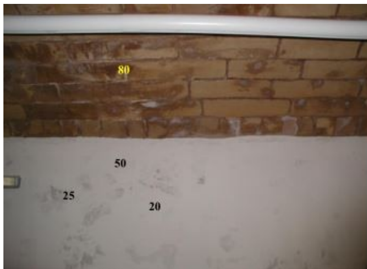
Εικόνα 1.5 :Ισόγειο , ανατολική αίθουσα, βόρειο τόξο δυτικού τοίχου. Λεπτομέρεια από τον θολο με την παρουσία αλάτων και τις % τιμές της υγρασίας
