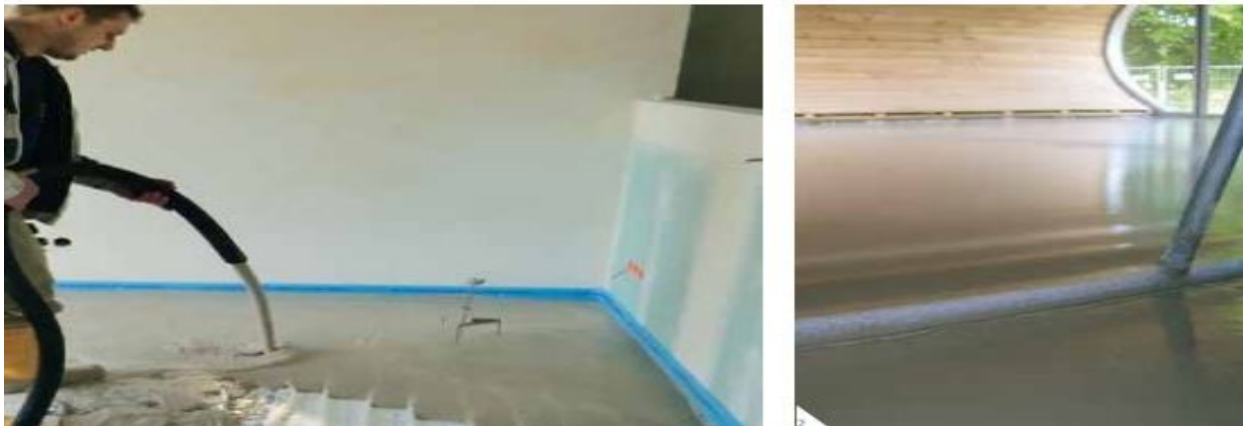
Εικόνα 2.12 : Βολική εγκατάσταση ξηρού κονιάματος και εύκολο φινίρισμα επιφάνειας
