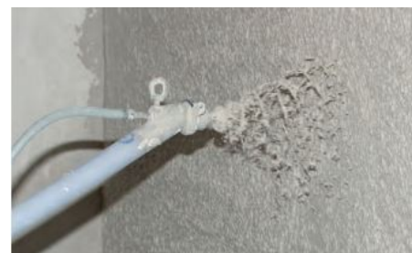
Εικόνα 2.7 : Εσωτερικό επίχρισμα βάσης με μηχανή
