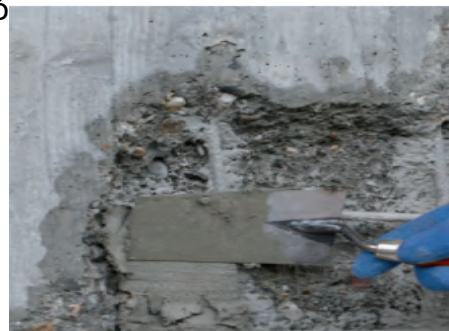
Εικόνα 2.4 : Επισκευή δομικού και μη δομικού σκυροδέματος
