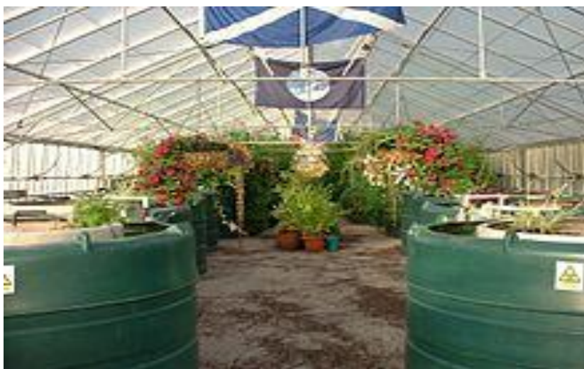
ΕΙΚΟΝΑ 44. Η εγκατάσταση επεξεργασίας λυμάτων Living Machine στο Findhorn
