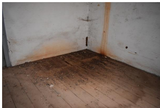
Εικ. 127: Σανίδες πατώματος ορόφου με εκτεταμένη υγρασία
