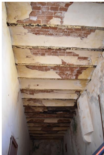
Εικ.101 : Οροφή στοάς με θολίσκους από οπτόπλινθους
