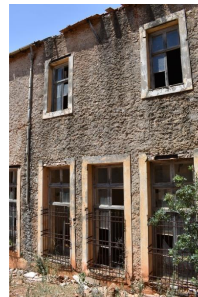
Εικ. 144: Υγρασία στην Ανατολική όψη λόγω κατεστραμμένης υδρορροής
