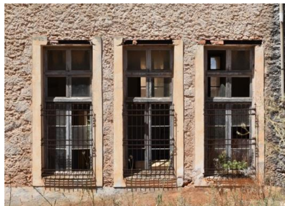
Εικ. 146: Οξείδωση σιδηροδοκών στα υπέρθυρα
