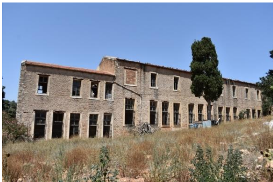
Εικ. 87: Επίχρισμα ανατολικής όψης από αδρό κονίαμα.
