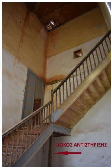
Εικ.152 : Προσωρινή αντιστήριξη του άνω πλατύσκαλου με ξύλινη δοκό.
