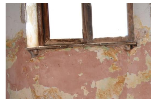
Εικ. 112: Ξύλινα δοκάρια κάτω από την ποδιά των παραθύρων
