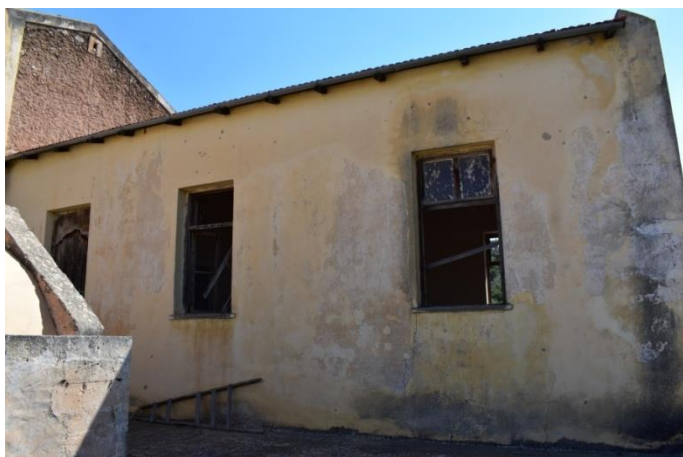
Εικ.141 : Αποσάθρωση κονιάματος και υγρασία στο νότιο τμήμα του κτηρίου
