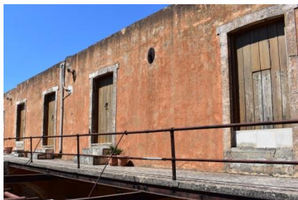
Εικ. 80: Κοκκινωπό ασβεστοκονίαμα Μονής
