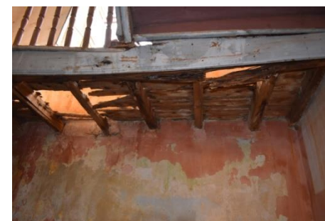
Εικ.153-154 : Άποψη του πλατύσκαλου με εμφανή την υποχώρηση που παρουσιάζει
