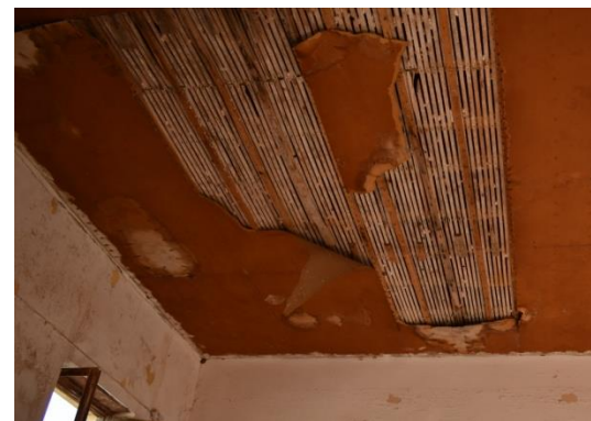
Εικ. 104: Οροφή νότιου τμήματος ορόφου με πηχάκια και επένδυση από φύλλα hardboard
