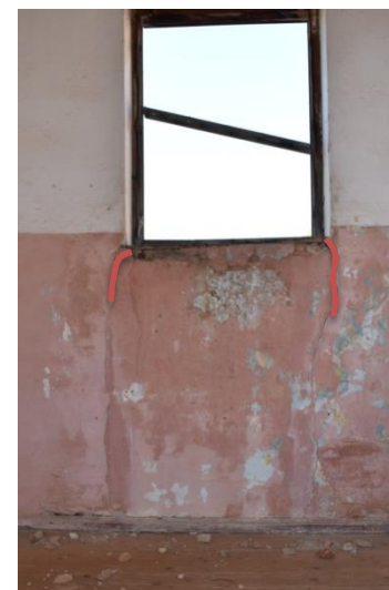
Εικ.135-136 : Ρωγμές στα υπέρθυρα και στις ποδιές των ανοιγμάτων αντίστοιχα
