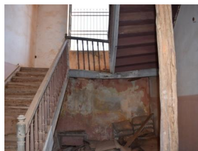
Εικ.153-154 : Άποψη του πλατύσκαλου με εμφανή την υποχώρηση που παρουσιάζει
