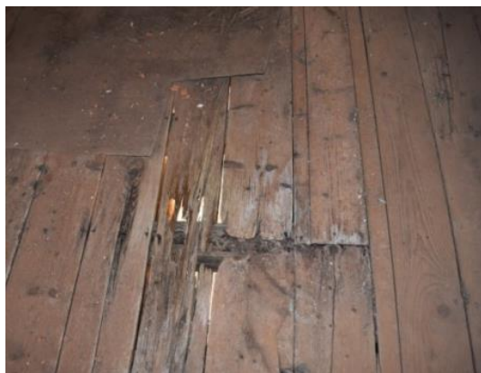
Εικ.126 : Σανίδες πατώματος ορόφου που έχουν σαπίσει
