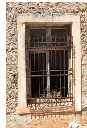
Εικ. 147: Οξείδωση κιγκλιδωμάτων
