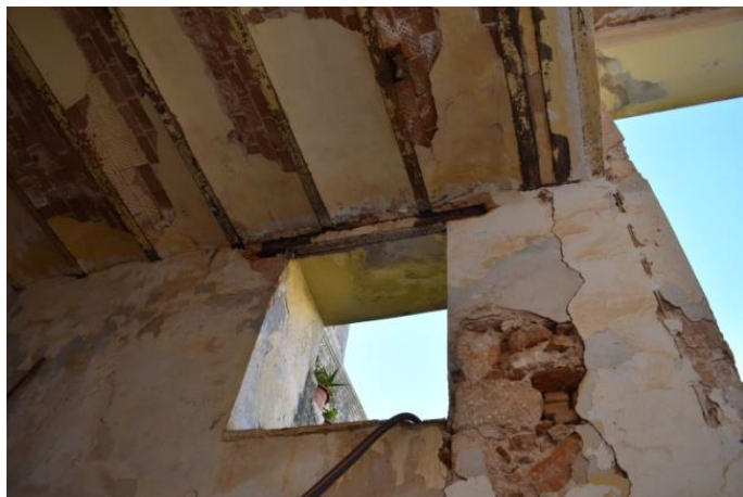
Εικ. 145: Οξείδωση σιδηροδοκών
