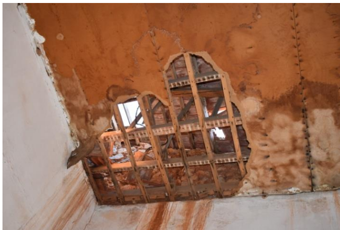
Εικ. 124: Κατάρρευση ταβανώματος λόγω κενού στη στέγη στο δωμάτιο του επιτηρητή
