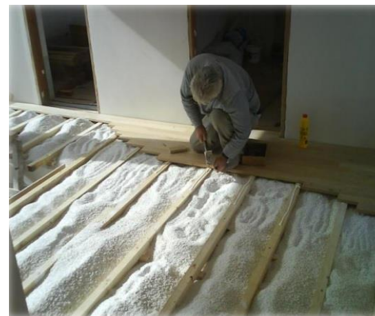
Εικ.162 : Τοποθέτηση μόνωσης στο δάπεδο
