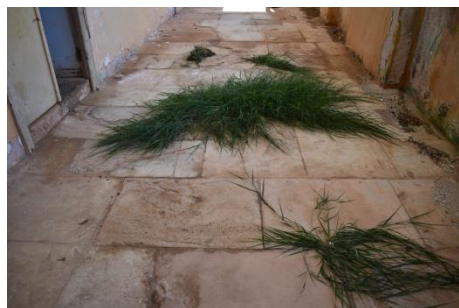
Εικ. 131: Ανάπτυξη βλάστησης στο δάπεδο της στοάς και κυψέλωση των λίθων.
