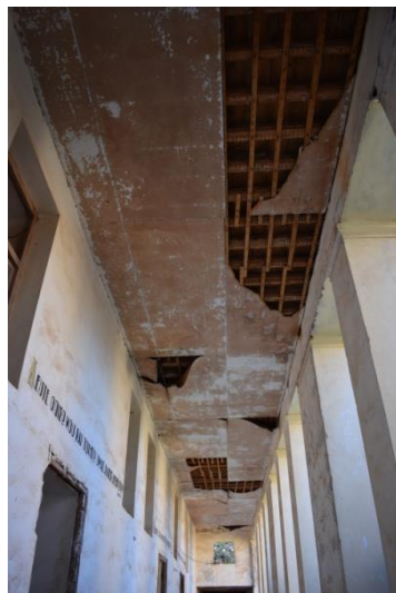
Εικ. 102: Ξύλινη οροφή στοάς με επένδυση από φύλλα hardboard
