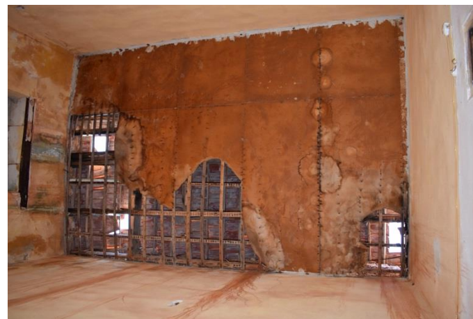
Εικ.125: Κατάρρευση ταβανώματος κεντρικού κλιμακοστασίου
