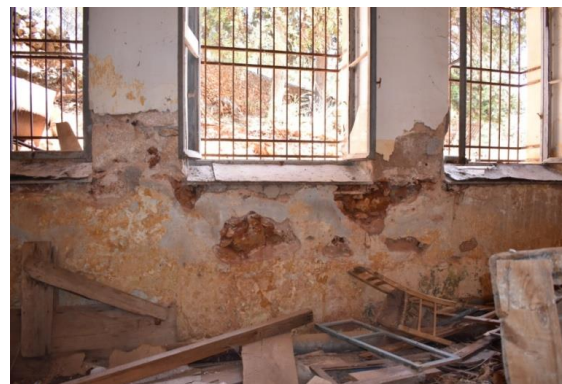
Εικ. 140: Αποσάθρωση και αποκόλληση κονιάματος σε αίθουσα του ισόγειου
