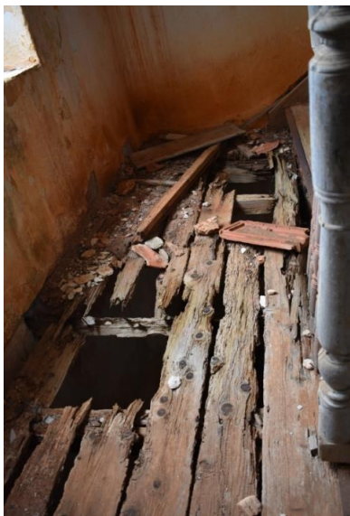
Εικ.151: Κατεστραμμένες σανίδες στο πλατύσκαλο
