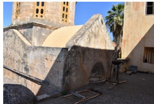
Εικ. 96: Πάτωμα αίθριου από πλάκα οπλισμένου σκυροδέματος και θολίσκους και επικάλυψη από τσιμεντοκονία
