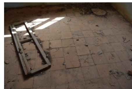
Εικ. 93: Δάπεδο από οπλισμένο σκυρόδεμα και σιδηροδοκούς και επικάλυψη με πλακάκια
