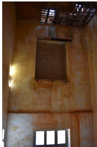
Εικ. 143: Υγρασία στην τοιχοποιία από τα όμβρια ύδατα
