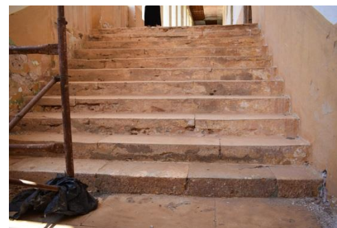
Εικ. 132: Μηχανική καταπόνηση και παραμόρφωση των λίθινων πατημάτων
