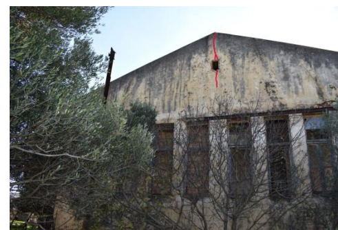
Εικ. 139: Κάθετη ρωγμή στην κορυφή της στέγης
