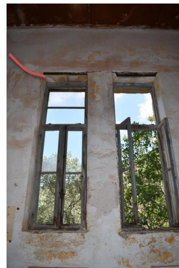
Εικ.135-136 : Ρωγμές στα υπέρθυρα και στις ποδιές των ανοιγμάτων αντίστοιχα
