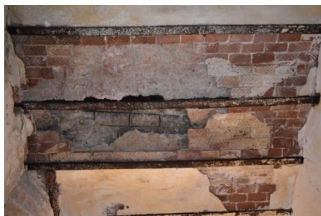
Εικ. 130: Θολίσκος που έχει υποστεί οξείδωση των σιδηροδοκών, αποκόλληση του κονιάματος και πτώση των οπτόπλινθων
