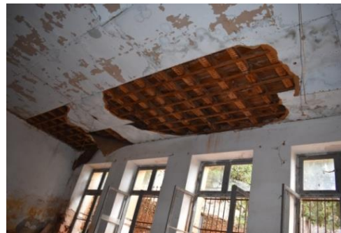
Εικ. 128: Κατάρρευση ταβανώματος σε αίθουσα του ισογείου
