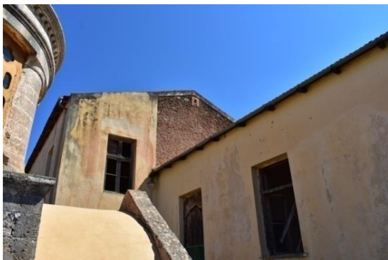
Εικ. 88: Τμήμα νότιας όψης που είναι επιχρισμένο με αδρό και ψιλό κονίαμα.
