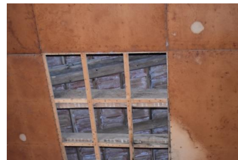
Εικ. 103: Οροφή βόρειου τμήματος ορόφου με επένδυση από φύλλα hardboard
