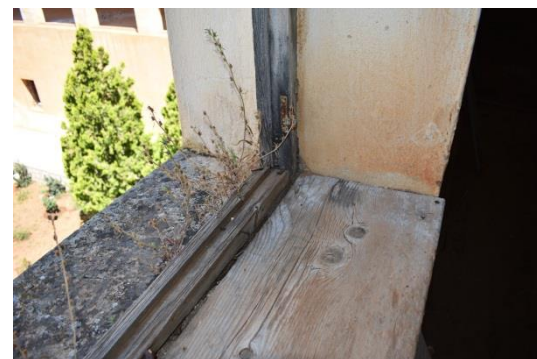
Εικ. 119: Ποδιά σε παράθυρο στον όροφο. Διακρίνεται η τσιμεντοκονία στην εξωτερική πλευρά
