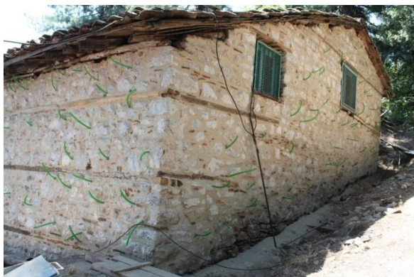
Εικ.159: Αρμολόγημα και ενέματα σε τοιχοποιία από αργολιθοδομή
