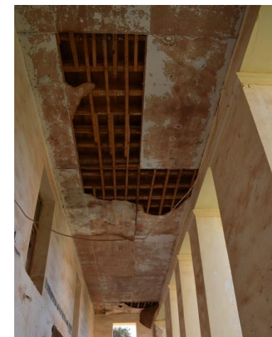
Εικ. 129: Κατάρρευση ταβανώματος στη στοά
