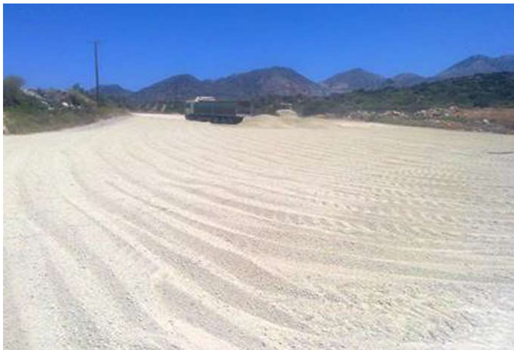
Εικόνα 1.7-2: Φυσική ξήρανση μπεντονίτη στο Μελιδόνη Ρεθύμνου (Κρήτη)
