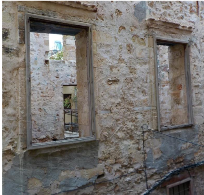
Εικόνα 22: Τοπική επισκευή με τσιμεντοκονίαμα
