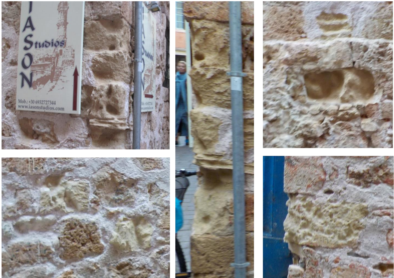
Εικόνα 2: Κυψέλωση - στρογγυλοποίηση
