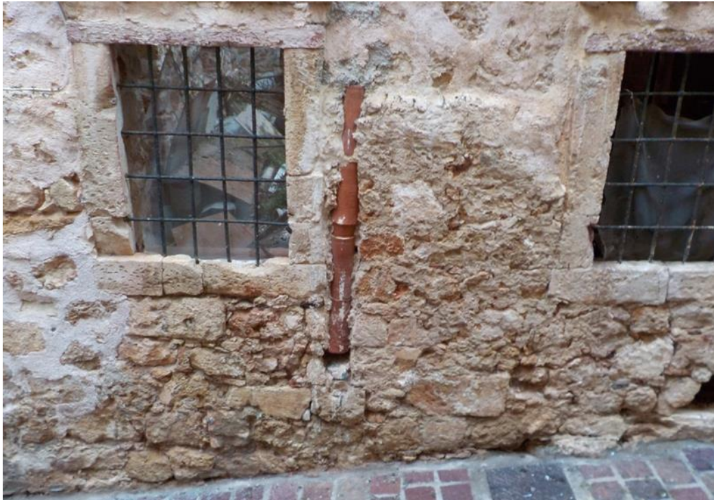
Εικόνα 1: Ανοδική υγρασία – φαινόμενα κρυπτοεξάνθησης
