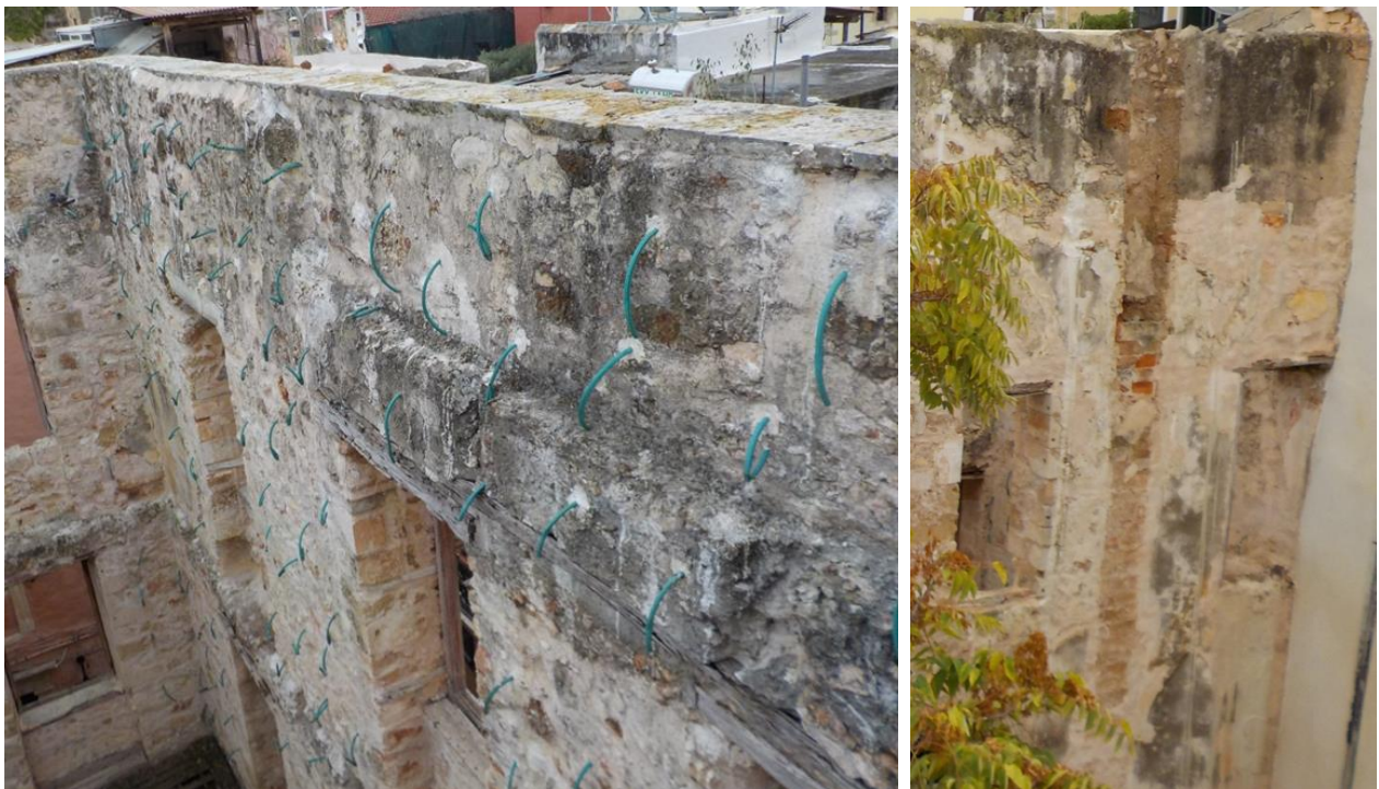
Εικόνα 13: Μαύρη κρούστα λόγω βιολογικών επιδράσεων.
