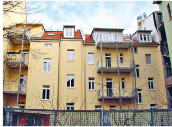
Εικόνα 62: Ενεργειακή αναβάθμιση ιστορικού κτιρίου με εσωτερική θερμομόνωση στην πρόσοψη και εξωτερική στην πίσω όψη. Η ανάγκη για θέρμανση μπορεί να μειωθεί έως και 80% χωρίς να αλλοιωθούν τα αρχιτεκτονικά χαρακτηριστικά του κτιρίου[39]
