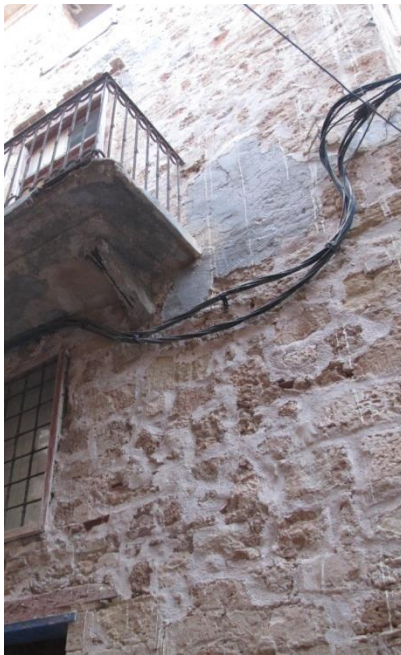
Εικόνα 21: Βαθύ αρμολόγημα που διατηρείται σε καλή κατάσταση σε μεγάλο ποσοστό της τοιχοποιίας
