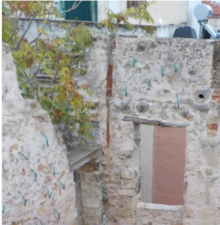
Εικόνα 18: Κατάρρευση τμήματος της βορινής όψης μέχρι το παράθυρο του τελευταίου ορόφου
