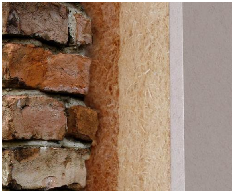
Εικόνα 67: Εφαρμογή του συστήματος εσωτερικής θερμομόνωσης με χρήση εύκαμπτης στρώσης από ίνες ξύλου, ώστε να αποφευχθεί - εν ξηρώ - η ύπαρξη κενών μεταξύ τοιχοποιίας και θερμομόνωσης χωρίς να χρειάζεται εξομάλυνση της επιφάνειας εφαρμογής[49]
