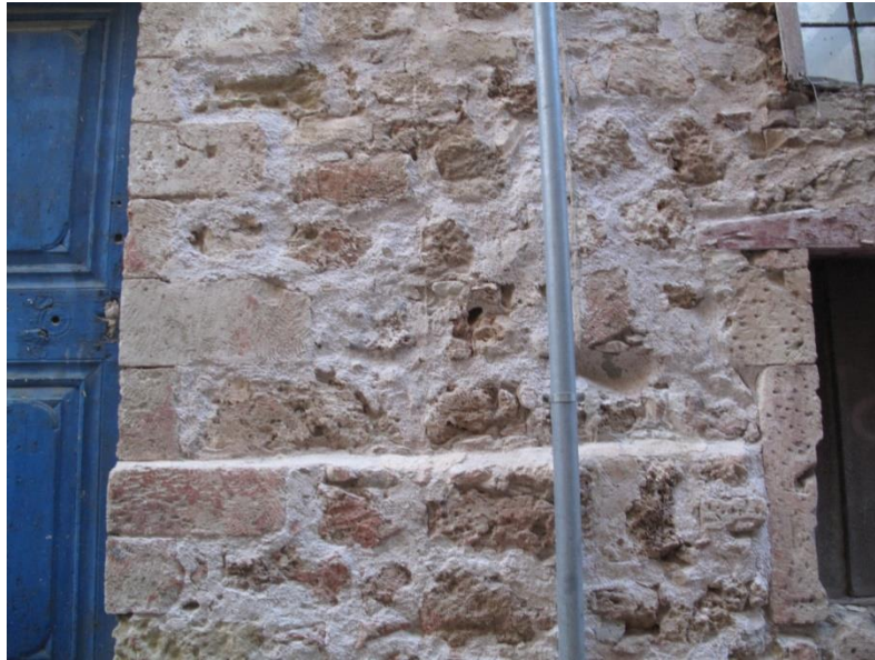
Εικόνα 21: Βαθύ αρμολόγημα που διατηρείται σε καλή κατάσταση σε μεγάλο ποσοστό της τοιχοποιίας
