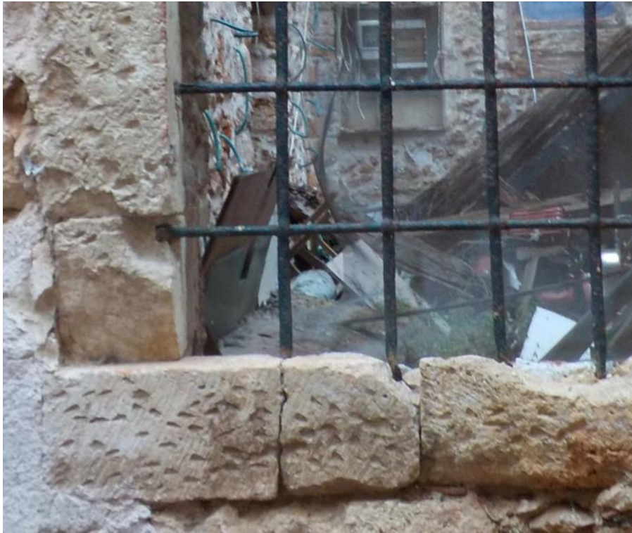
Εικόνα 3: Απώλεια υλικού λόγω μηχανικών καταπονήσεων
