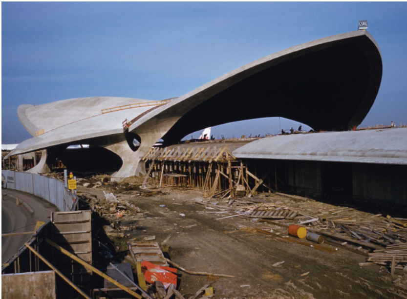
Εικ. 112: Κέλυφος από σκυρόδεμα, κατά την κατασκευή.
