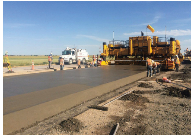
Εικ. 17: Slipform pavers στο αεροδρόμιο του Denver.
