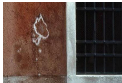
Εικόνα 1.1: Εξανθήσεις από κρυστάλλωση NaCl σε τοίχο της Βενετίας (πηγή: Διάλεξη_2_3_Φθορές από νερό και αλάτα, Νόνη Μαραβελάκη, Open e-class.tuc)
