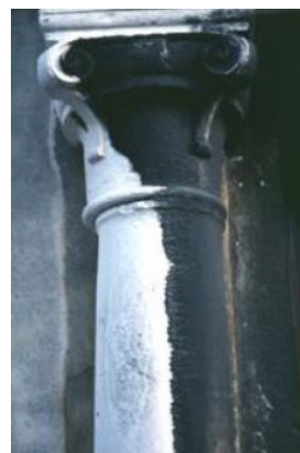
Εικόνα 1.2: Μαύρη κρούστα από κολώνα στη Βενετία (πηγή: Διάλεξη_2_3_Φθορές από νερό και αλάτα, Νόνη Μαραβελάκη, Open e-class.tuc)
