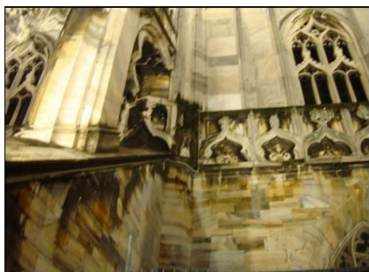
Εικόνα 1.7: Βιολογική διάβρωση Duomo di Milano (πηγή: Διάλεξη_2_3_Φθορές από νερό και άλατα, Νόνη Μαραβελάκη, Open e-class tuc)
