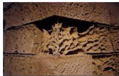
Εικόνα 1.5: Κυψέλωση (πηγή: Διάλεξη_2_3_ Φθορές από νερό και άλατα, Νόνη Μαραβελάκη, Open e-class tuc, ICOMOS-ISCS "Illustrated glossary on stone deterioration patterns", Champigny/Marne, France, 2008.)
