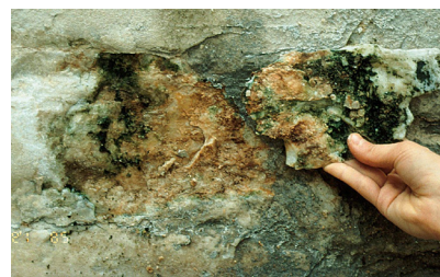
Εικόνα 1.3: Διάβρωση επιφάνειας από βιολογικούς παράγοντες © Αρχείο ΥΣΜΑ
