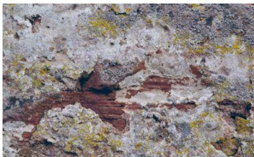
Εικόνα 31: Απομεινάρια σημείου εκκένωσης και προστατευτικών στρωμάτων πηλοκονιαμάτων σε έναν τοίχο στα σύνορα της Σκωτίας που πιθανώς χρονολογείται από τις αρχές του 19ου αιώνα, Πηγή: Clay Mortars for Masonry Buildings, Planners and Owners, Conservation and Heritage Enthusiasts, 01 June 2015
