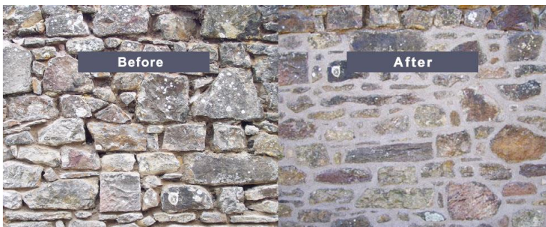
Εικόνα 35: Η χρήση ασβεστοκονιάματος επιτρέπει την αναπνοή στα κτίρια. Αυτό βοηθά στην πρόληψη του «σύνδρομου ασθενούς σπιτιού» που μπορεί να συμβεί με κονίαμα τσιμέντου, η οποία προκαλεί ταχεία επιτάχυνση της αποσύνθεσης λόγω της υπερβολικής υγρασίας, Πηγή: set in stone stonemasons
