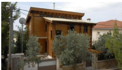
Εικόνα 40: Μονοκατοικία στη Διώνη. Βιοκλιματικός σχεδιασμός : Αρχιτέκτονες STUDIO 3+1architects. Κατασκευή: WANDS ΒΑΣΙΛΑΪΝΑΣ – Α. ΒΑΣΙΛΑΪΝΑΣ Ε.Ε www.wands.gr (2009). Τα ανοίγματα στη βορινή όψη είναι μικρότερα για την προστασία από τους Β-ΒΑ ανέμους και διακρίνονται οι φεγγίτες αερισμού για το θέρμα
