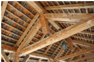
Εικόνα 37: Ξύλινο Ζευκτό, Πηγή: http://www.4myhouse.gr
