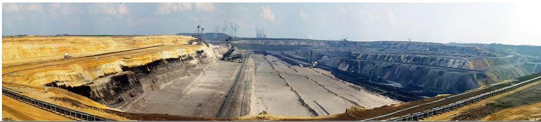
Σχ. 2: Υπαίθρια εκμετάλλευση κατά λωρίδες σε κοίτασμα λιγνίτη ( Strip mining at Garzweiler, Germany, Wikipedia ).
