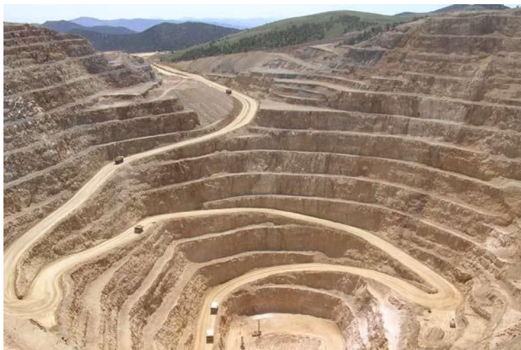
Σχ. 4: Υπαίθρια εκμετάλλευση. Αρχικά διακρίνονται ορθές βαθμίδες ανοικτού τύπου στα ανώτερα υψόμετρα και όσο αυξάνεται το βάθος εκσκαφής μετατρέπονται σε κλειστού τύπου ( http://www.mining-technology.com/contractors/project/marston/attachment/marston4/ ).
