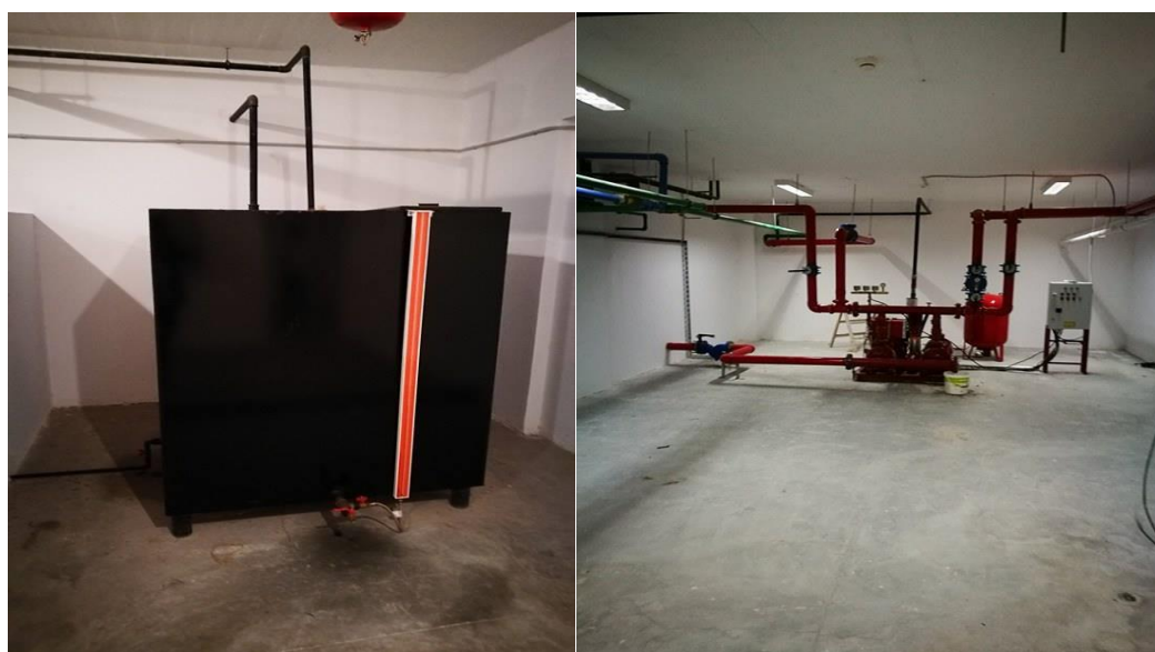
Εικόνα 4.9: Φωτογραφίες υπάρχοντος συστήματος λέβητα πετρελαίου του 1 ου - 19 ου Δημοτικού Σχολείου Ζωγράφου
