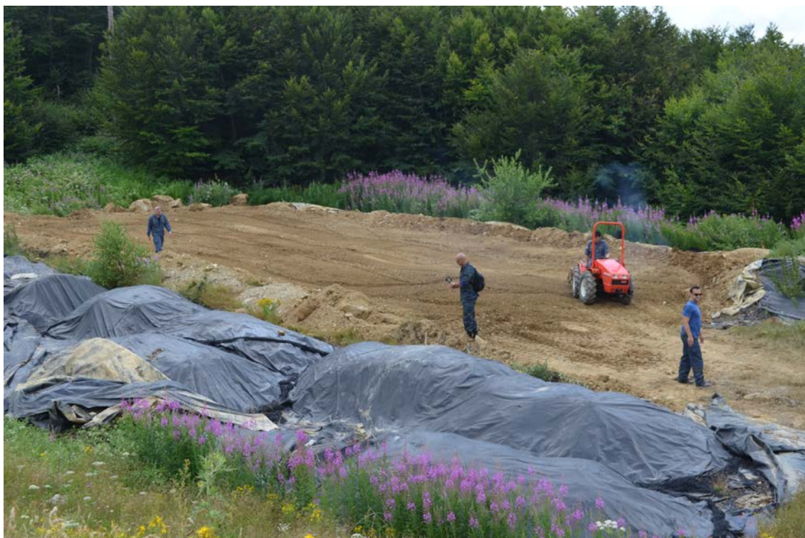
Εικόνα 8: Διαμόρφωση του χώματος προς εξυγίανση με φρέζα
