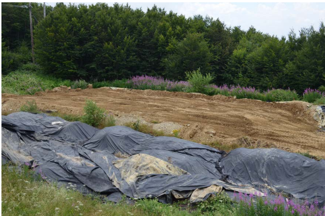
Εικόνα 7: Το LTU μετά τη διαμόρφωση του χώματος προς εξυγίανση
