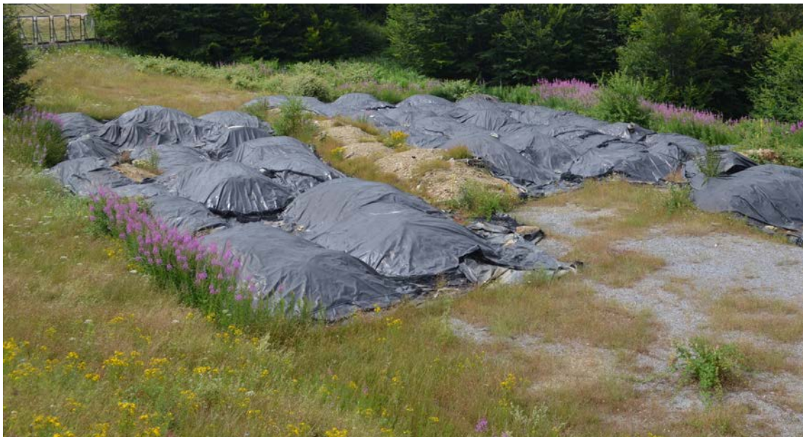
Εικόνα 2: Σωροί προϊόντων εκσκαφής καλυμμένοι με ειδικές μεμβράνες πολυαιθυλενίου
