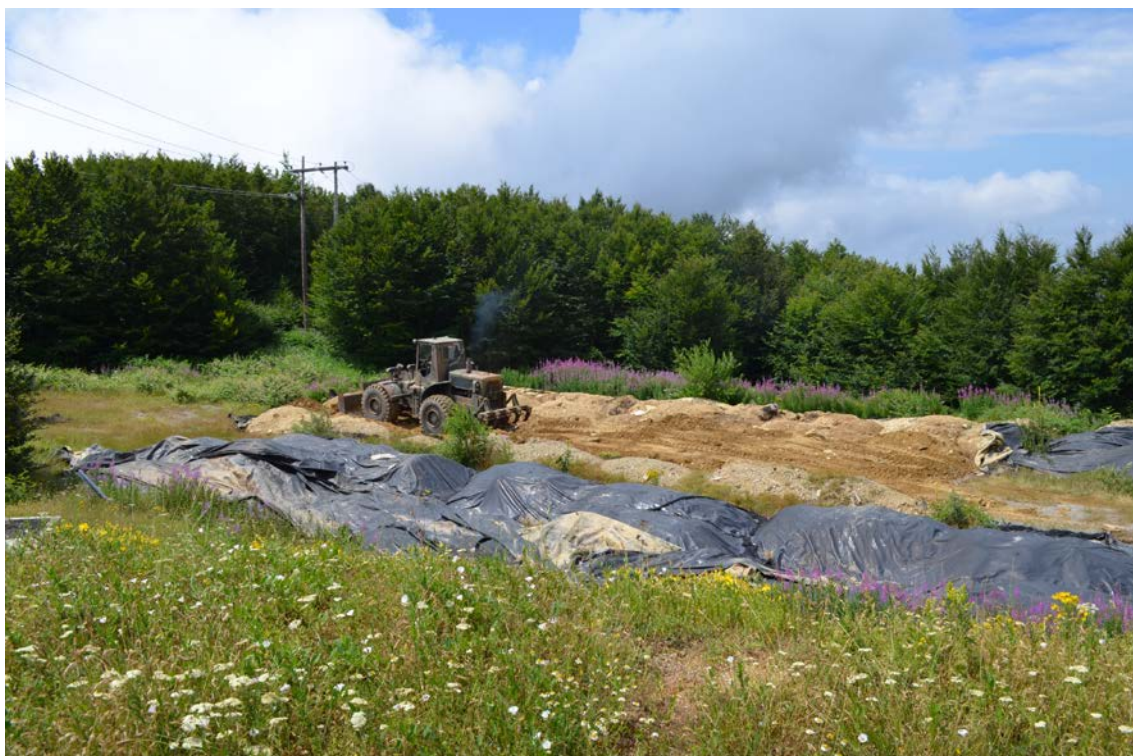
Εικόνα 6: Χρήση γαιοπροωθητή για διαμόρφωση του χώματος στο LTU
