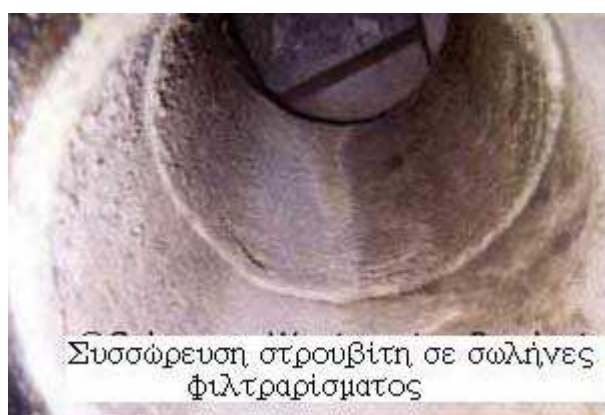
Εικόνα 6: Εναπόθεση στρουβίτη σε σωλήνα διήθησης
