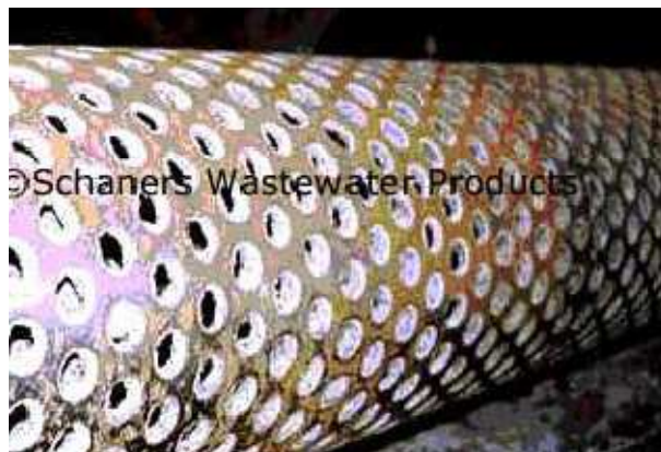
Εικόνα 5: Συσσώρευση στρουβίτη σε σωλήνα
