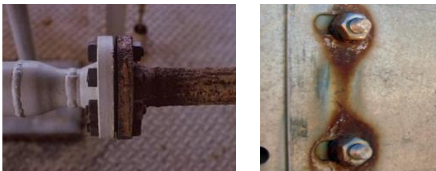
Σχήμα 31. Παράδειγμα γαλβανικής διάβρωσης
