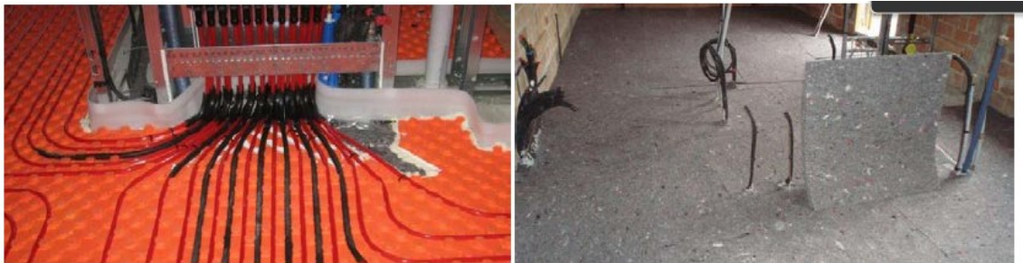
Εικόνα 23: Ενδοδαπέδια θέρμανση και τοποθέτηση πατώματος πάνω από αυτή [Mora et al., 2015]
