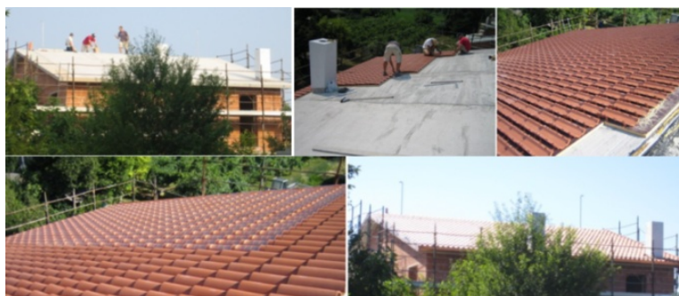
Εικόνα 47: Τοποθέτηση Φ/Β κεραμιδιών
