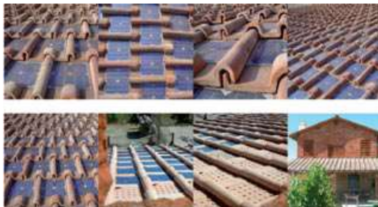
Εικόνα 15: Ενσωμάτωση φωτοβολταϊκών κεραμιδιών κατά τη διάρκεια αποκατάστασης του κάστρου
