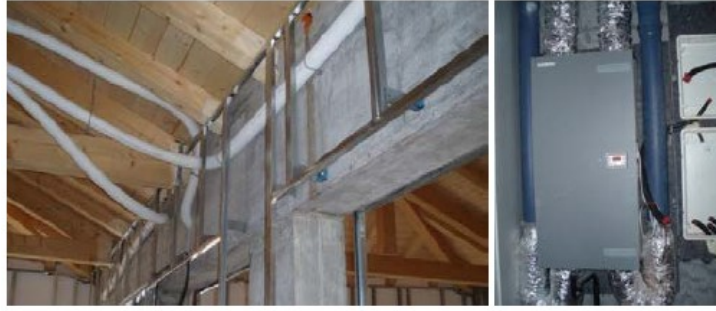
Εικόνα 22: Εγκατάσταση συστήματος μηχανικού αερισμού [Mora et al., 2015]
