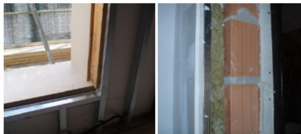
Εικόνα 24: Τοποθέτηση θερμομόνωσης σε εσωτερικούς και εξωτερικούς τοίχους [Mora et al., 2015]
