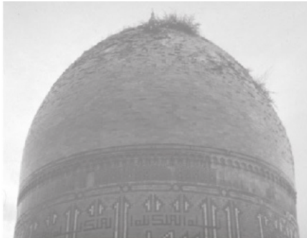
εικ. 37: τα κεραμίδια ενός τζαμιού στη Samar-kand, όπου σπόροι που μεταφέρθηκαν από τον αέρα και δημιούργησαν βλάστηση, μαζί με άλλους παράγοντες όπως ο παγετός, συνέβαλαν στη σταδιακή φθορά. Croci, The Conservation and Structural Restoration of Architectural Heritage, 1988, σελ. 45
