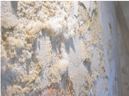
εικ. 36: εξάνθημα , μαθήμα: Φθορά & Συντήρηση Δομικών Υλικών Μνημείων & Αρχιτεκτονικών Επιφανειών, διάλεξη 3, διαφάνεια 24
