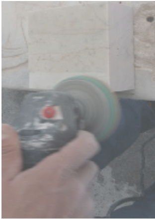
εικ. 49: καθαρισμός με γυαλόχαρτο Αλεξοπούλου et al, Τεχνική Αναφορά Εργαστηριακής Άσκησης, Π.Κ., 2016
