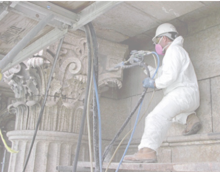
εικ. 38: ο καθαρισμός με αμμοβολή υψηλής πίεσης, εν υγρώ ή εν ξηρώ, είναι μία από τις καταστρεπτικές μεθόδους που χρησιμοποιήθηκαν στο περελθόν www.buildingconservation.com/articles/
