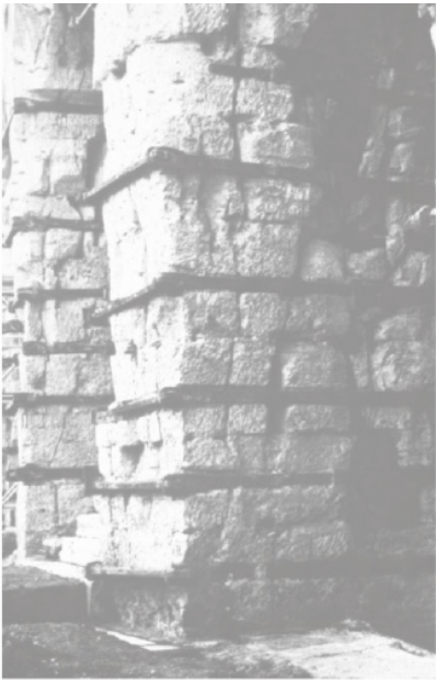
εικ. 35: βλάβες και αλλοιώσεις στους πυλώνες του Colosseum, ενισχυμένους με συνδετήρες στις αρχές του 19ου αι. Το βρόχινο νερό μπορεί εύκολα να διεισδύσει στις ρωγμές που έχουν προκληθεί από σεισμούς. Croci, The Conservation and Structural Restoration of Architectural Heritage, 1998, σελ. 45
