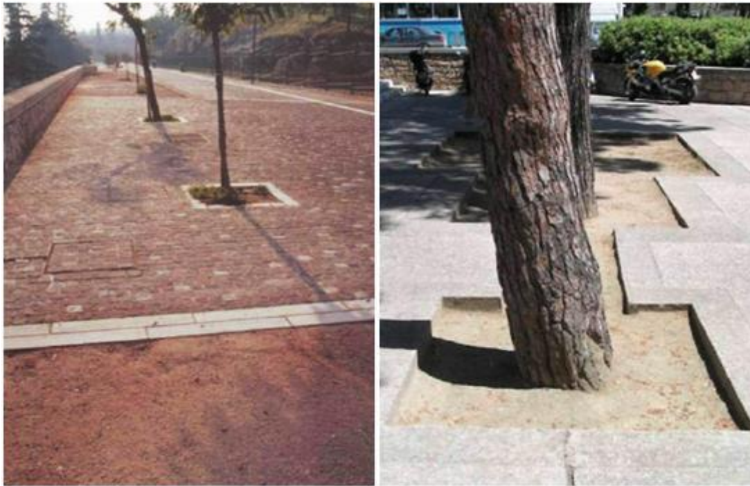
Εικόνα 1.9: Επίστρωση δρόμων και ελεύθερων επιφανειών με υλικά μειωμένης απορροφητικότητας και αυξημένης υδατοπερατότητας [22].
