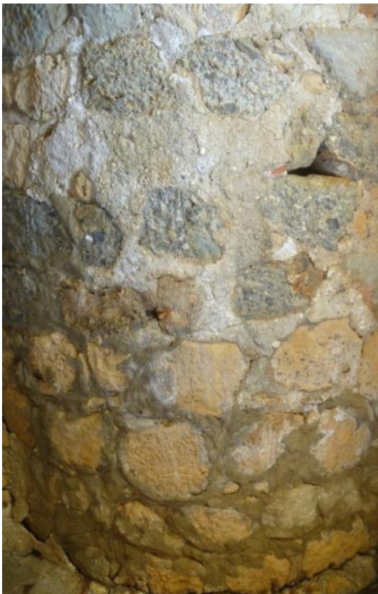
Εικόνα 99 Η τοιχοποιία του πύργου. Διακρίνονται οι ημιλαξευτοί λίθοι
