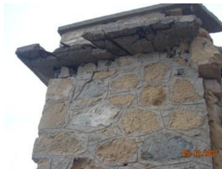
Εικόνα 151 Διάβρωση του σκυροδέματος της πλάκας στο σημείο του γείσου. Διακρίνεται ο τρόπος έδρασής της πάνω στην τοιχοποιία χωρίς περιμετρικό σενάζ
