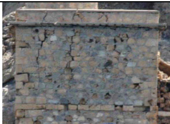
Εικόνα 127 Κατακόρυφες διαμπερείς ρωγμές στο Βόρειο τοίχο
