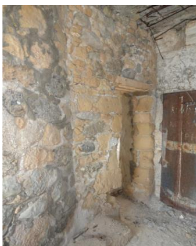
Εικόνα 155 Η σύνδεση του πύργου με την περιμετρική τοιχοποιία εγκάρσιο τοίχος
