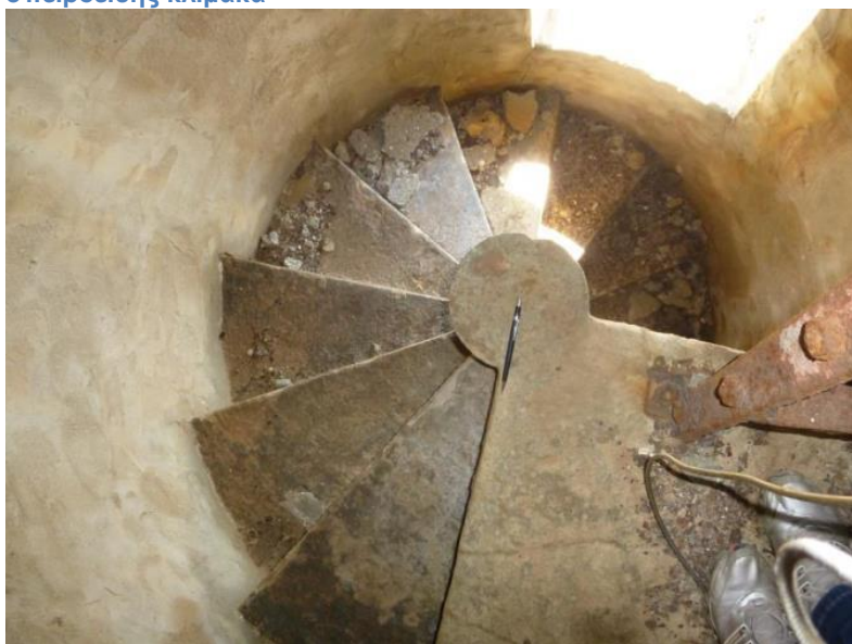
Εικόνα 107 Η απόληξη της κλίμακας. Διακρίνεται το πέτρινο πλατύσκαλο
