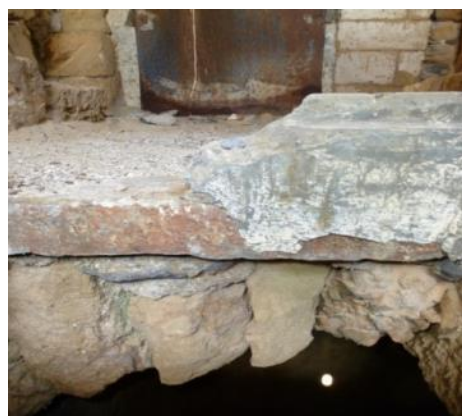
Εικόνα 144 Τομή του δαπέδου της κουζίνας που αποτελεί την οροφή της δεξαμενής
