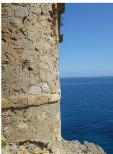
Εικόνα 104 Τα τσιμεντιτικά κονιάματα της εξωτερικής όψης του πύργου
