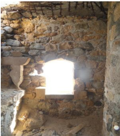
Εικόνα 125 Έντονη αποδιοργάνωση των λαξευμένων λίθων των παραστάδων των παραθύρων
