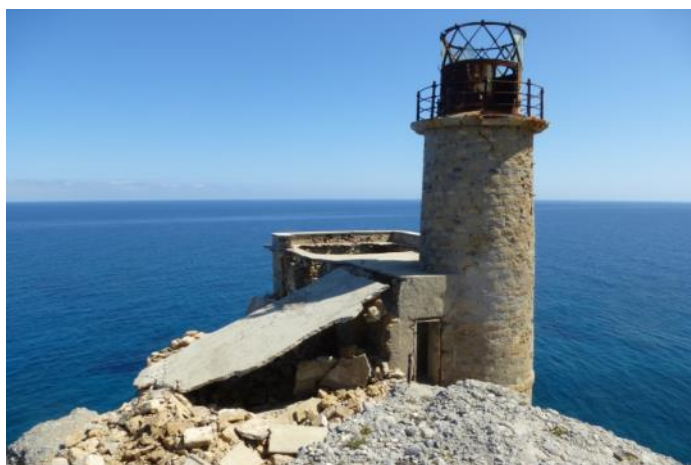
Εικόνα 145 Ολική κατάρρευση της πλάκας της Α φάσης (αριστερά)
