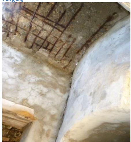
Εικόνα 156 Η αποσύνδεση του πύργου με την περιμετρική τοιχοποιία. Διακρίνεται η οξείδωση του οπλισμού της πλάκας
