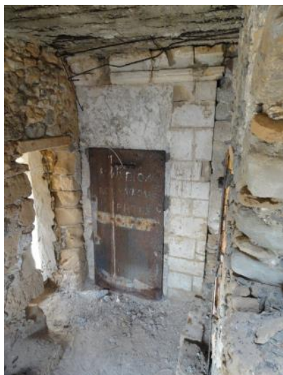
Εικόνα 162 Ελλιπής σύνδεση μεταξύ του Νότιου τοίχου της κουζίνας
