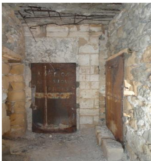
Εικόνα 140 Στην εσωτερική πλευρά της τοιχοποιίας διατηρούνται τα αρχικά συνδετικά κονιάματα στο δωμάτιο Γ
