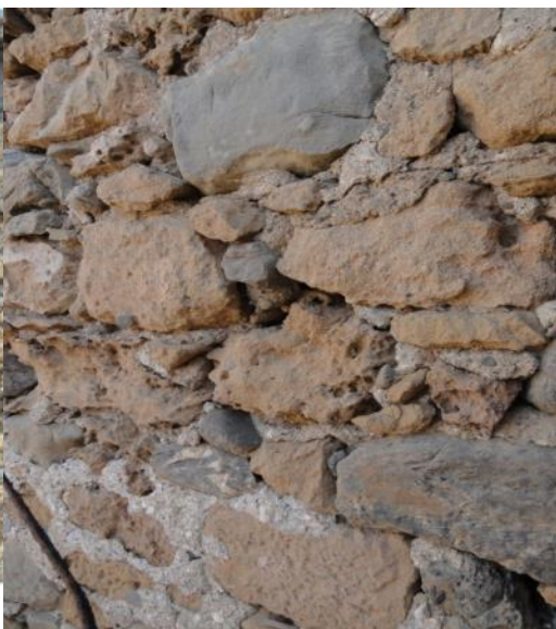
Εικόνα 81 Τοιχοποιία της Β φάσης εσωτερικά με παρουσία ημικατεργασμένων και ακατέργαστων λίθων
