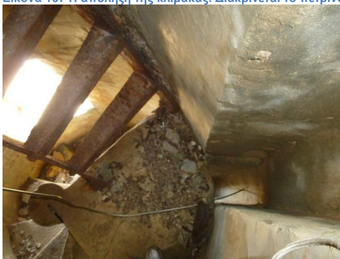
Εικόνα 108 Η έδραση της μεταλλικής σκάλας στο πέτρινο πλατύσκαλο
