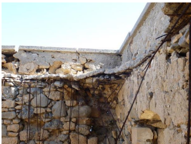
Εικόνα 116 Το περιμετρικό γείσο εσωτερικά της τοιχοποιίας
