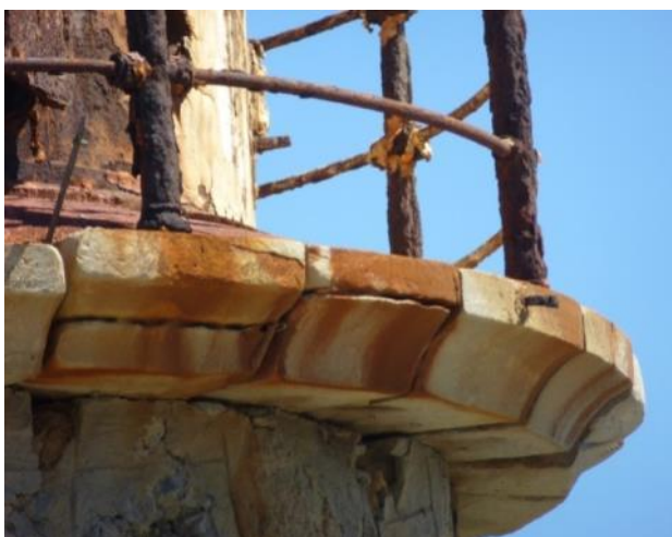
Εικόνα 158 Η αποκόλληση μεταξύ των λίθων του γείσου της στέψης και η οξείδωση του μεταλλικού κιγκλιδώματος
