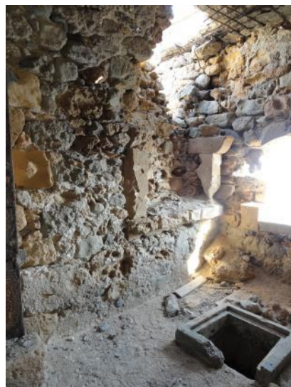
Εικόνα 164 Έντονη αποδιοργάνωση της τοιχοποιίας στον εγκάρσιο τοίχο μεταξύ των δωματίων Γ και Δ
