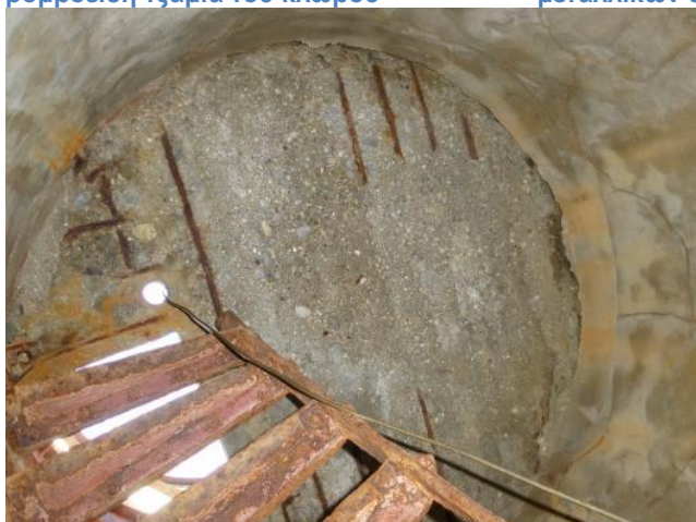
Εικόνα 160 Ο οξειδωμένος οπλισμός της πλάκας του δώματος
