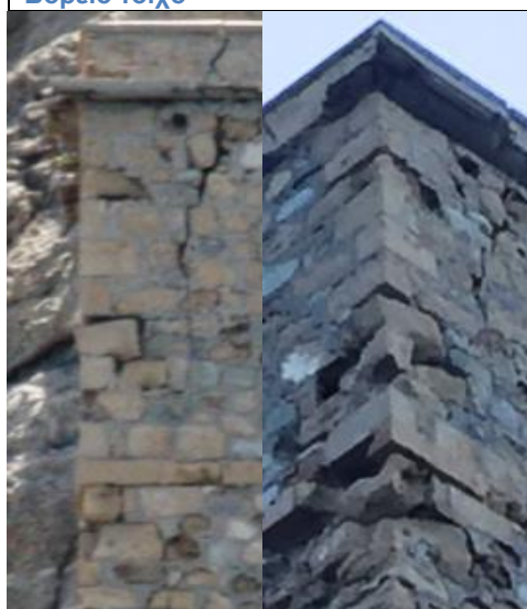
Εικόνα 128 α , β. Αποκόλληση-απότμηση γωνιολίθων στη ΒΑ πλευρά
