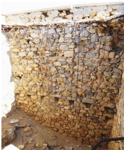
Εικόνα 86 Δωμάτιο Δ: Διακρίνονται οι θέσεις υποδοχής των δοκών
