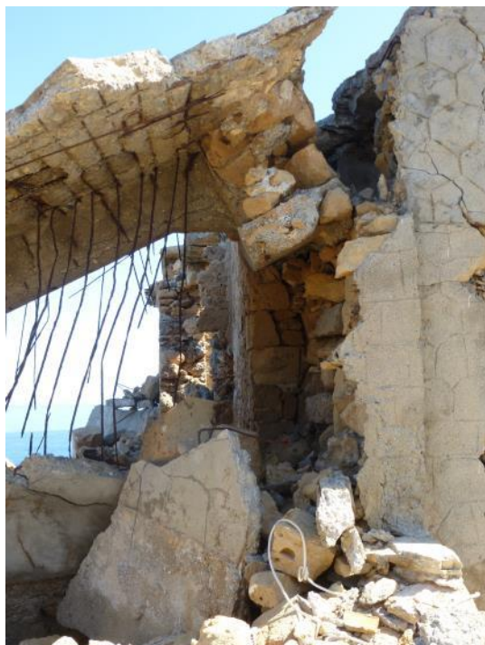
Εικόνα 132 Η αποκόλληση της πλάκας της Α φάσης από τον εγκάρσιο τοίχο
