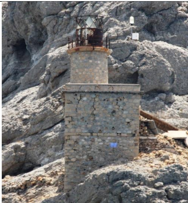
Εικόνα 129 Η Βόρεια όψη της τοιχοποιίας με τις κατακόρυφες ρωγμές
