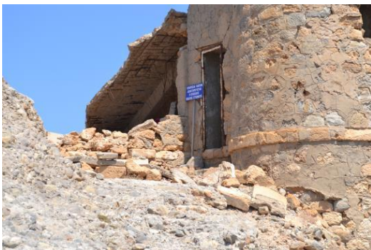
Εικόνα 124 Τμήμα της ανατολικής όψης της Α φάσης. Διακρίνεται το περιμετρικό λίθινο κορδόνι στο ύψος του δαπέδου του ισογείου.
