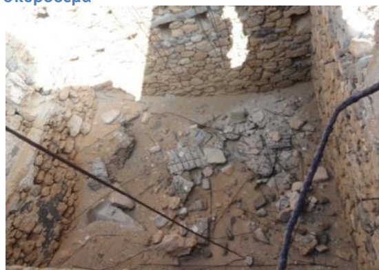
Εικόνα 143 Το κατεστραμμένο δάπεδο του δωματίου Δ. Δεν διακρίνεται το δάπεδο του υπογείου
