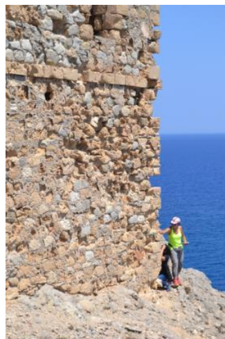
Εικόνα 119 Έντονη αποσάθρωση του υλικού (κυψελώσεις) στην περιοχή κάτω από το περιμετρικό λίθινο κορδόνι και γύρω από τους παραστάδες των παραθύρων
