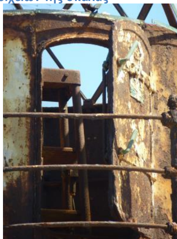
Εικόνα 161 Τα οξειδωμένα μεταλλικά μέλη του κλωβού
