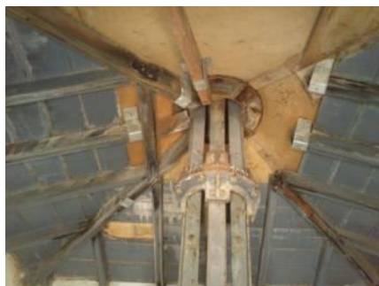
Εικόνα 54 Λεπτομέρεια σύνδεσης του οβελού με την κεραμοσκεπή στο φάρο του Αγίου Νικολάου
