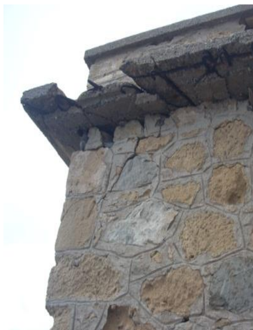
Εικόνα 92 Λεπτομέρεια έδρασης της πλάκας στην περιμετρική τοιχοποιία χωρίς σενάζ
