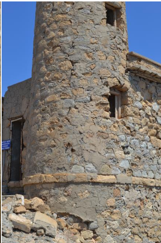
Εικόνα 100 Το πέτρινο κορδόνι που διατρέχει τον πύργο εξωτερικά
