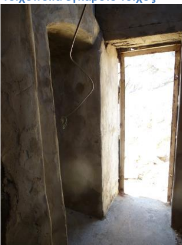
Εικόνα 157 Η είσοδος στο φάρο. Διακρίνονται τα τσιμεντοπλάκα επιχρίσματα
