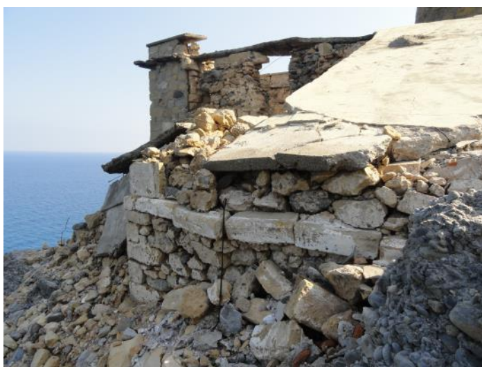
Εικόνα 85 Η κατάρρευση των δωματίων Ε και ΣΤ
