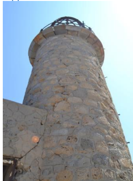
Εικόνα 153 Η εξωτερική ρωγμή στη σύνδεση πύργου-τοιχοποιίας
