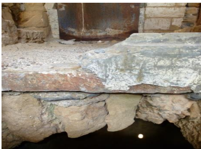
Εικόνα 89 Τομή δαπέδου κουζίνας στο σημείο του ανοίγματος της θολωτής δεξαμενής
