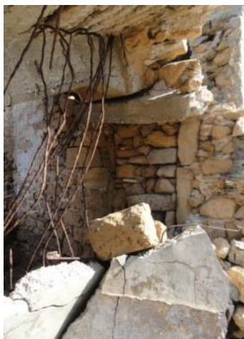
Εικόνα 150 Λεπτομέρεια έδρασης της δοκού πάνω στο πρέκι παλιού κουφώματος
