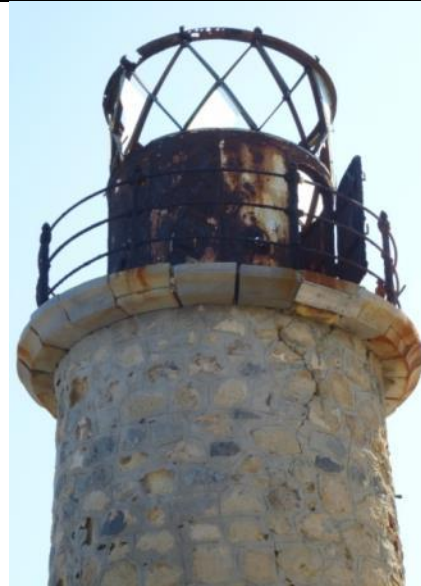
Εικόνα 152 Η ρωγμή στη στέψη του πύργου
