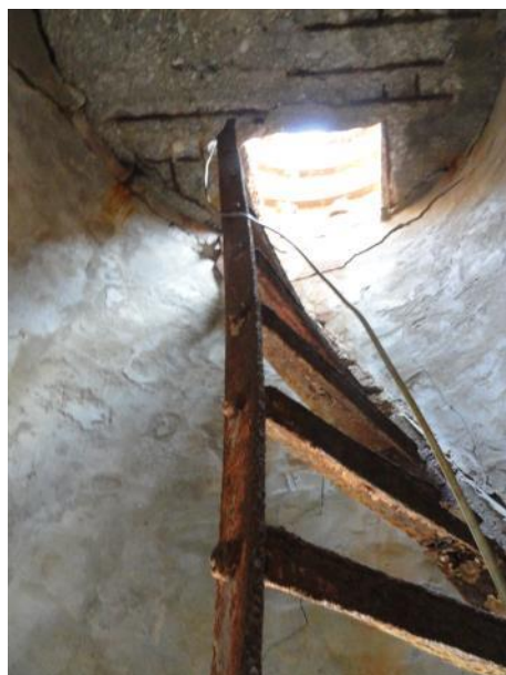
Εικόνα 159 Έντονη οξείδωση των μεταλλικών στοιχείων της σκάλας
