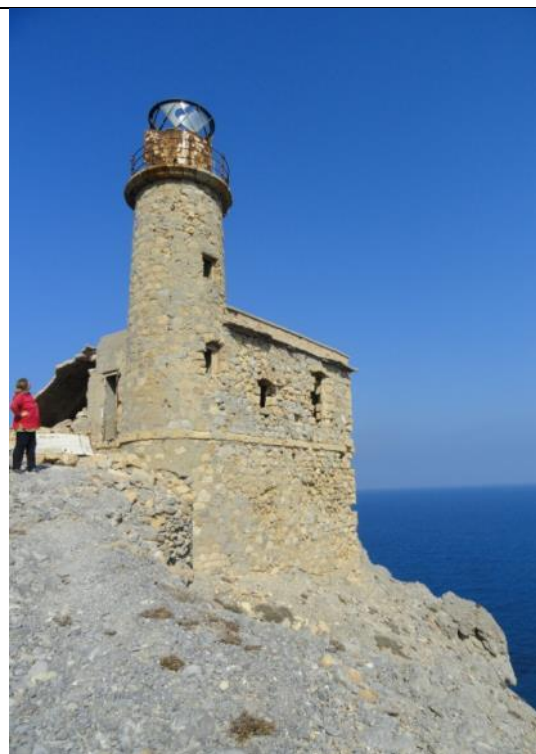
Εικόνα 79 Ο πύργος από τη ΝΑ πλευρά. Διακρίνεται η ανισοσταθμία στη θεμελίωσή του
