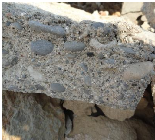
Εικόνα 94 Λεπτομέρεια των υλικών της πλάκας του δώματος. Διακρίνονται τα αδρανή θαλάσσιας προέλευσης
