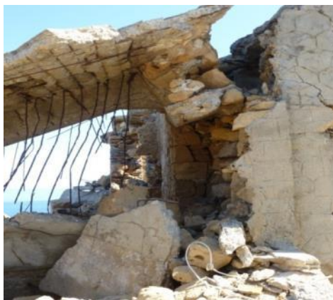
Εικόνα 148 Τμήμα της μεσοτοιχίας που έχει συμπαρασύρει η πλάκα στην Α φάσης
