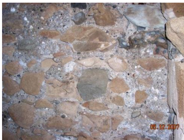
Εικόνα 82 Τοιχοποιία της Β φάσης εσωτερικά (ανατολικός τοίχος).
