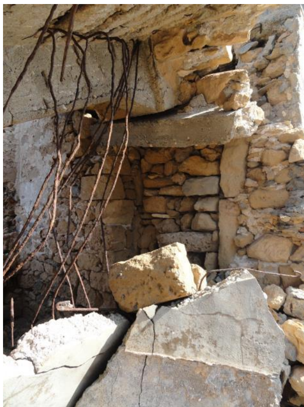
Εικόνα 93 Λεπτομέρεια του τρόπου έδρασης της ενδιάμεσης δοκού της πλάκας της Α φάσης πάνω από παλιό άνοιγμα
