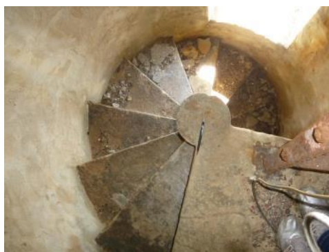
Εικόνα 159 Η πέτρινη κλίμακα ανόδου χωρίς σημαντικές φθορές
