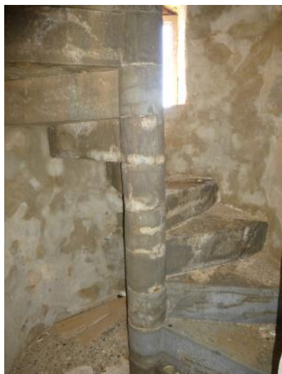
Εικόνα 105 Η λίθινη σπονδυλωτή σπειροειδής κλίμακα
