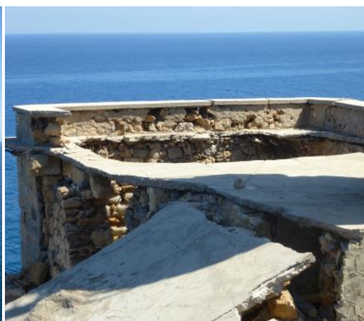
Εικόνα 146 κατάρρευση της ορόφους της πλάκας στο δωμάτιο Δ
