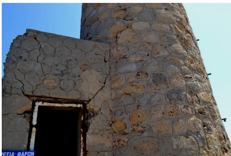
Εικόνα 134 Διαμπερείς διαγώνιες ρηγματώσεις πάνω από το άνοιγμα της πόρτας εισόδου στο σημείο σύνδεσης του δοκαριού της πλάκας οροφής της Α φάσης με τον τοίχο
