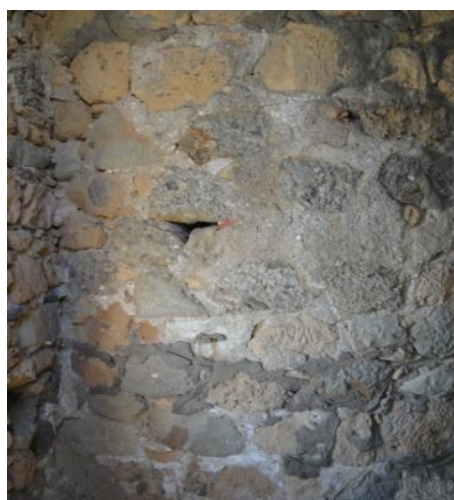
Εικόνα 154 Η σύνδεση του πύργου με την περιμετρική τοιχοποιία ανατολικός τοίχος
