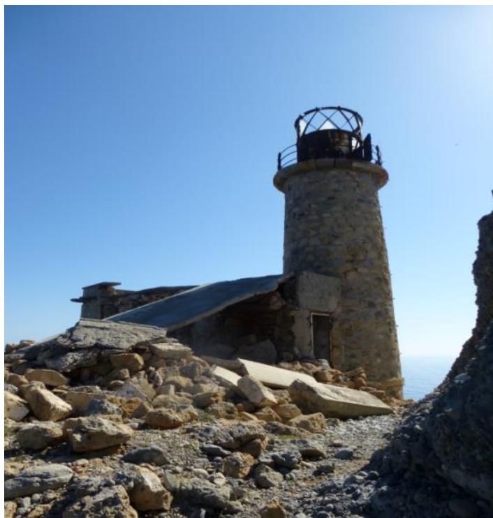
Εικόνα 133 Το τμήματα ης Νότιας όψης που διατηρείται ακέραιο. Διακρίνεται το Νότιο τμήμα της Α φάσης σε κατάρρευση
