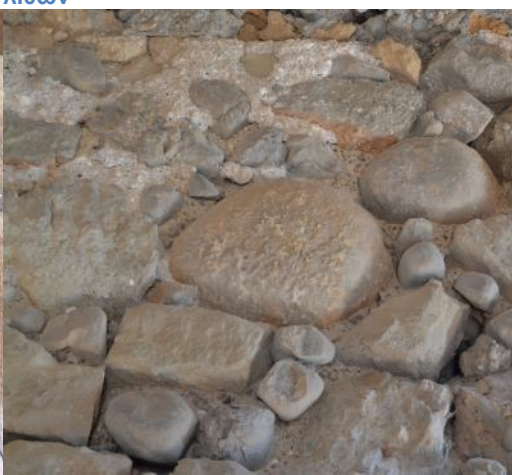
Εικόνα 83 Τοιχοποιία της Β φάσης εσωτερικά (εγκάρσιος τοίχος)
