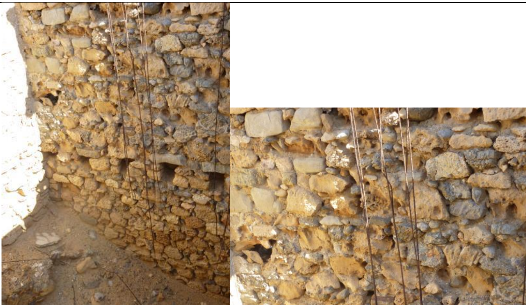
Εικόνα 131 α,β, Απότμηση τμημάτων των λίθων στο περιμετρικό κορδόνι
