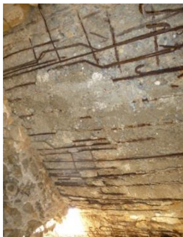
Εικόνα 149 Οξειδωμένος οπλισμός της πλάκας
