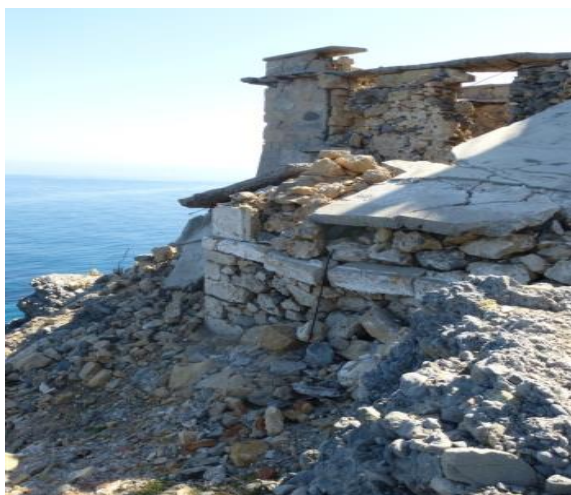
Εικόνα 136 α,β Κατάρρευση της δυτικής τοιχοποιίας της Α φάσης ως το ύψος του περιμετρικού κορδονιού στο ύψος του δαπέδου του ισογείου
