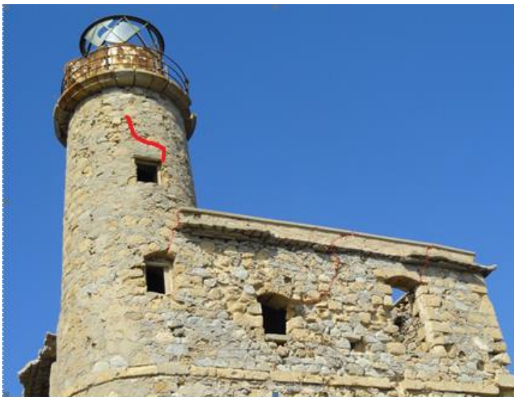
Εικόνα 122 Διαγώνια ρωγμή πάνω από το άνοιγμα του πύργου
