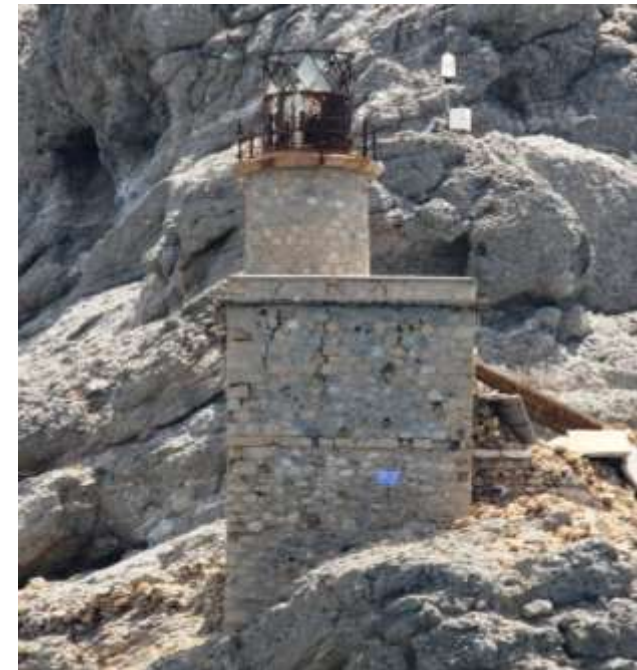
Εικόνα 82: Βόρεια όψη, Διακρίνονται οι τρεις κύριες ρωγμές και η αποδιοργάνωση στην τοιχοποιία
