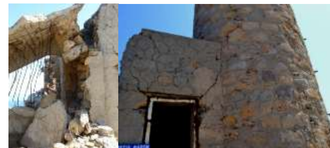
Εικόνα 86: Σημείο αποκόλλησης πλάκας δώματος στην νότια όψη και λεπτομέρεια ρωγμων στην περιοχή της θύρας εισόδου.
