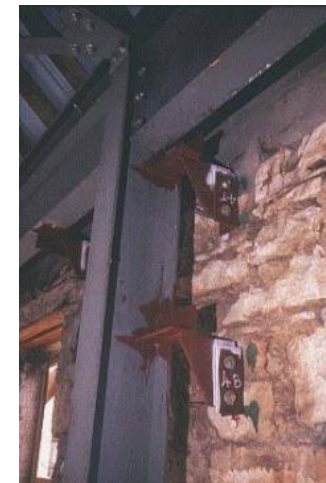
Εικόνα 228: σύνδεση μεταξύ του τοιχώματος και του περιμετρικού δοκαριού με τη χρήση μίας επίπεδης πλάκας & Σύνδεση υποστυλώματος με την τοιχοποιία
