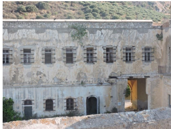
Εικόνα 152: έντονες ρηγματώσεις στην όψη εξωτερικά, στο πάνω μέρος της τοιχοποιίας (επέμβαση με σκυρόδεμα)
