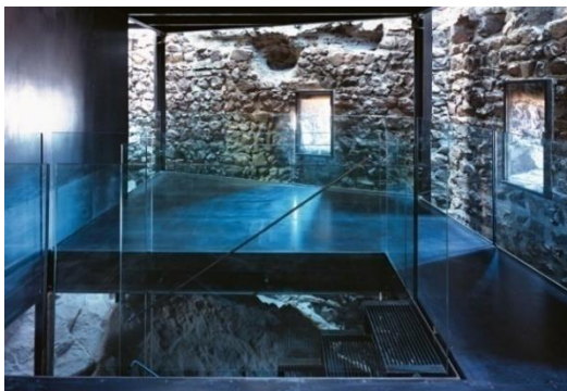
Εικόνα 236 : δημιουργία αρμού μεταξύ νέου δαπέδου και παλιάς πέτρινης όψης
