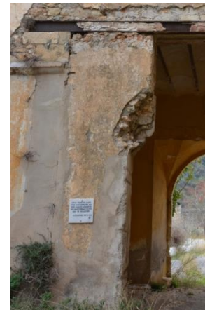
Εικόνα 131: τσιμεντοκονίαμα μετά την κατεδάφιση του δυτικού μανδρότοιχου, δίπλα στην κεντρική είσοδο
