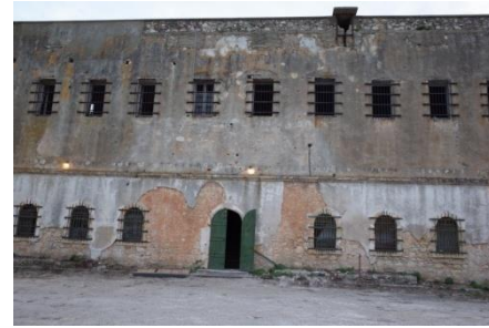
Εικόνα 164: Απώλεια υλικού λόγω κρυπτοεξάνθησης
