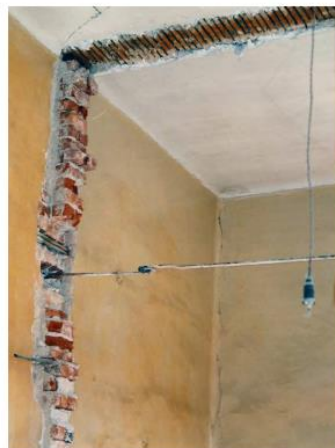
Εικόνα 183: αριστερά: Διαμόρφωση, γωνιακή σύνδεση και ακραία αγκύρωση μεταλλικού διαζώματος – ελκυστήρα, δεξιά: Μεταλλικός ελκυστήρας μορφής λεπίδας [26]
