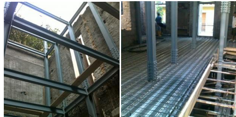
Εικόνα 230: Ενίσχυση κτιρίου στα Εξάρχεια - τοποθετήθηκε νέος μεταλλικός σκελετός εσωτερικά.
