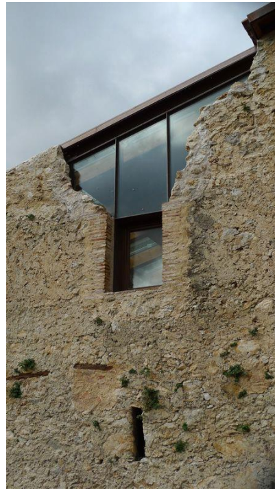
Εικόνα 237: σύνδεση παλιάς πέτρινης όψης με τη νέα μεταλλική κατασκευή
