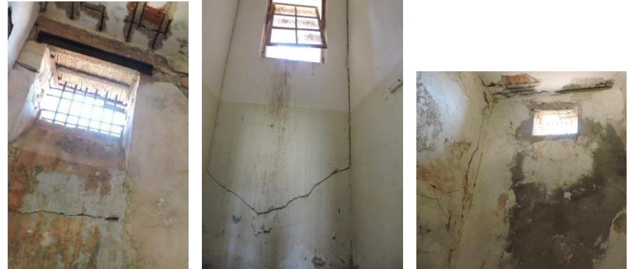
Εικόνα 151: ρηγματώσεις στο εσωτερικό του κτηρίου
