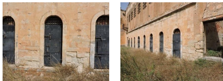
Εικόνα 53: Εξωτερική όψη φέρουσας τοιχοποιίας ισογείου
