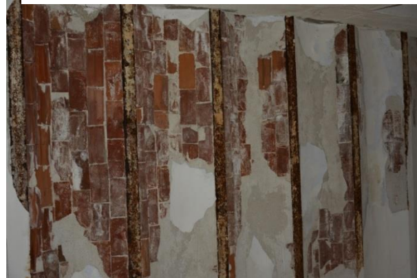
Εικόνα 55: Τομή - Λεπτομέρεια πλάκας οροφής ισογείου
