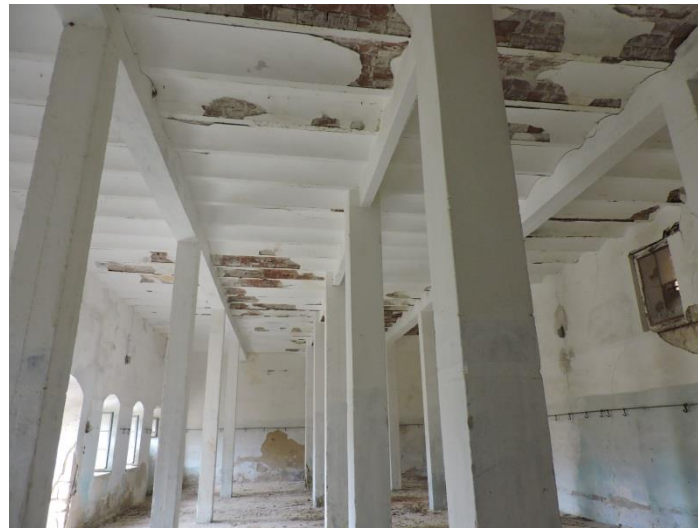
Εικόνα 59: σύστημα υποστυλωμάτων-δοκων στο ισόγειο της ανατολικής πτέρυγας
