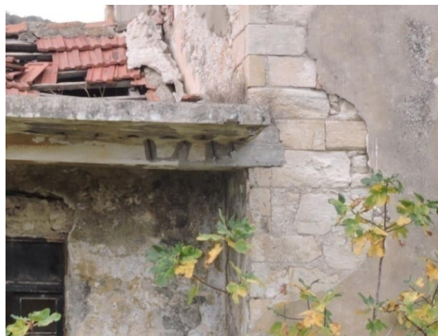
Εικόνα 108: σημείο "επαφής" κεντρικού τμήματος με την προϋπάρχουσα κατασκευή
