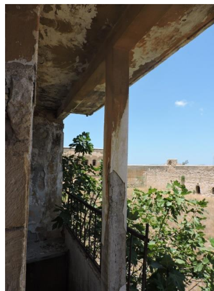
Εικόνα 110: δοκάρι και υποστυλώματα στον όροφο
