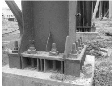
Εικόνα 227: εικόνες από κόμβους μεταλλικών διατομών
