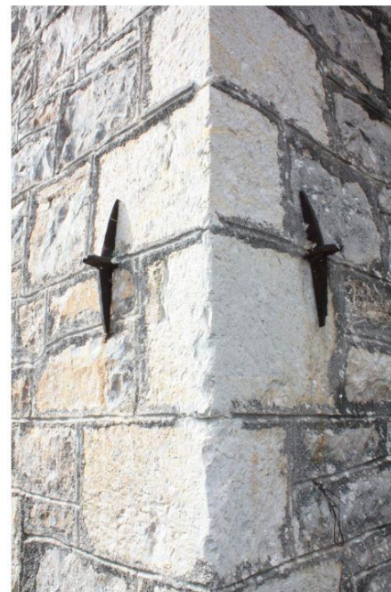
Εικόνα 185: μεταλλικοί ελκυστήρες, όπως φαίνονται στην εξωτερική όψη τοιχοποιίας
