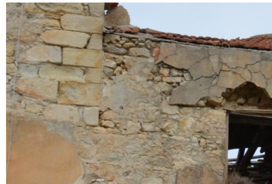
Εικόνα 103: σημείο επαφής κεντρικού τμήματος με την προϋπάρχουσα κατασκευή, εμφανής η διαφορά στο είδος της λιθοδομής
