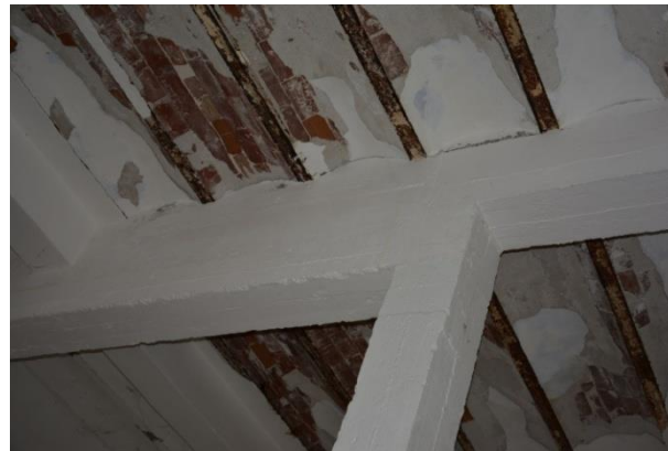
Εικόνα 56: Πλάκα οροφής ισογείου. Το κονίαμα επικάλυψης έχει φύγει και μπορούμε να δούμε τον τρόπο δομής της πλάκας
