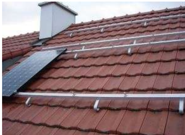
Εικόνα 2.4: Στήριξη Φ/Β σε ράγες
