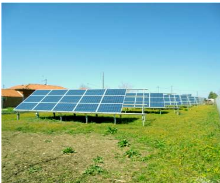
Εικόνα 2.6: Στήριξη Φ/Β στο έδαφος
