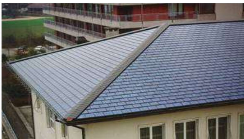
Εικόνα 2.1: Ενσωματωμένο Φ/Β σε οροφή κτιρίου
