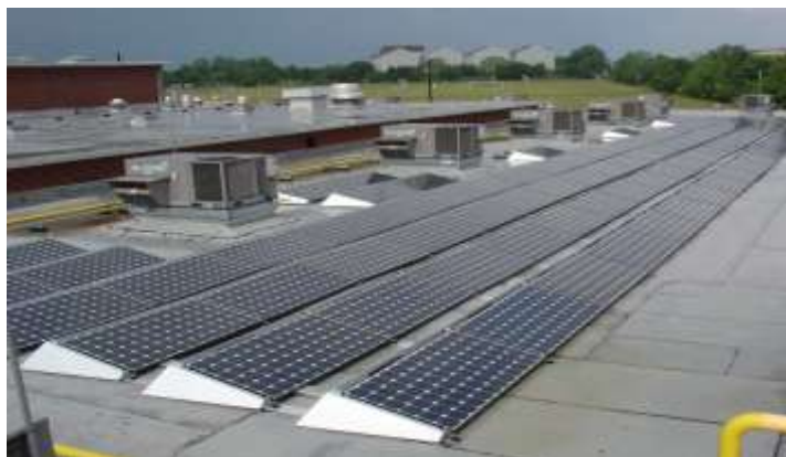
Εικόνα 2.5: Στήριξη Φ/Β σε βάση
