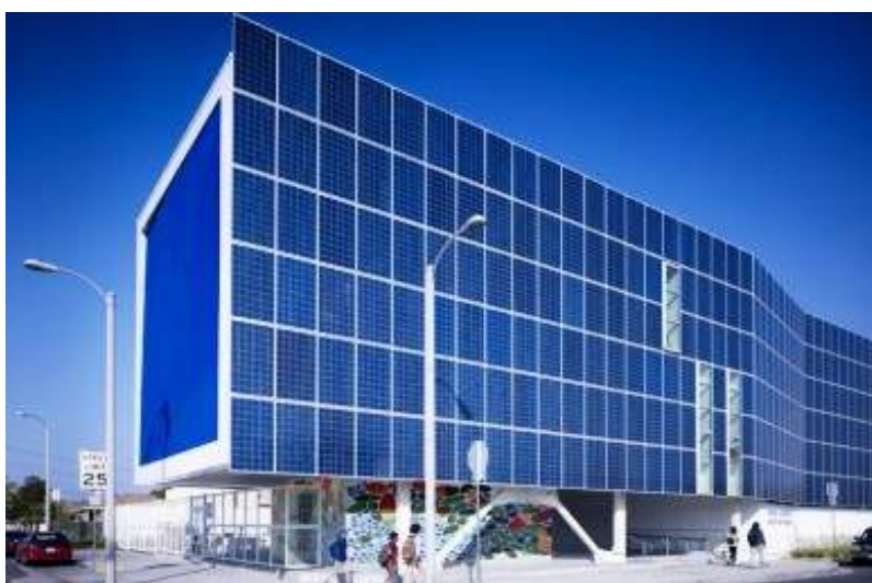
Εικόνα 2.2: Ενσωματωμένο Φ/Β σε οροφή κτιρίου
