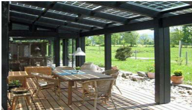
Εικόνα 2.3: Ενσωματωμένο Φ/Β ως σκίαστρο κτιρίου
