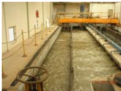
Εικόνα 1. 2: Δεξαμενή εξάμμωσης (Πηγή: ΔΕΥΑΧ)
