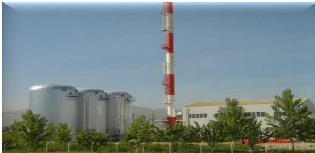
Εικόνα 4.6: Δεξαμενές αποθήκευσης θερμικής ενέργειας - Κεντρικό αντλιοστάσιο Δ.Ε.ΤΗ.Π [24].
