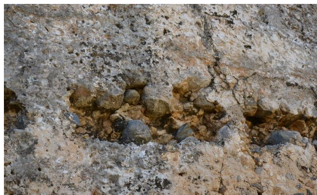
11. διάσπαση στην κορυφή του νότιου τοίχου (εσωτερική όψη)
