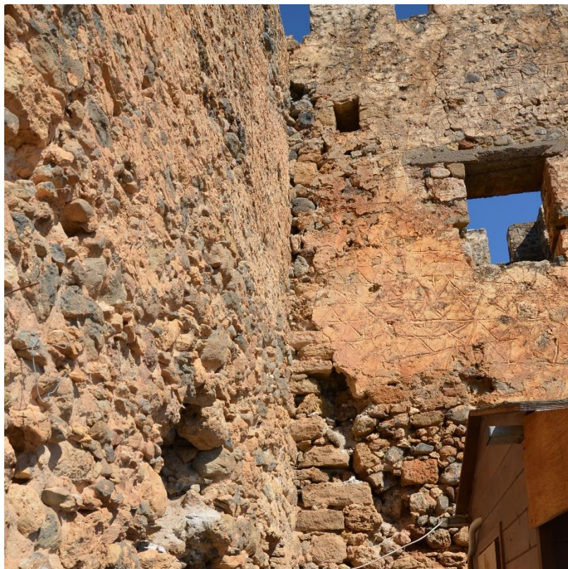
9. διάσπαση της τοιχοποιίας στην νότια πλευρά του ΒΑ πύργου
