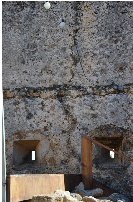
7. εγκάρσια ρωγμή στον Ανατολικό τοίχο (εσωτερική όψη)
