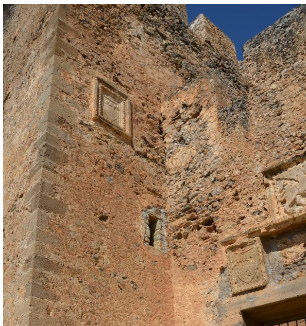
12. διάσπαση τοιχοποιίας στην περιοχή σύνδεσης με τον νότιο τοίχο και τον ΝΔ πύργο
