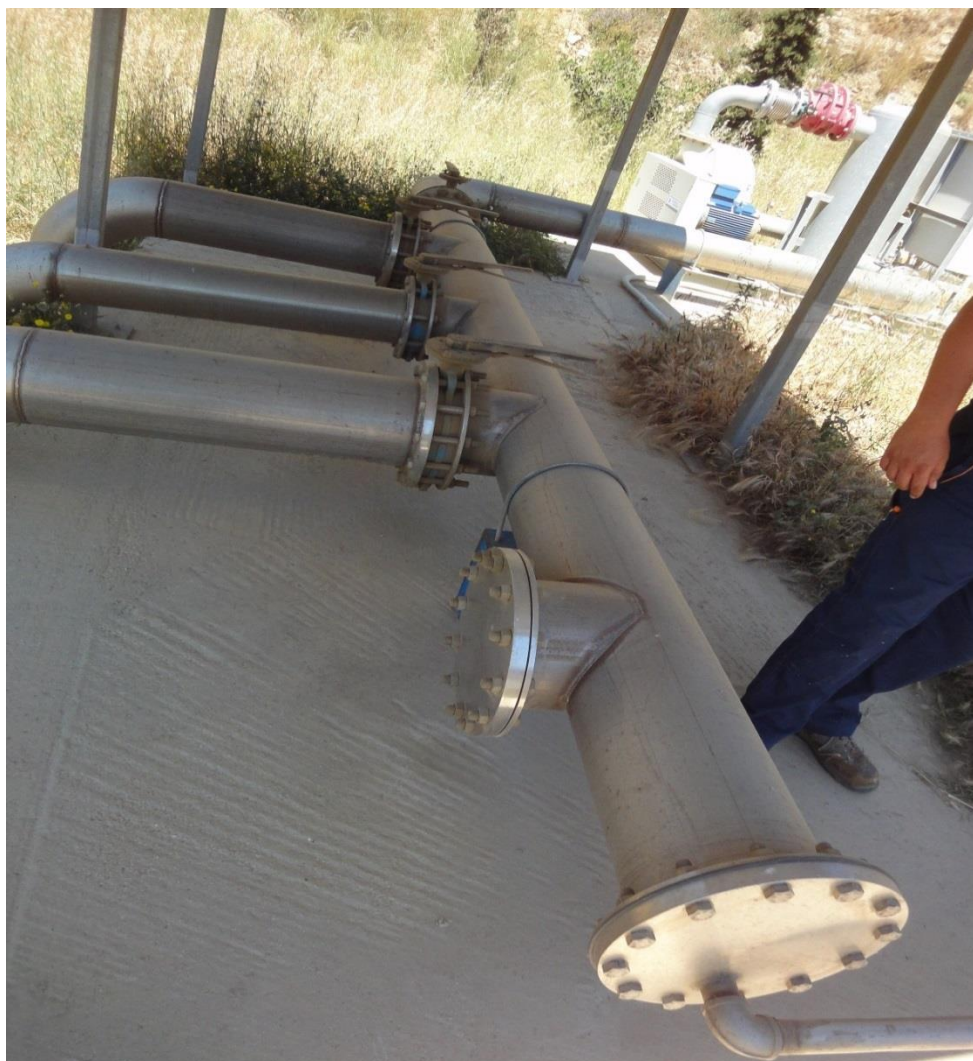
Εικόνα 3.2: Σημείο συνάντησης των τριών ρευμάτων βιοαερίου για τη μεταφορά τους στον πυρσό καύσης
