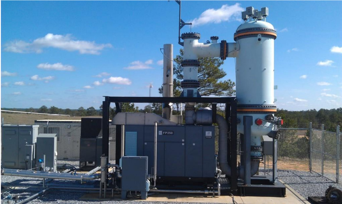
Εικόνα 2.8: Σταθμός Παραγωγής GO 250 kW “Ener-Core FP250” (ENER-CORE, 2017)
