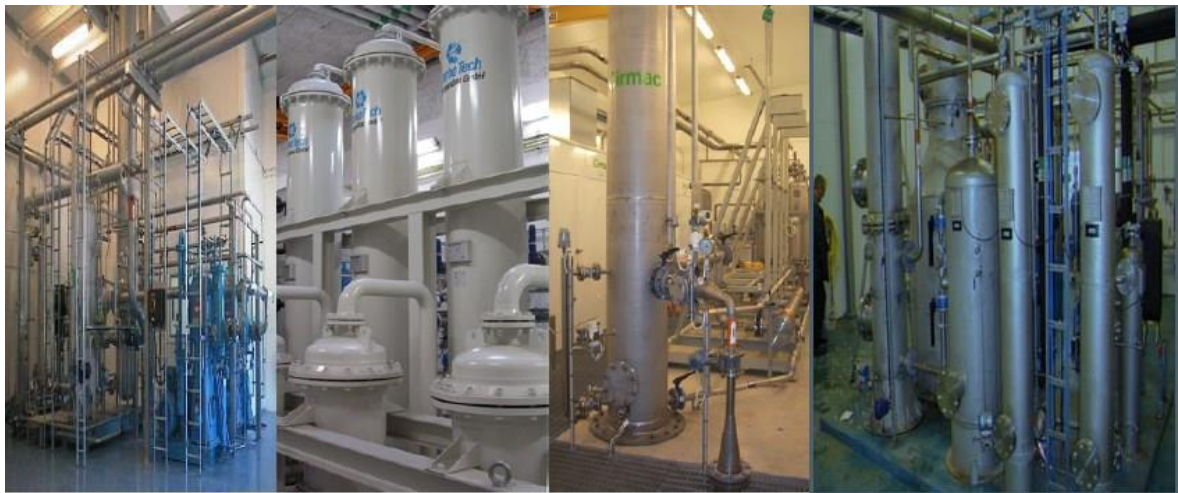
Εικόνα 1.8: Μονάδες αναβάθμισης βιοαερίου στη Σουηδία (Πηγή: Swedish Gas Center)
