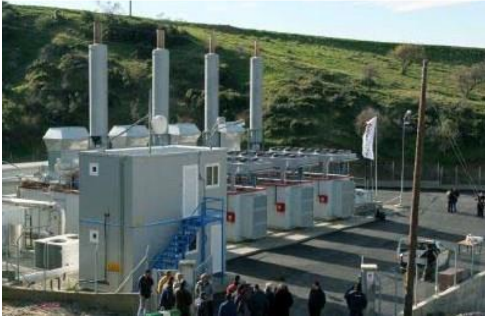
Εικόνα 1.3: Μονάδα βιοαερίου στο ΧΥΤΑ Ταγαράδων εγκατεστημένης ισχύος 5 MW (Πηγή: ΗΛΕΚΤΩΡ Α.Ε.)
