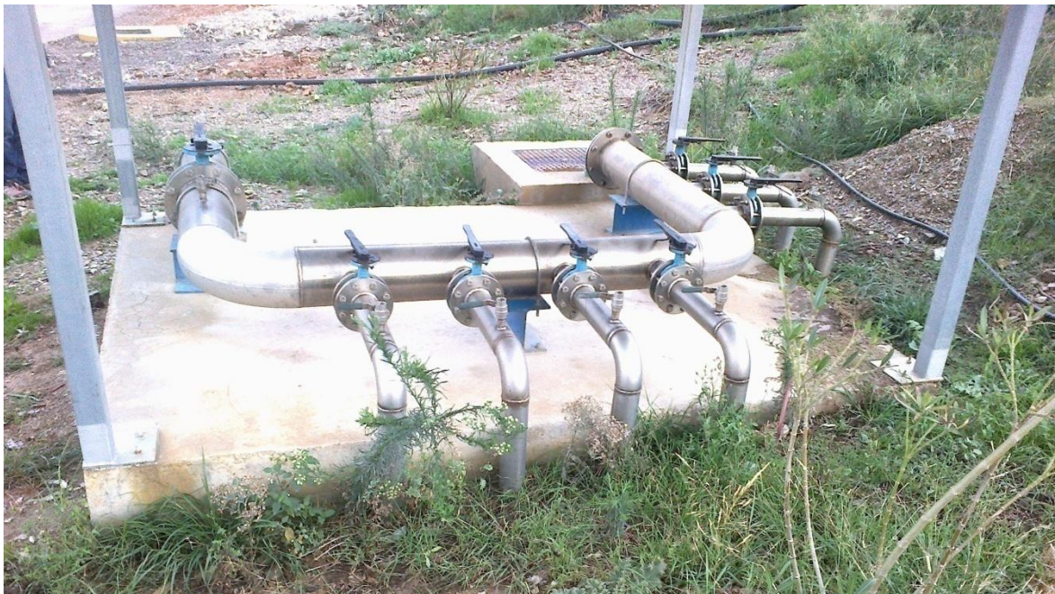
Εικόνα 3.4: Υποσταθμός συλλογής βιοαερίου (ΥΠ1)
