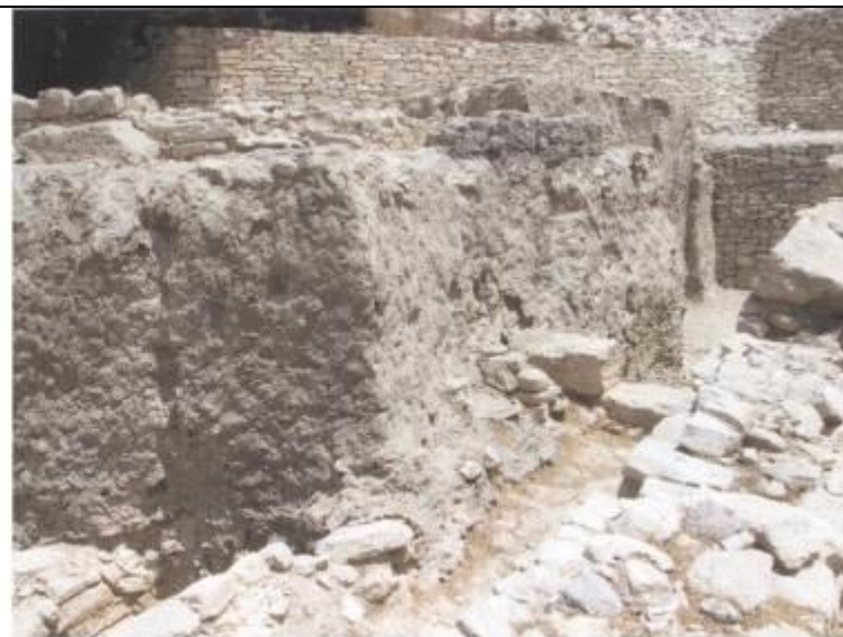
Άσκαφες επιχώσεις για την προστασία ανώτερων οικοδομικών φάσεων: τα πρανή έχουν επενδυθεί με επιφανειακή 'πέταχτη' τσιμεντοκονία.
