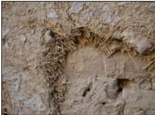
Εικόνα 46_ Πηλοκονίαμα, Ισπαχάν, Ιράν.
