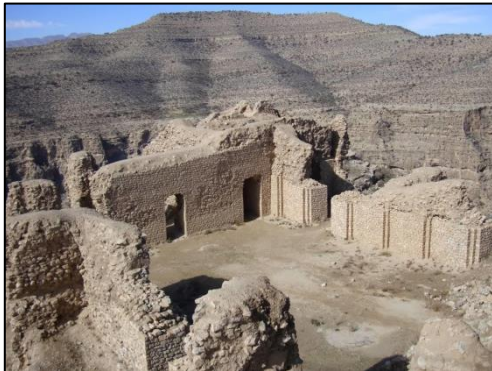
Εικόνα 43_Ghaleh Dokhtar, Iran, 209 μ.Χ. Κατασκευή με πολύ ανθεκτικά γυψοκονιάματα
