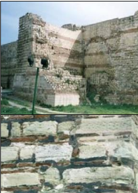
Εικόνα 80_Ευρεία χρήση τσιμεντοκονιαμάτων αποκατάστασης Βυζαντινού τείχους Κωνσταντινούπολης.
