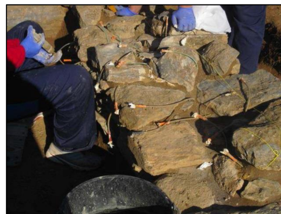
Εικόνα 79_Ιερό του Διονύσου, Αρχαία Μαρώνεια. Διαδικασία αρμολόγησης τοιχίων θεμελίωσης κατασκευάζοντας ένα τοπικό σκληρό ασβεστόλιθο και ένα συνδετικό κονίαμα με βάση τη γη.
