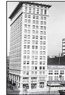
Εικόνα 67_Κατασκευή του πρώτου ουρανοξύστη από οπλισμένο σκυρόδεμα, ύψους 64 μ. στο Σινσινάτι, Οχάιο, 1903.
