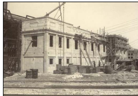
Εικόνα 69_Κεντρικός ηλεκτρικός σταθμός Αγ.Γεωργίου από σκυρόδεμα, Κεραιτσίνι(1926-29). Με τη λειτουργία του σταθμού ξεκίνησε η παραγωγή ρεύματος υψηλής τάσης(τριφασικό) στην Ελλάδα.
