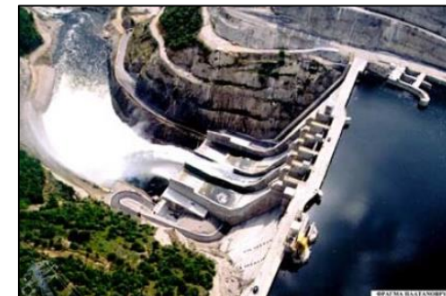
Εικόνα 70_Το φράγμα της Πλατανόβρυσης(1995-97) από κυλινδρικό σκυρόδεμα με 82% Ιπτάμενη τέφρα Πτολεμαΐδας και 18% τσιμέντο PortlandCEMI-42.5. Αποτελεί το ψηλότερο Ευρωπαϊκό RCCφράγμα(95μ.).
