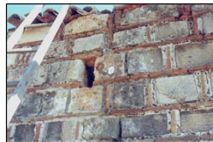
Εικόνα 71_Έξεργα κονιάματα δόμησης για την προστασία των ακμών των λίθων, Ι.Μ.Δαφνίου.
