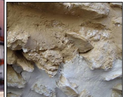
Εικόνα 52_Επάλψη γυψοκονιάματος με πηλό για απόκτηση κατάλληλου χρώματος.
