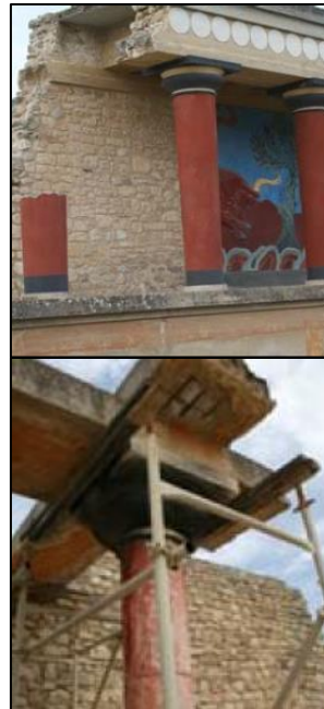
Εικόνα 81_Ευρεία χρήση οπλισμένου σκυροδέματος και τσιμεντοκονιαμάτων στο Ανάκτορο της Κνωσού από τον Evans (1900-13, 1922-30).
