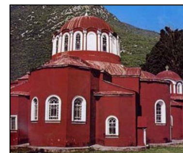
Εικόνα 62_Το καθολικό της Μεγίστης Λαύρας, Άγιο Όρος, επιχρισμένο με κουρασάνι (υψηλή συγκέντρωση σε κεραμάλευρο και θραυστά κεραμικά) αποδίδει υψηλή ανθεκτικότητα και ερυθρό χρώμα.
