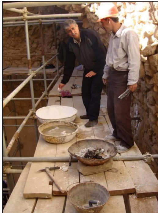
Εικόνα 50_Κατασκευή γυψοκονιαμάτων για εφαρμογή στο μνημείο.
