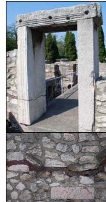
Εικόνα 82_Χρήση οπλισμένου σκυροδέματος και τσιμεντοκονιαμάτων αρμολόγησης σε τμήματα του ρωμαϊκού οικισμού Aquincum, Βουδαπέστη(1ος αι. μ.Χ.).
