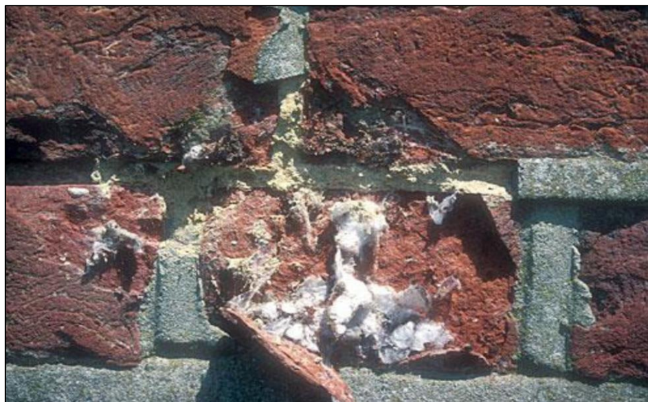
Εικόνα 44_Ασυμβατότητα τσιμεντοκονιαμάτων και πορωδών δομικών υλικών. Τα τσιμεντοκονιάματα, διοχέτευαν τα άλατα που περιέχουν προς την πορώδη δομή των πλίνθων με αποτέλεσμα την αποκόλληση τμημάτων.
