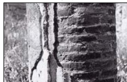
Εικόνα 73_Τριπλή στρώση επιχρίσματος σε κίονα από οπτοπλινθοδομή, Πομπηία.
