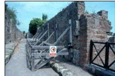
Εικόνα 76_Σκυρόδεμα και χάλυβας, υλικά ασύμβατα με τα ιστορικά, προκάλεσαν φθορές:παρήγαγαν άλατα(κατασκευαστικό
