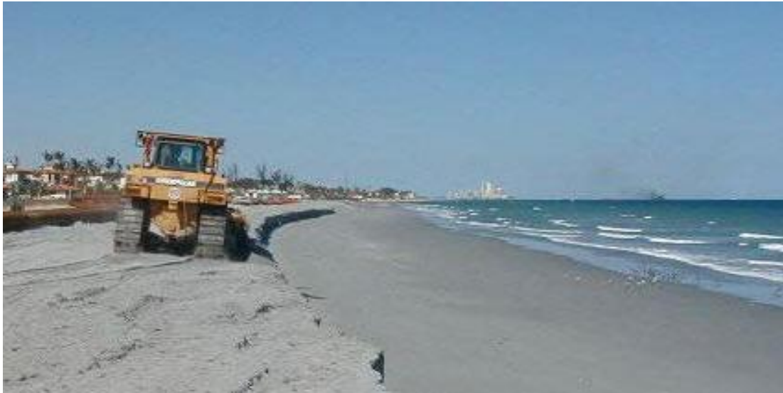
[Εικόνα 23: Επαναφορά παραλίας, beach scraping]
