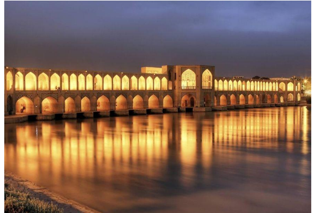
Εικόνα 1.1.3 Το γεφύρι Σεοσεπόλ( που σημαίνει ωραία γέφυρα) στο Εσφαχάν με τα χαρακτηριστικά και ψαλιδωτά τόξα του. ( περσική ψάλις). Γεφυρώνει τον ποταμό Ζαγιαντιέ μέσα στην πόλη. Κατασκευάστηκε το 1650 μ. Χ., έχει συνολικό μήκος 360m και αποτελείται από 33 τόξα
