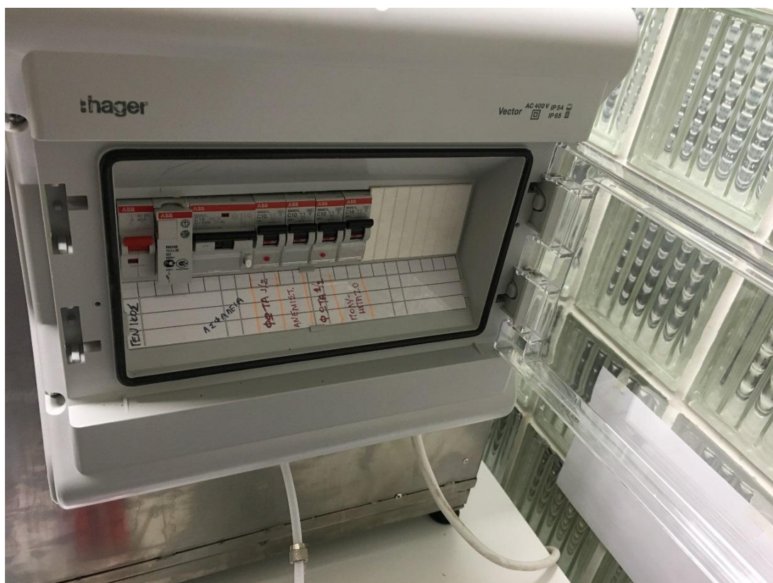
Εικόνα 3.12 Ηλεκτρολογικός πίνακας ελέγχου αλουμινένιου εξωτερικού θαλάμου.
