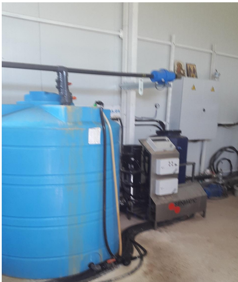
Εικόνα 1.12: Αριστερά απεικονίζεται η δεξαμενή πυκνών θρεπτικών διαλυμάτων και δεξιά ο υπολογιστής παρασκευής θρεπτικών διαλυμάτων, στο θερμοκήπιο της Βιράν Επισκοπής, Ν. Ρεθύμνου.
