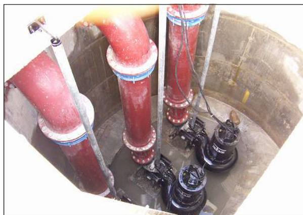
Σχήμα 1.10: Τυπική υποβρύχια εγκατάσταση αντλιών μεταφοράς (Το επάνω κάλυμμα έχει αφαιρεθεί ) [Environment Agency, 2012]
