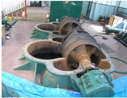
Σχήμα 1.8: Μεγάλη ακτινική εγκατάσταση διπλής ροής σε αντλιοστάσιο όμβριων νερών (Το επάνω περίβλημα έχει αφαιρεθεί) [Environment Agency, 2012]
