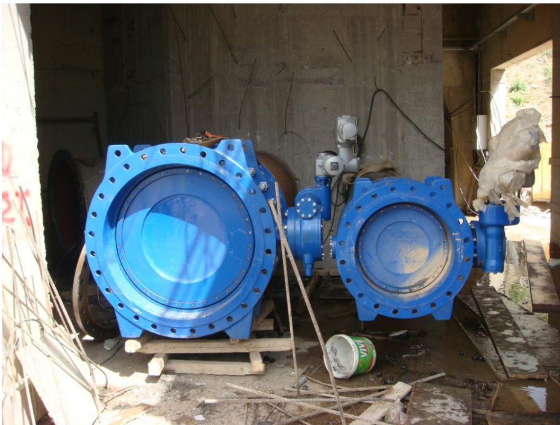
Εικόνα 3.5 : Οι βαλβίδες εκτόνωσης πίεσης Howell-Bunger DN900 και DN500.
