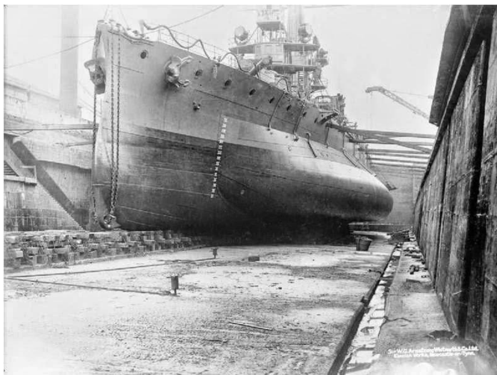
Εικόνα 2.4 Φωτογραφία πλευρικού αντιτορπιλικού στεγανού (anti-torpedo bulge/blister) παλαιού πλοίου επιφανείας των αρχών του 20ου αιώνα. ( http://www.navsourc.org/ )
