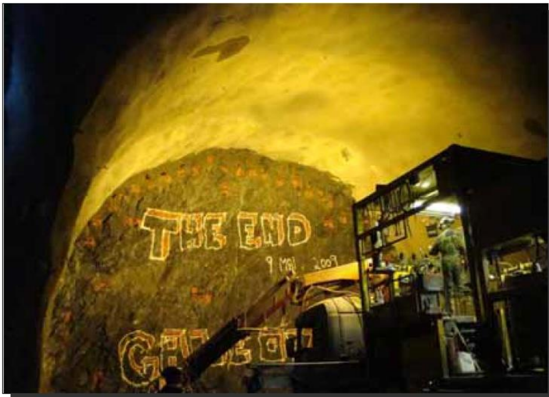
Τελική φάση σήραγγας χωρίς την παρουσία υπόγειων νερών σε προ-ενεματομένους σχιστόλιθους που κατασκευάστηκε με κόστος μικρότερο των 18,500 €/m (Barton, 2011 1 ).
