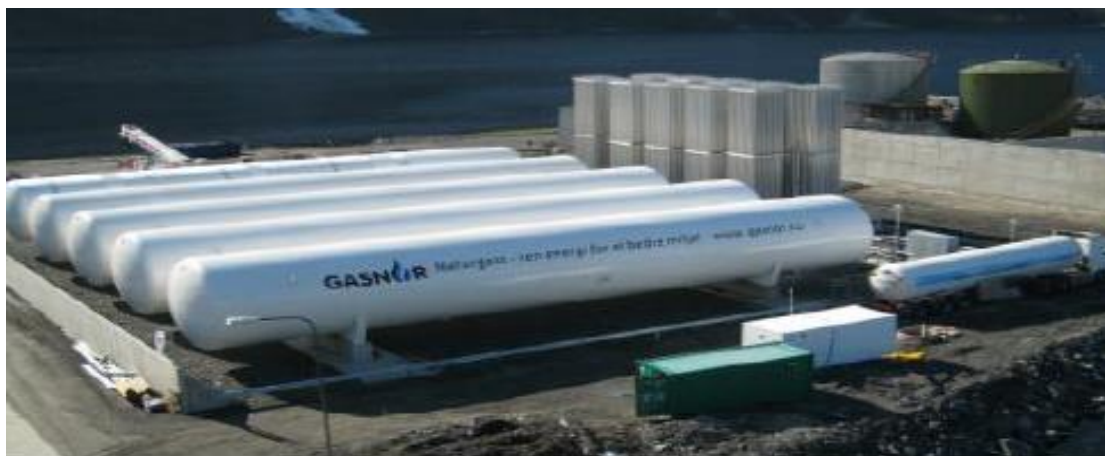
Εικόνα 7. Τερματικός Σταθμός LNG στο Mosjoen της Νορβηγίας (5x683m 3 δεξαμενές συμπίεσης) [23]
