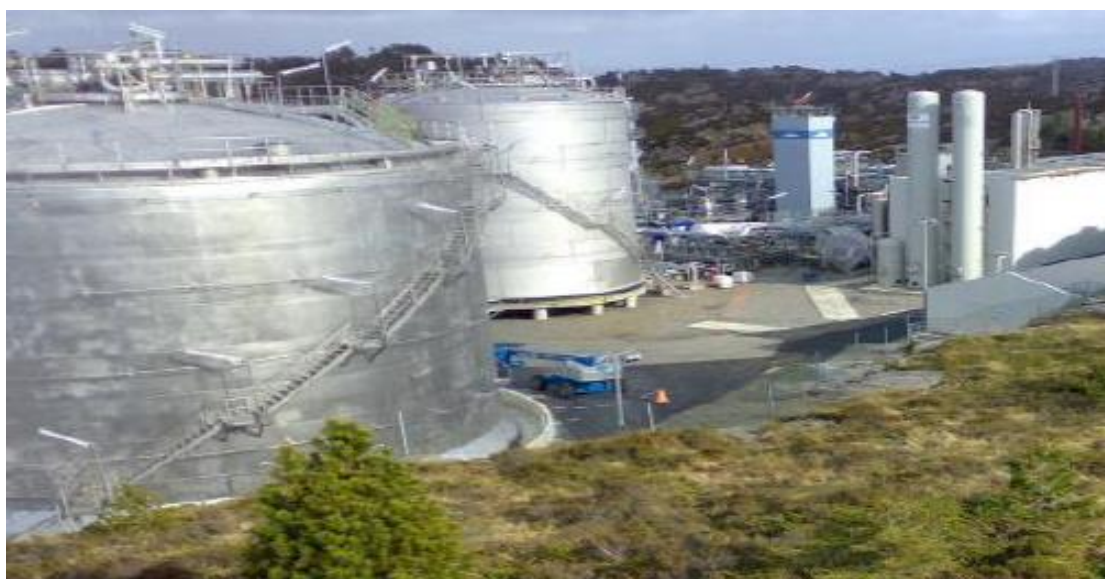
Εικόνα 8. Ατμοσφαιρικές Δεξαμενές LNG, χωρητικότητας 4000m 3 και 2000 m 3 αντίστοιχα, στην πόλη Kollsnes της Νορβηγίας [23]
