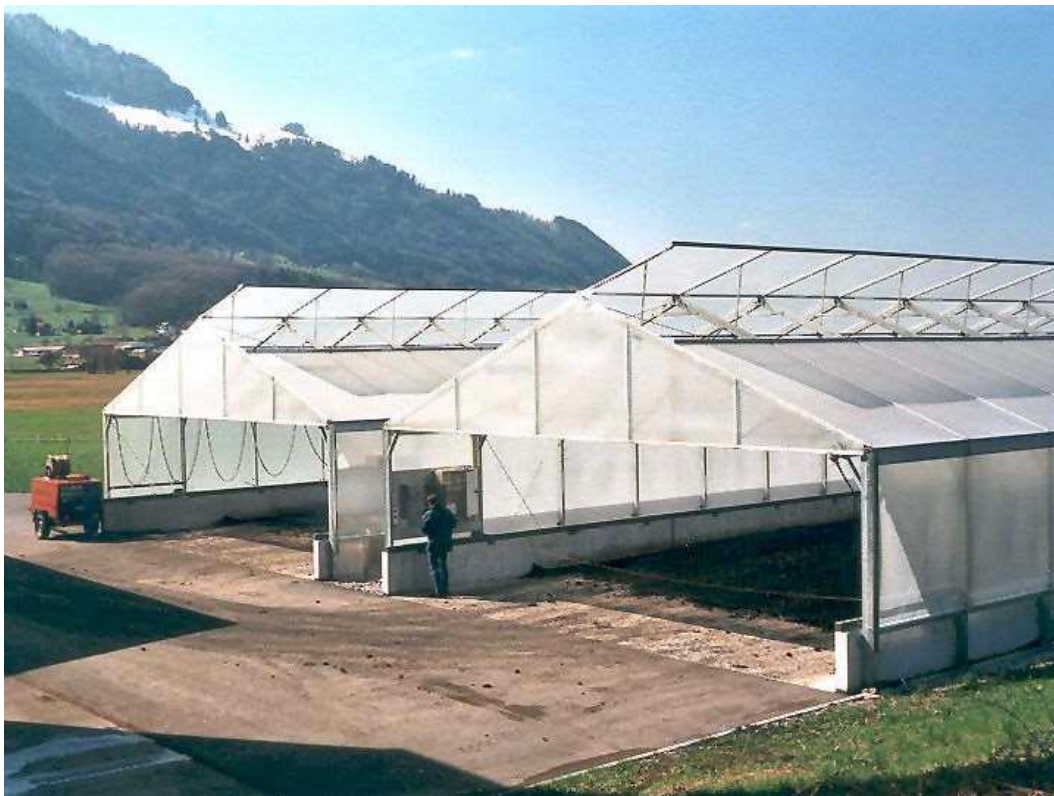
.Εικόνα 1.2.5 Εγκατάστασης ξήρανσης ιλύος με ηλιακή ενέργεια (Switzerland) (Πηγή: http://mesogeos.gr/ )
