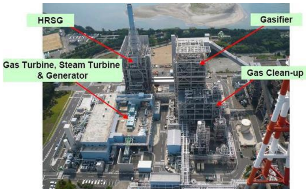
Εικόνα 3.1.4 Εγκατάσταση IGCC (στο Nakoso της Ιαπωνίας) (Πηγή: http://www.mpshq.com , 2016)
