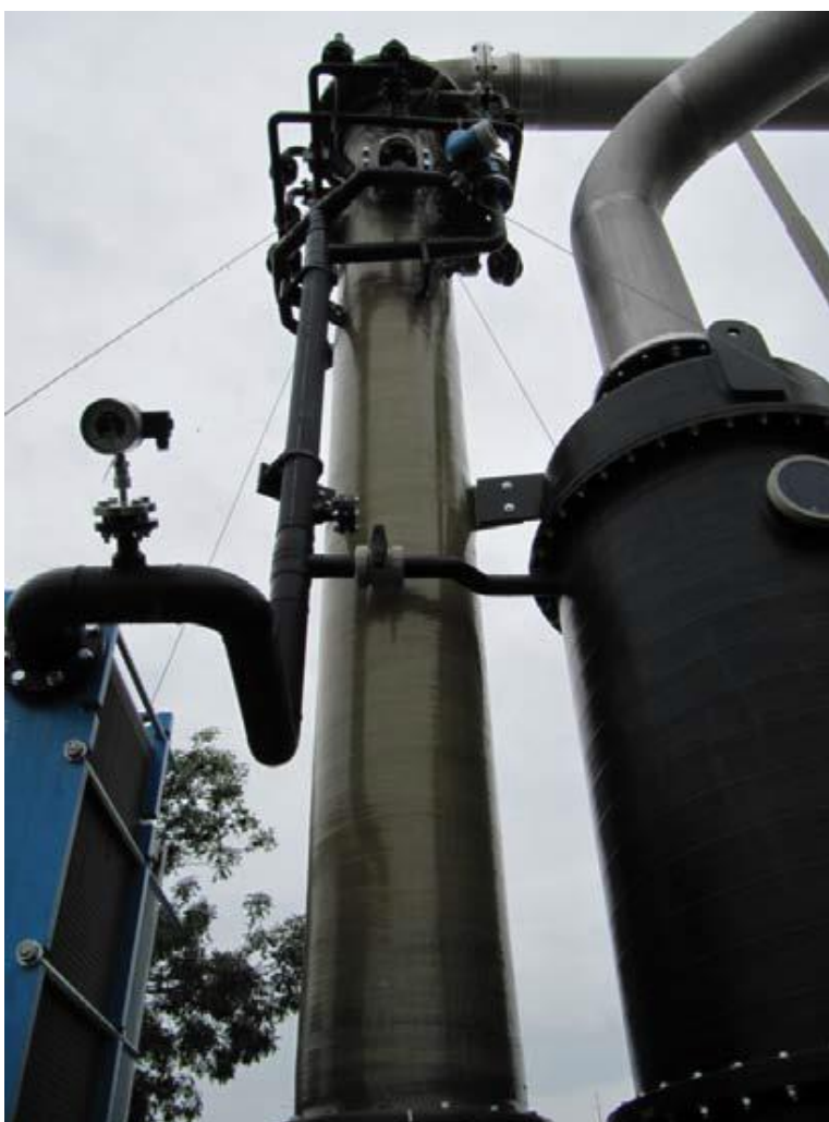
Εικόνα 3.4.1.2 Πύργος καθαρισμού – ψύξης Syngas: (Pyromex) (Πηγή:Gikas, 2013)
